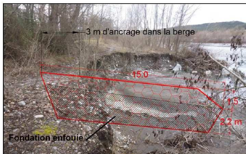
Figure 47 : Représentation schématique d'un épi long
