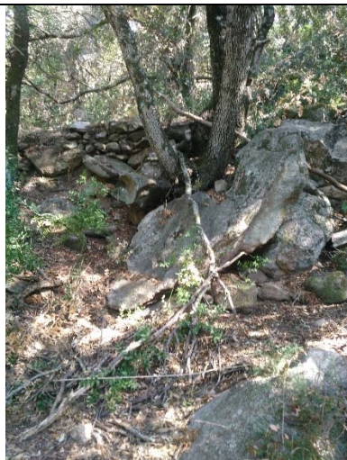
Figure 22 : Terrasse avec enrochement
