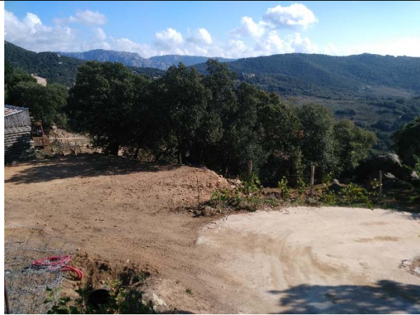
Figure 13 : Aval de la RT40 (aménagement en terrasses en cours)
