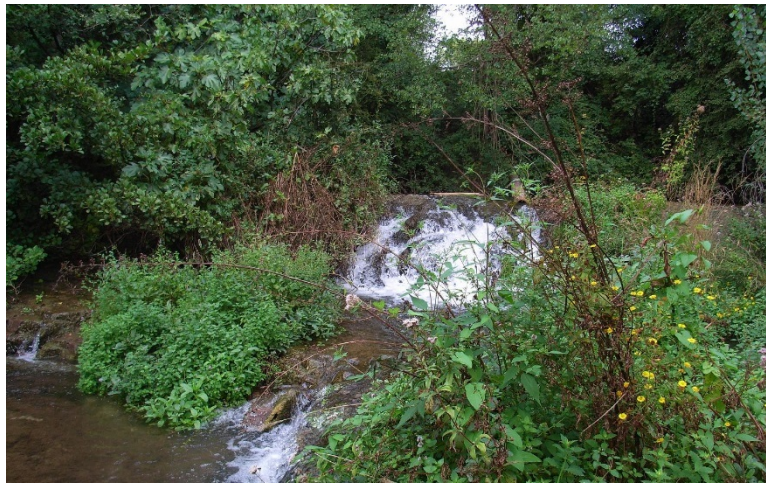
Figure 17 : Déversoir en rive gauche
