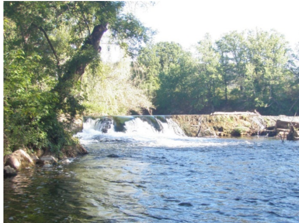
Figure 19 : Seuil principal en rive droite
