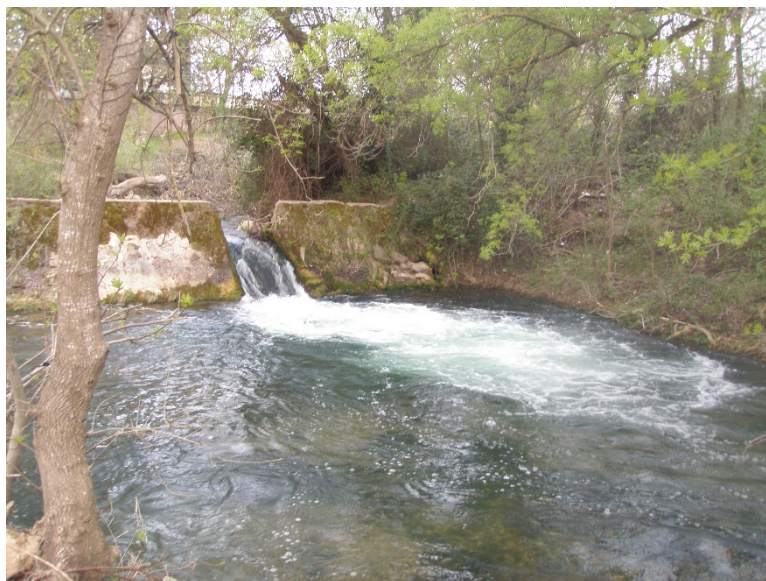
Figure 2 : Seuil annexe en rive droite (pré barrage) – source SCE – mars 2016
