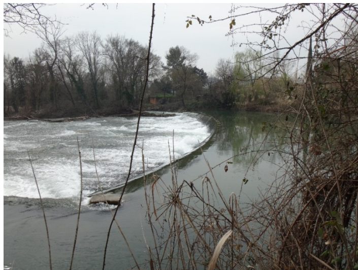
Figure 1 : Vue sur le seuil des Plainons depuis la rive gauche – source FVPPMA – mars 2015
