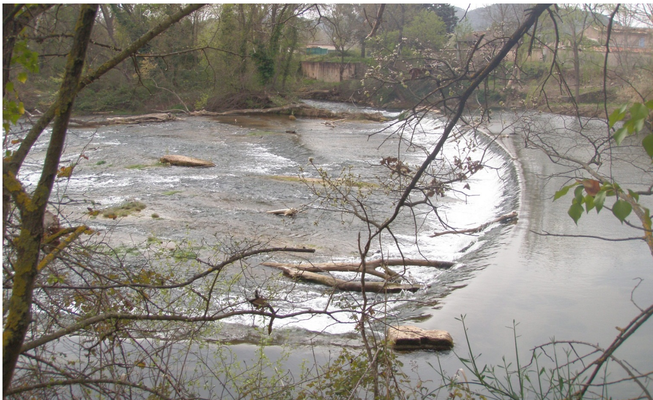
B - Vue du barrage depuis l'ancien canal d'aménagé du moulin, vers l'aval
