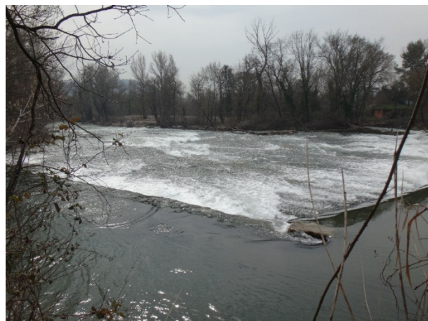
Figure 20 : Seuil principal en hautes eaux
