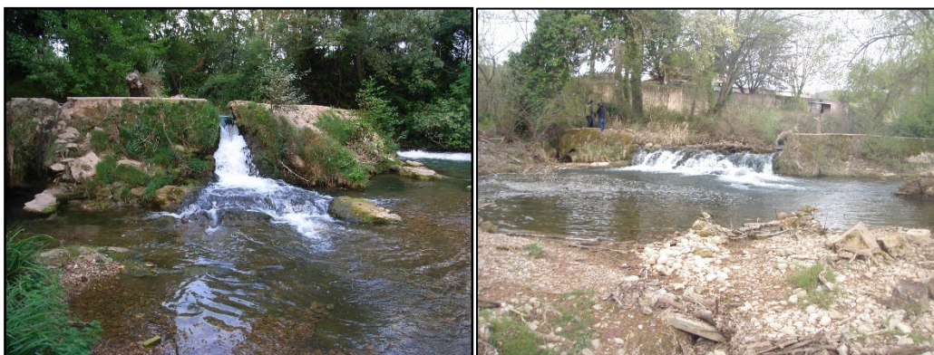
Figure 39 : Evolution du seuil aval en rive droite entre 2006 et 2016 (source : MRM et SCE)
