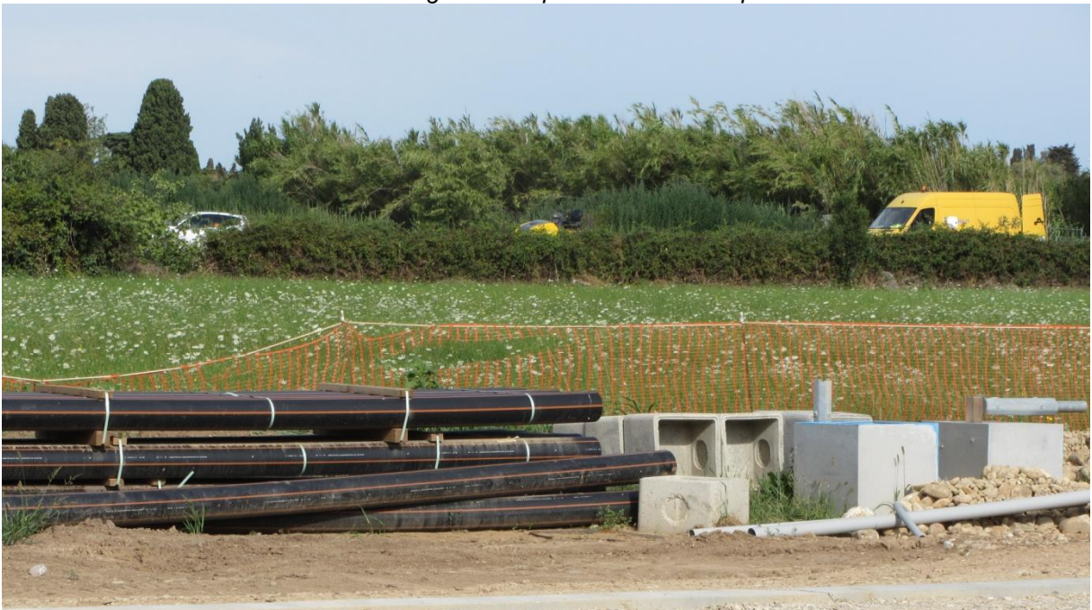
Chantier de la ZAC de la Péronne - août 2016 – prairie / chantier
