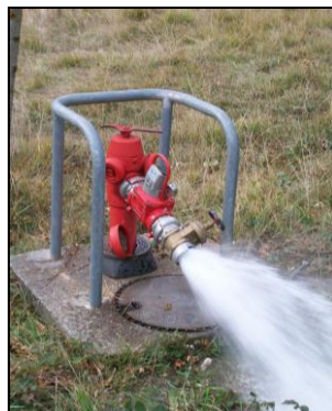
Mesure d'un poteau incendie
