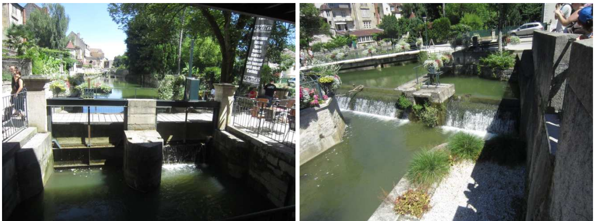
Fig. 27. Ouvrage du canal des tanneurs vu de l'aval (Vannes en rive droite et déversoir en rive gauche)
