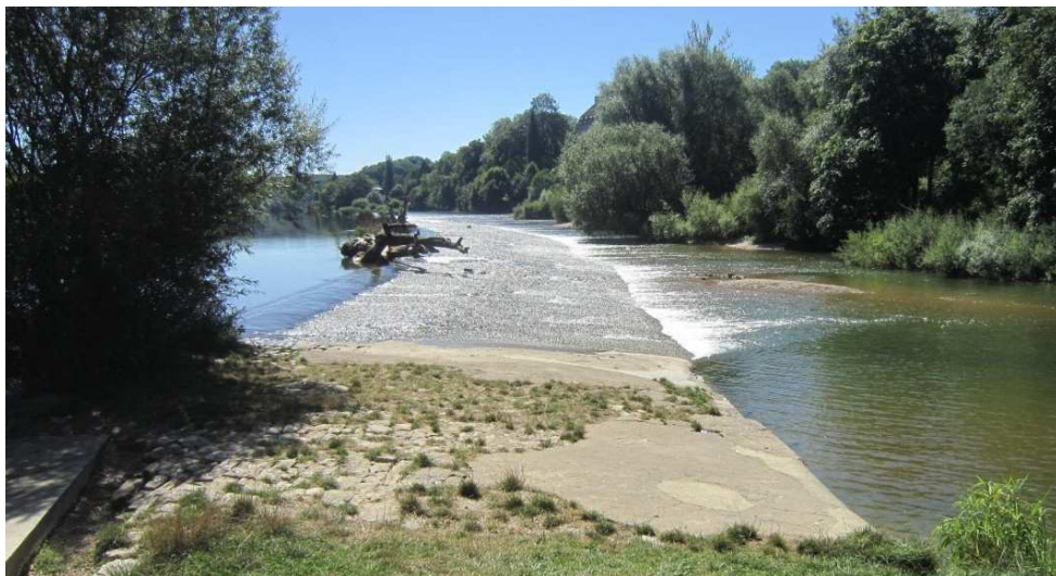
Fig. 25. Barrage d'Azans vu depuis la rive droite
