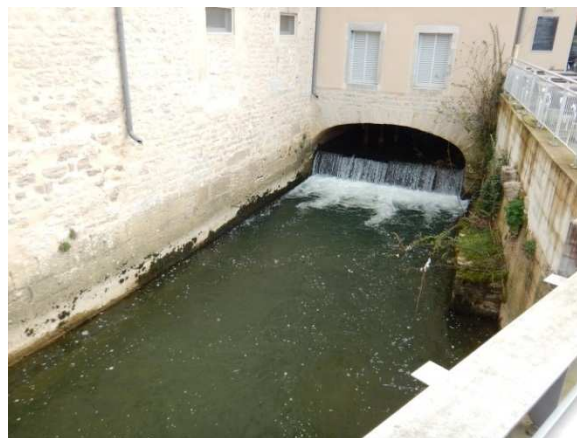
Fig. 16. Photo du canal usinier passant sous le Moulin des Ecorces
