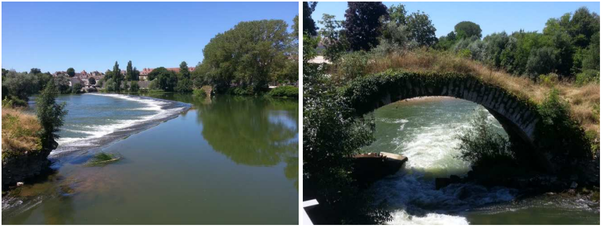
Fig. 30. Barrage du moulin Brindel (gauche) et passe en rive gauche (droite)
