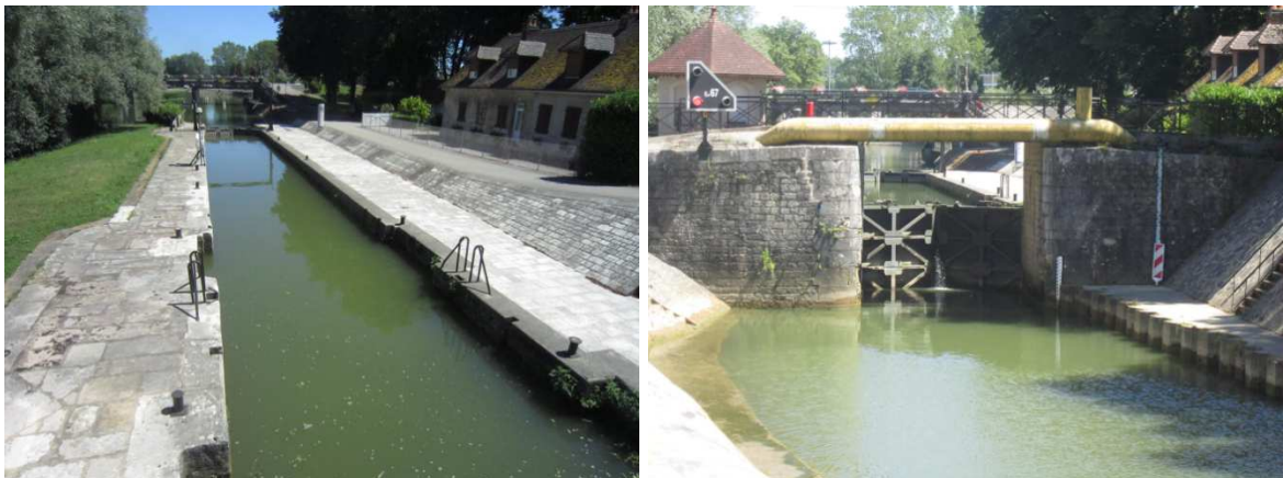
Fig. 29. Ecluse de Dole
