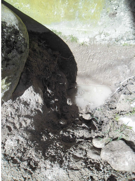
Aperçu de la fouille manuelle (20/03/2014)
