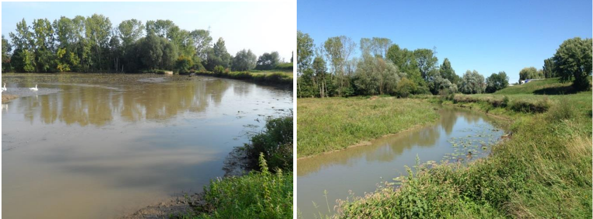
Fig. 12. Tronçon de la Corne en amont du clapet (clapet en position haute à gauche et en position basse à droite)
