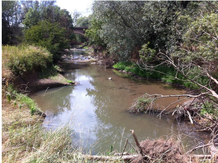
Fig. 11. Tronçon en aval de la voie de chemin de fer
