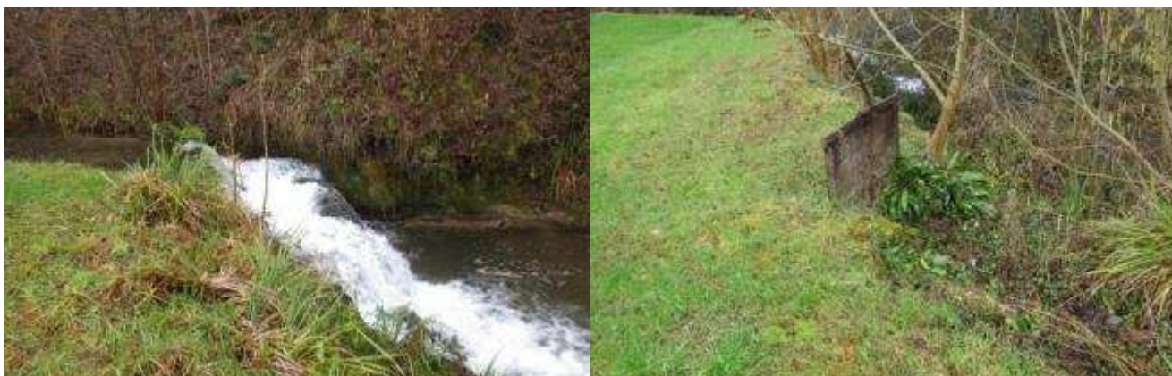
Ancien seuil de prise d'eau et vannage sur le Truison alimentant l'ancien bief aval (Truison)
