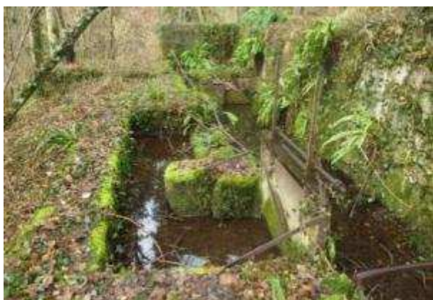
Ancienne prise d'eau pour l'alimentation d'une conduite forcée sur le Truison amont
