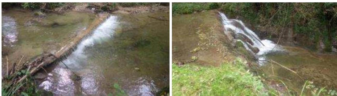
Figure 21 : Exemple de seuil de stabilisation du profil à gauche et seuil infranchissable à droite (Ancien moulin de Mondragon)
