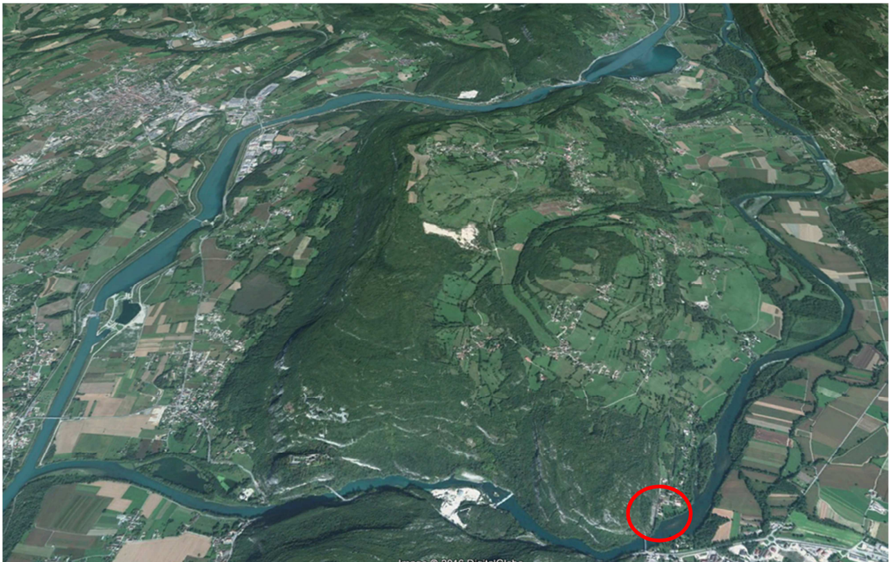
Figure 12 : Localisation du tronçon court-circuité du Haut-Rhône (Lavours) au niveau Yenne (Google Earth)
