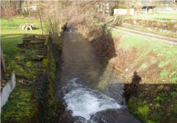
Passage artificialisé de la Méline en aval de la prise d'eau de la Petite Méline
