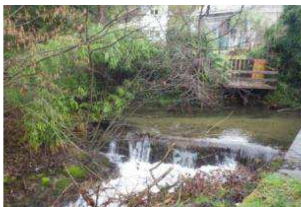
Seuil de prise d'eau de la RN504 (ROE37492)
