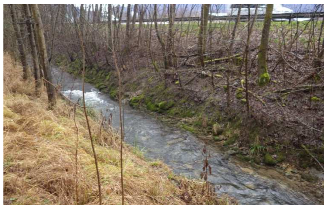
Zone d'incision et de pavage du substrat sur le tronçon rectifié suite aux travaux des années 70-80
