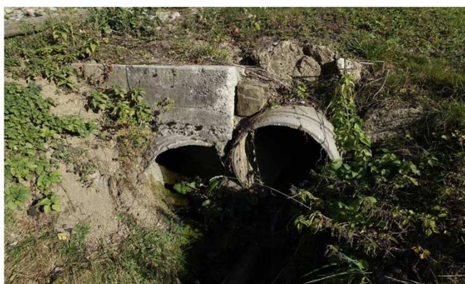
Tête aval de l'ouvrage
