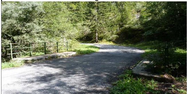
Voirie au dessus de la l'ouvrage
