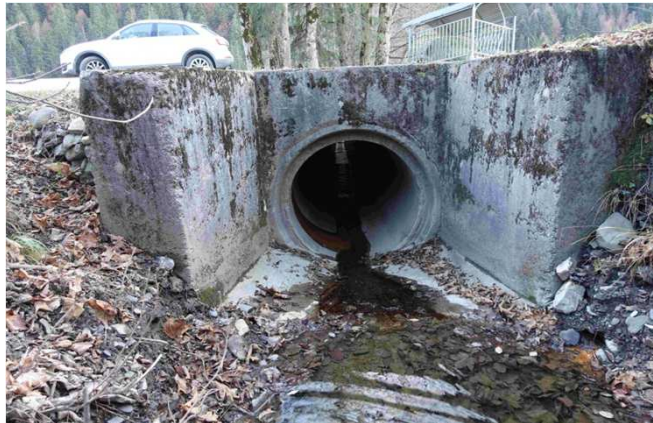
Tête amont de l'ouvrage
