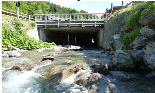
Tête aval de l'ouvrage
