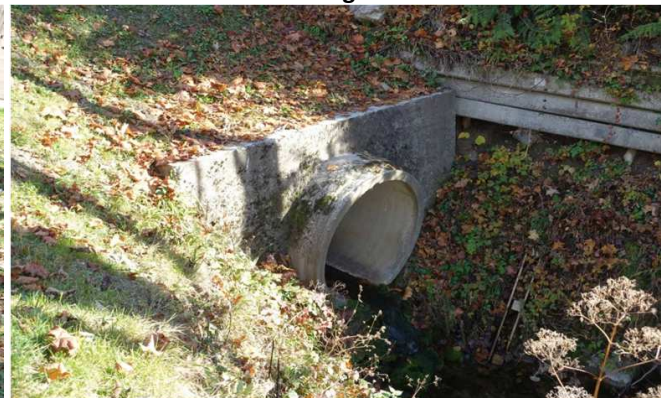
Tête aval de l'ouvrage
