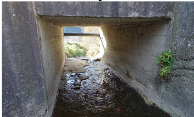
Intérieur de l'ouvrage
