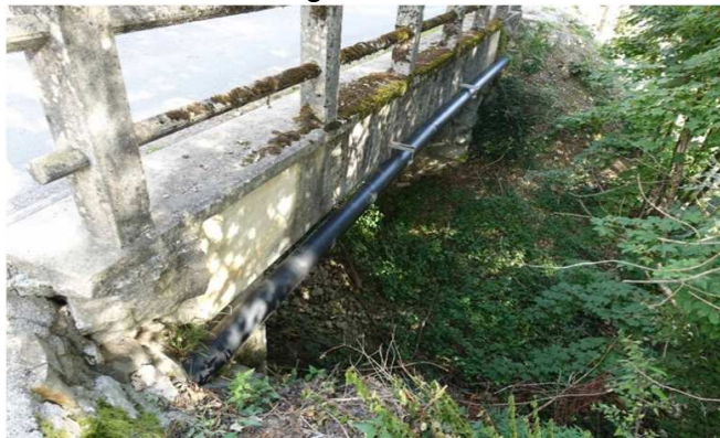
Vue de l'ouvrage
