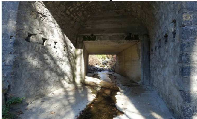
Tête amont de l'ouvrage
