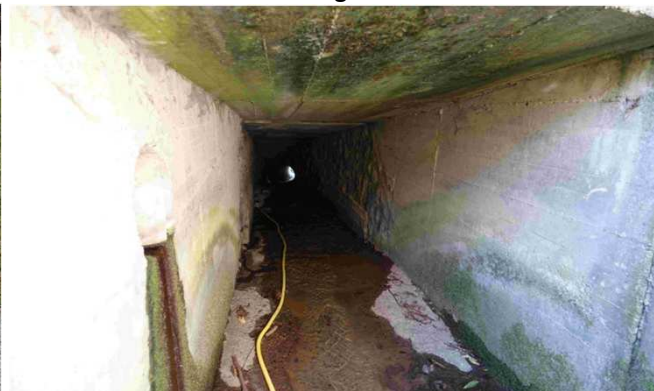
Intérieur de l'ouvrage
