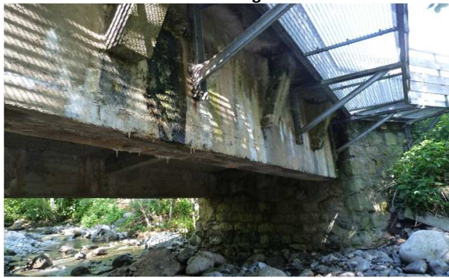
Tête amont de l'ouvrage
