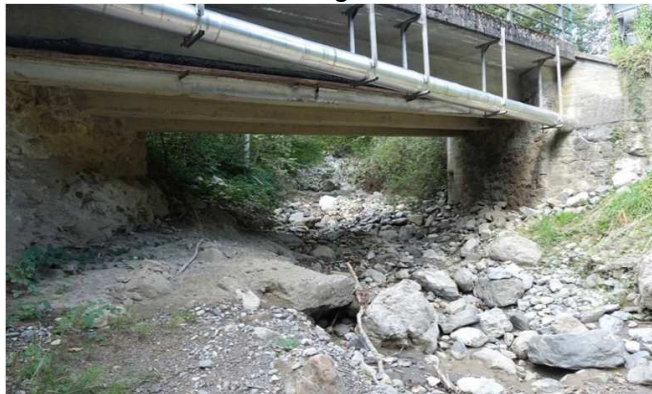
Tête aval de l'ouvrage
