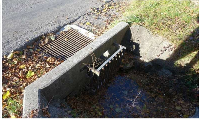
Tête amont de l'ouvrage
