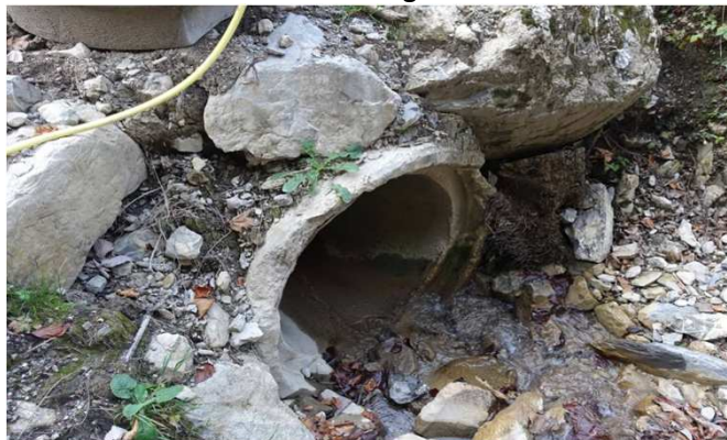
Tête amont de l'ouvrage
