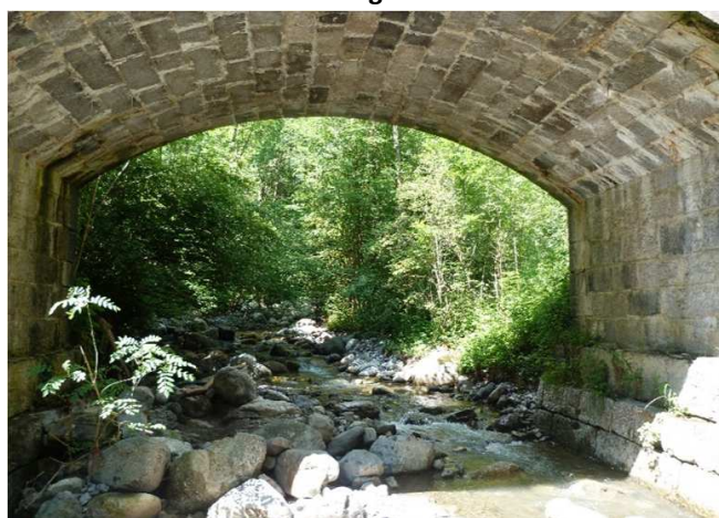
Tête aval de l'ouvrage
