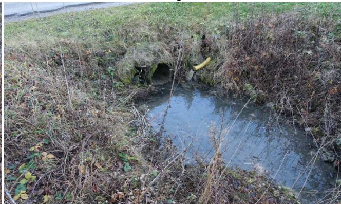
Tête aval de l'ouvrage
