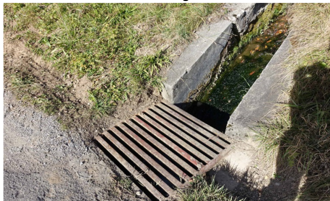
Tête amont de l'ouvrage
