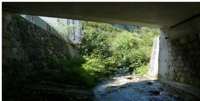
Vue de l'ouvrage
