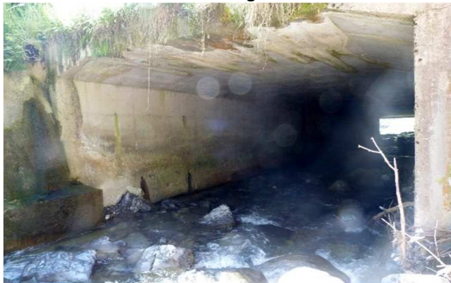
Tête amont de l'ouvrage
