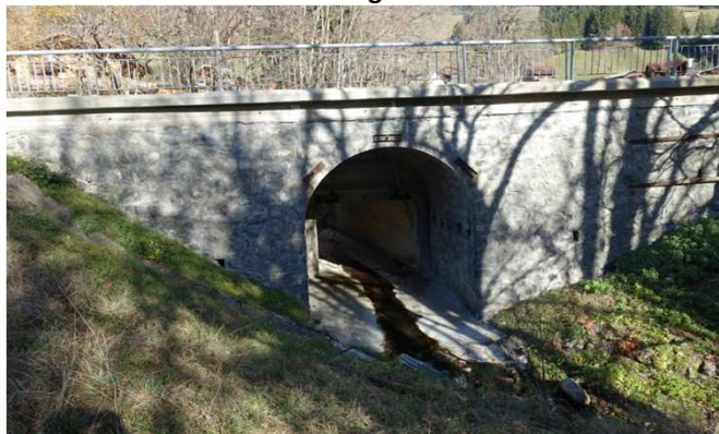
Tête aval de l'ouvrage
