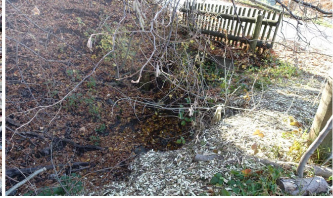
Tête amont de l'ouvrage
