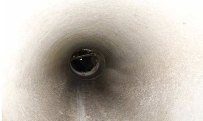
Intérieur de l'ouvrage
