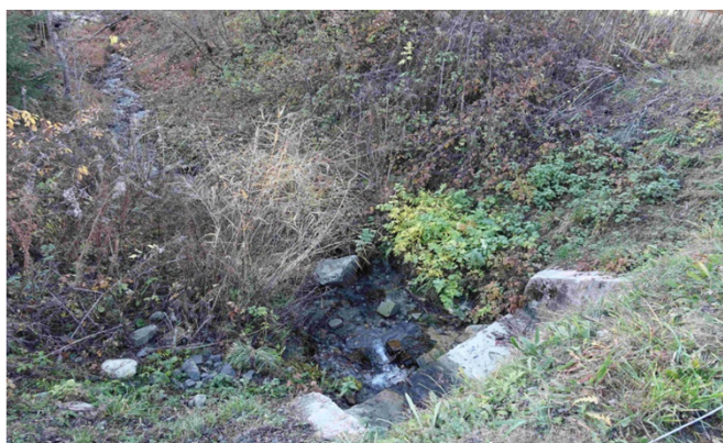
Tête aval de l'ouvrage
