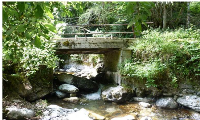
Tête aval de l'ouvrage
