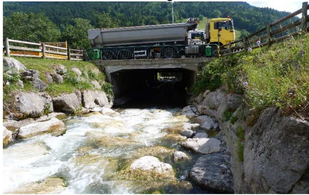
Tête amont de l'ouvrage
