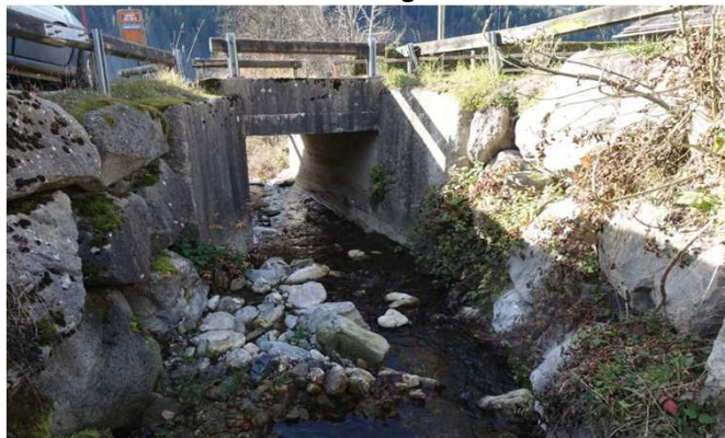
Tête amont de l'ouvrage
