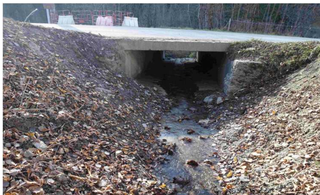
Tête amont de l'ouvrage
