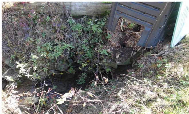
Tête amont de l'ouvrage
