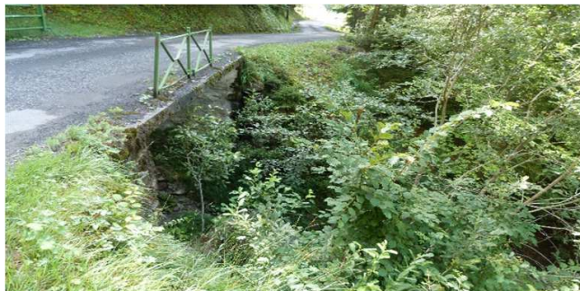
Vue de l'ouvrage
