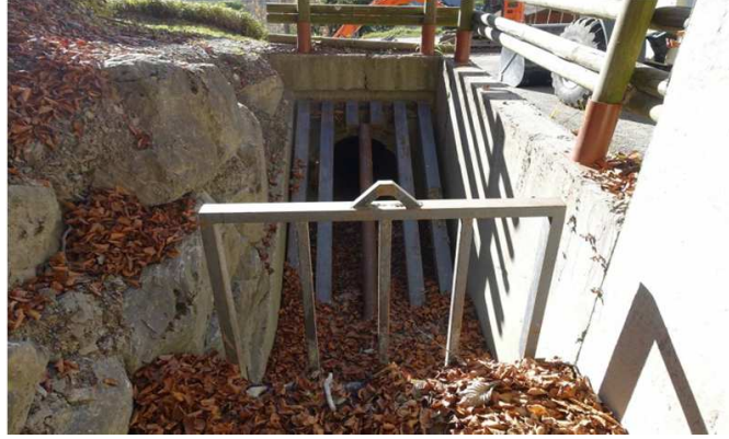
Tête amont de l'ouvrage
