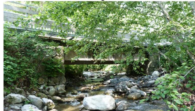
Tête aval de l'ouvrage
