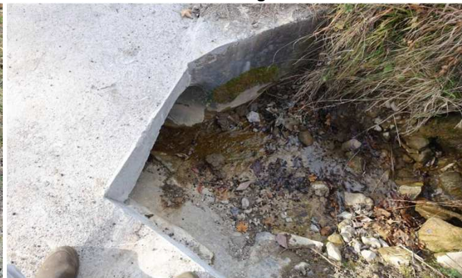
Tête amont de l'ouvrage
