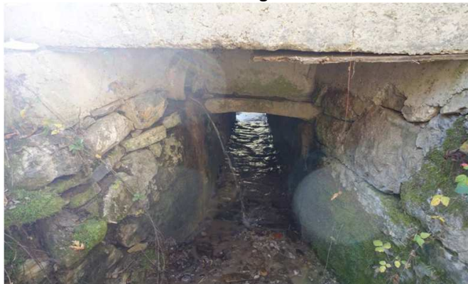
Tête amont de l'ouvrage
