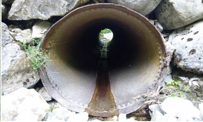
Tête amont de l'ouvrage
