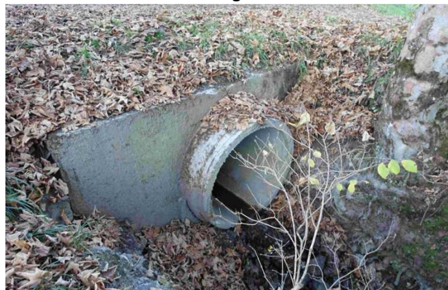
Tête aval de l'ouvrage
