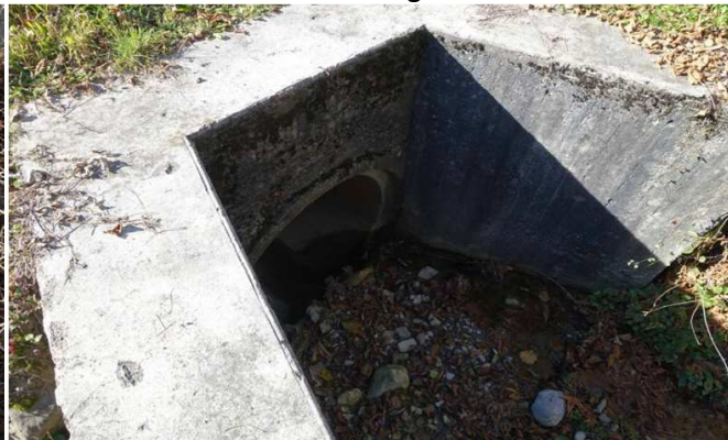
Tête amont de l'ouvrage
