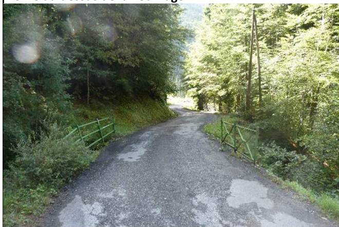
Voirie au dessus de la l'ouvrage
