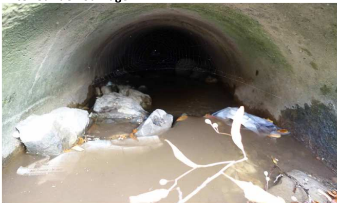
Intérieur de l'ouvrage
