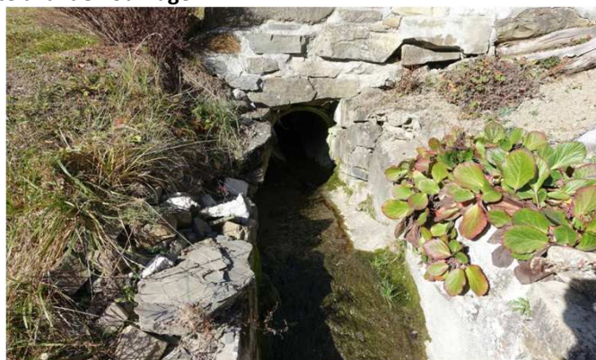
Tête aval de l'ouvrage
