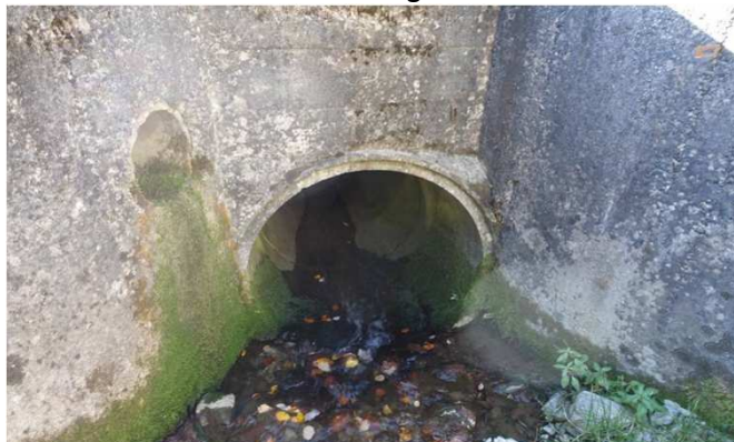
Tête amont de l'ouvrage
