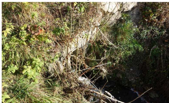
Tête aval de l'ouvrage
