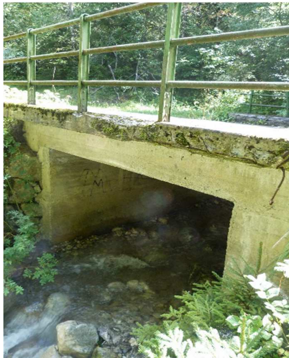
Vue de l'ouvrage
