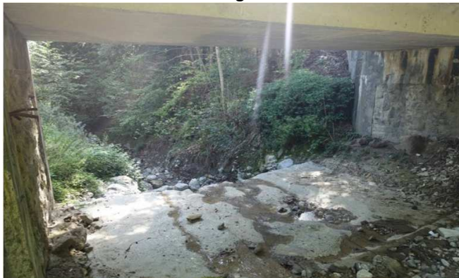
Tête aval de l'ouvrage
