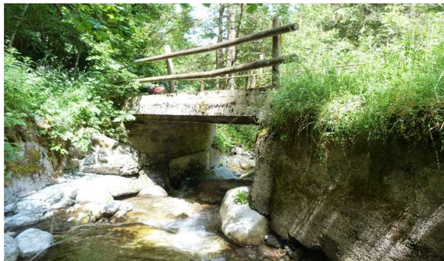
Tête amont de l'ouvrage
