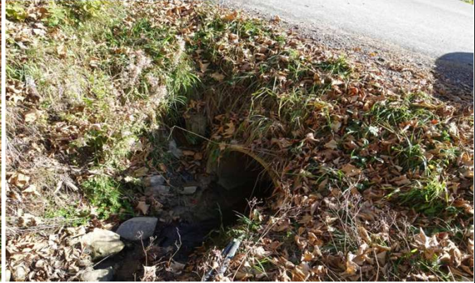
Tête amont de l'ouvrage
