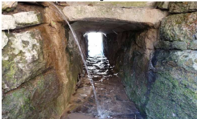
Intérieur de l'ouvrage
