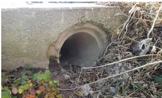
Tête amont de l'ouvrage
