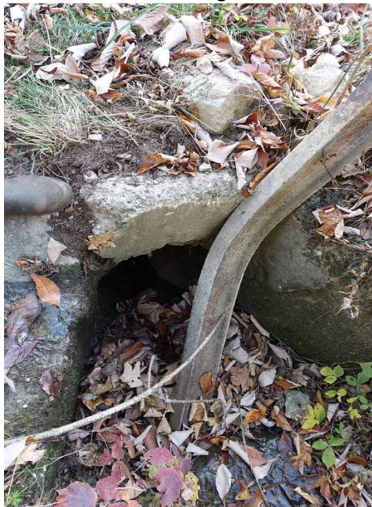
Tête amont de l'ouvrage
