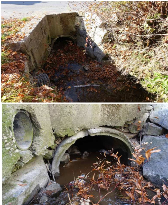
Tête amont de l'ouvrage
