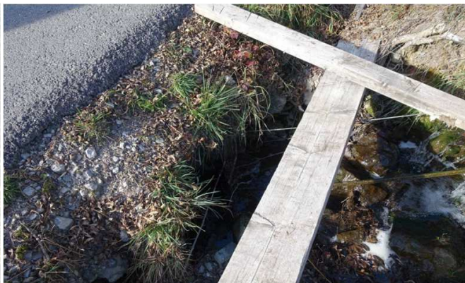
Tête amont de l'ouvrage
