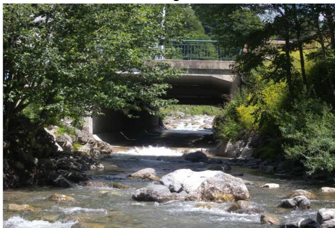
Tête aval de l'ouvrage
