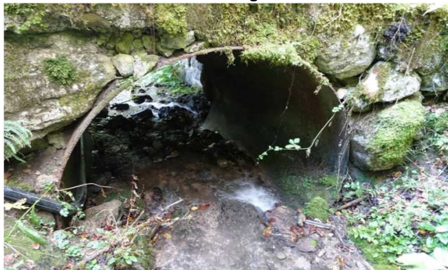
Tête amont de l'ouvrage
