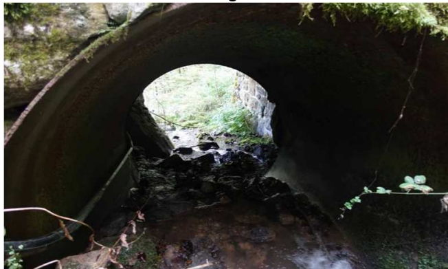
Intérieur de l'ouvrage
