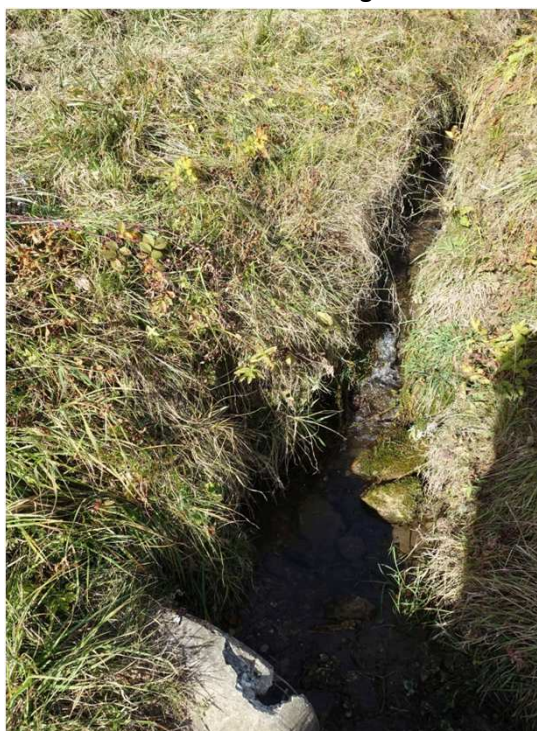
Tête amont de l'ouvrage
