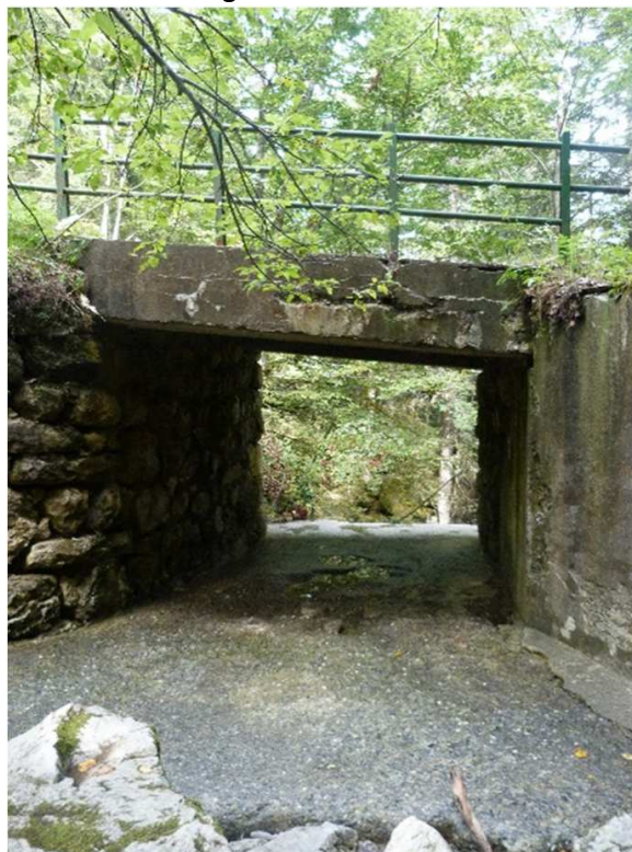
Vue de l'ouvrage
