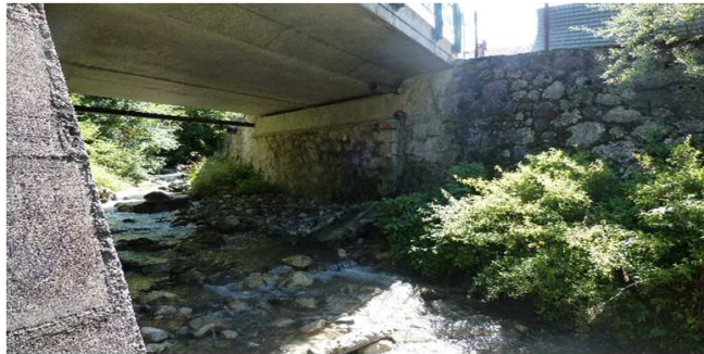
Vue de l'ouvrage
