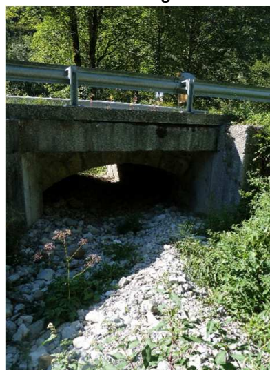
Tête amont de l'ouvrage
