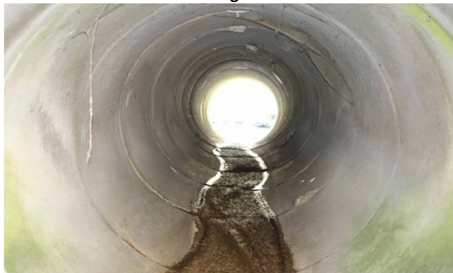
Intérieur de l'ouvrage
