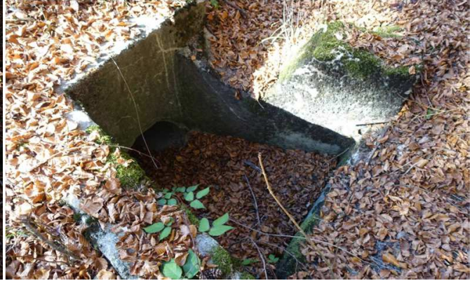
Tête amont de l'ouvrage
