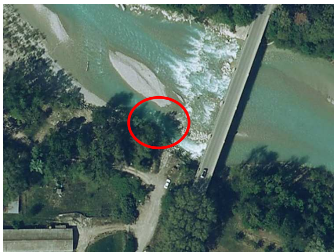
Figure 9 : Zone de stockage provisoire
