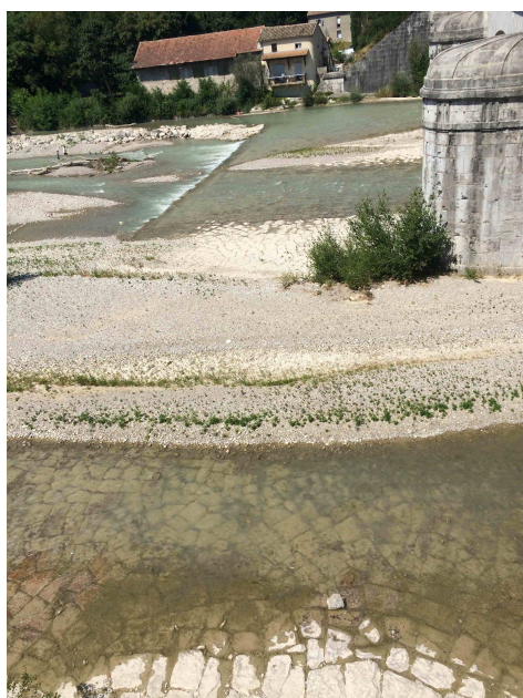
Exemples de pose en dallage (ou pavage) où les blocs présentent une surface relativement plane (Source M. Baudry, bureau Ciméo)
