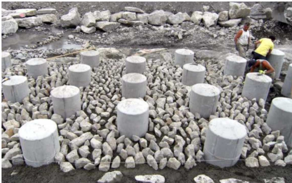
Figure 10 : Création de rampes à macroplots régulièrement répartis sur le Drac amont (05); source ONEMA
