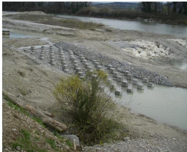
Photo 5 : Exemple de rampe à plots réalisée sur la Drôme
