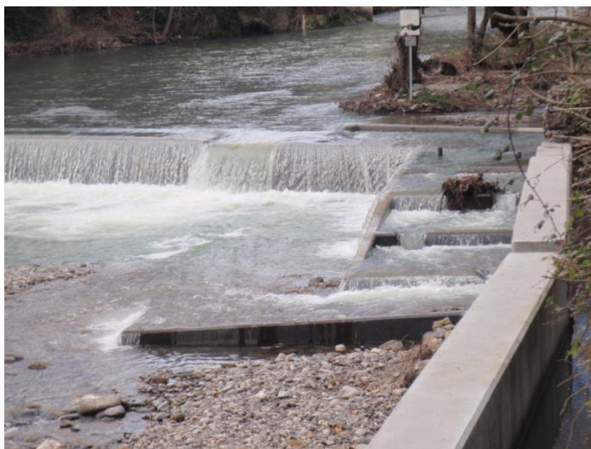
Photo 12 : Vue de la passe à poissons au seuil de la Pataudée, commune de Coux, après la crue d'Octobre 2013
