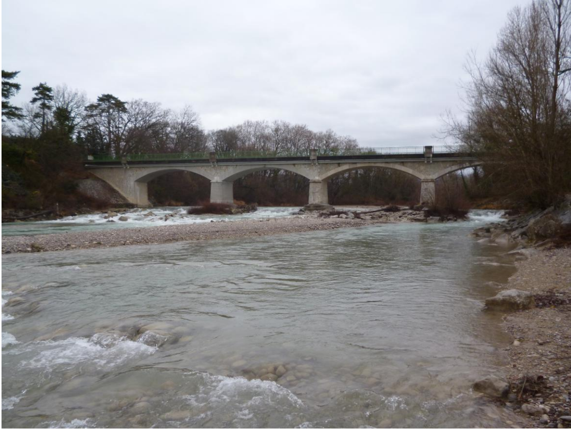
Photo 15 : Vue vers l'amont depuis l'aval du pont Batelier
