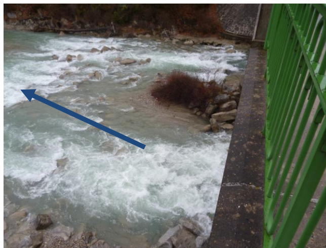
Photo 4 : Zoom sur les arches 4 et 3 montrant la chute, les écoulements turbulents et les gros blocs éparpillés, vue depuis le pont
