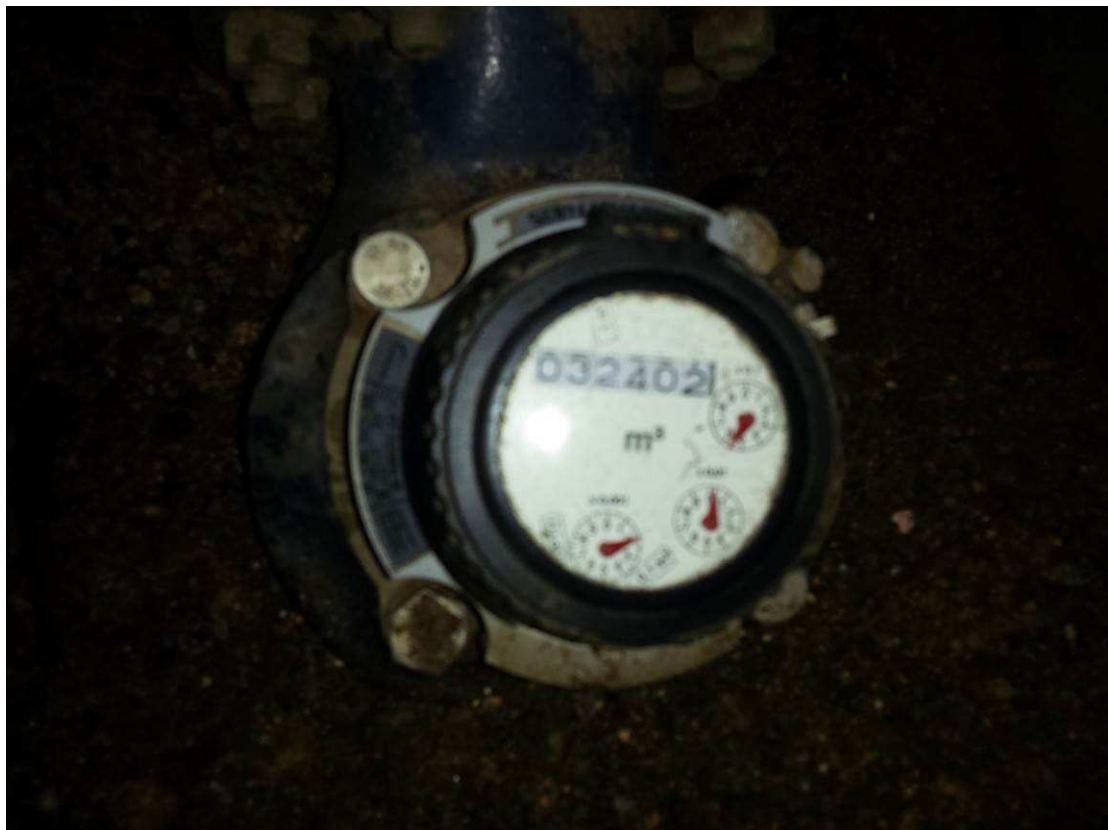
Photo du Compteur C4 – Distribution d'eau à partir du réservoir de La Grange vers le hameau La Grange
