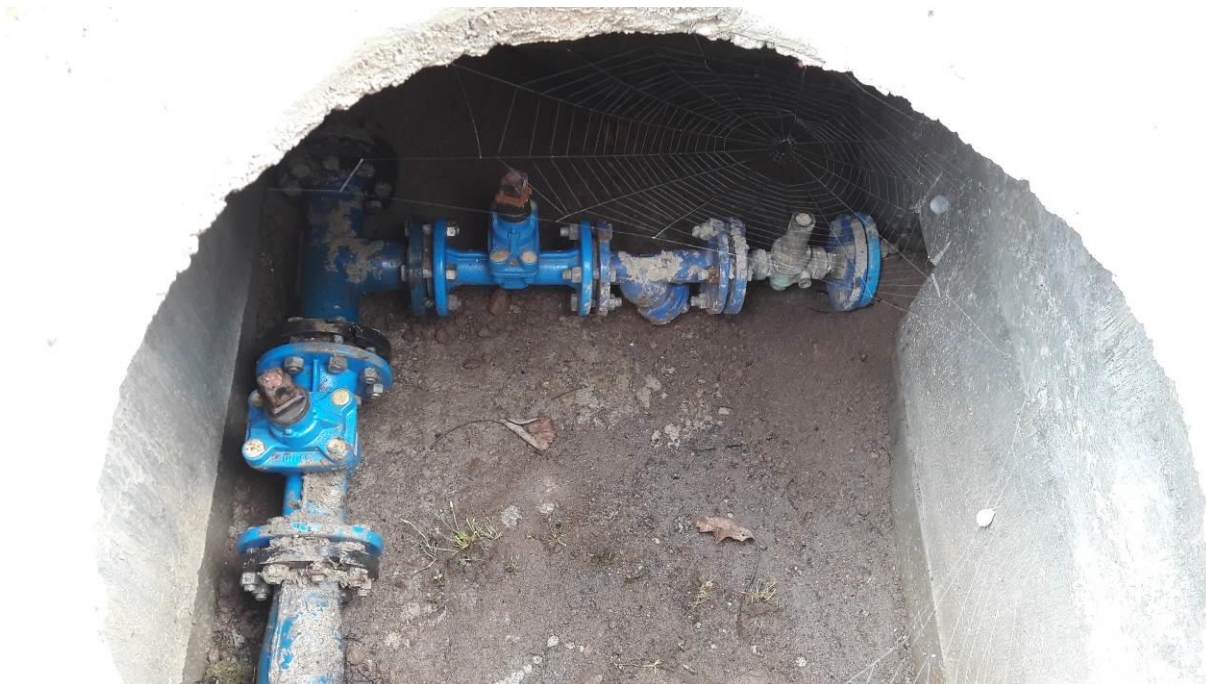
Photo du réducteur de Pression RP17 – Blachon
