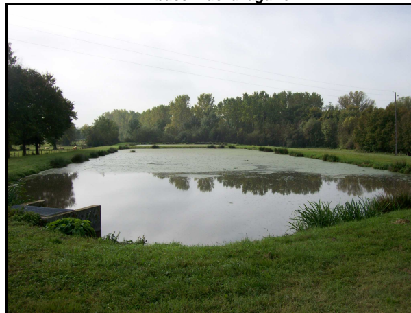
1 er bassin de la lagune
