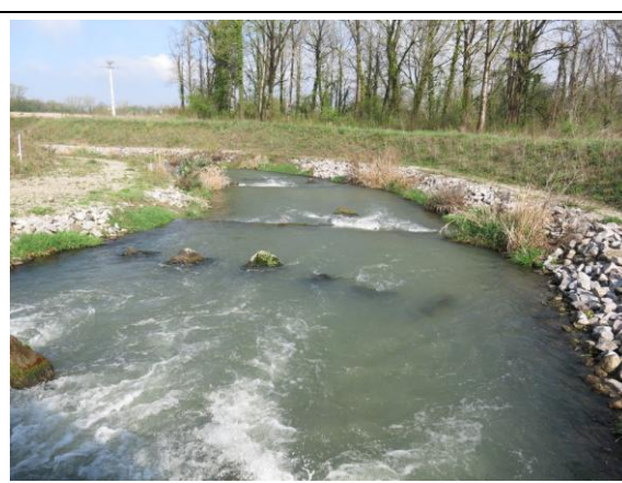
Remise en eau de la rivière de contournement suite aux travaux de modification
