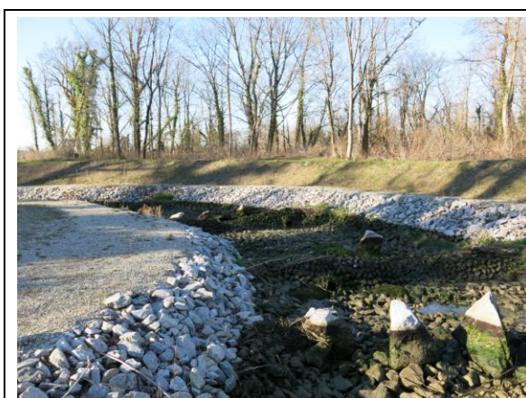
Bassins mis à sec préalablement aux travaux de modifications
