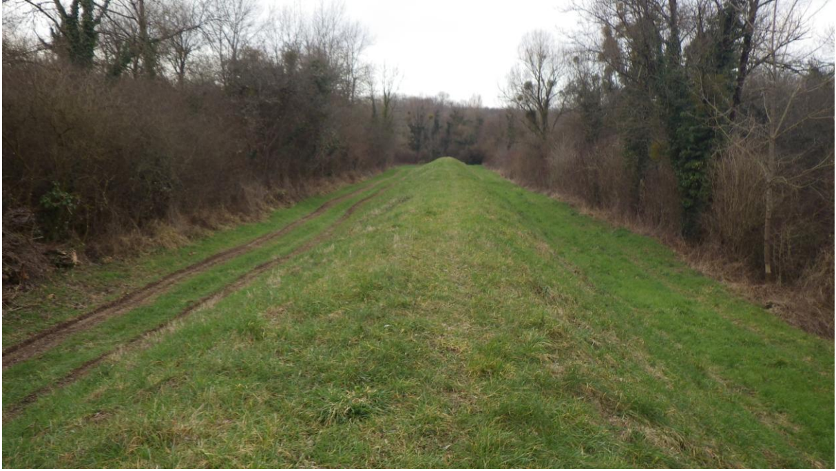
Digue de Montbarrey en aval de la RD 11
