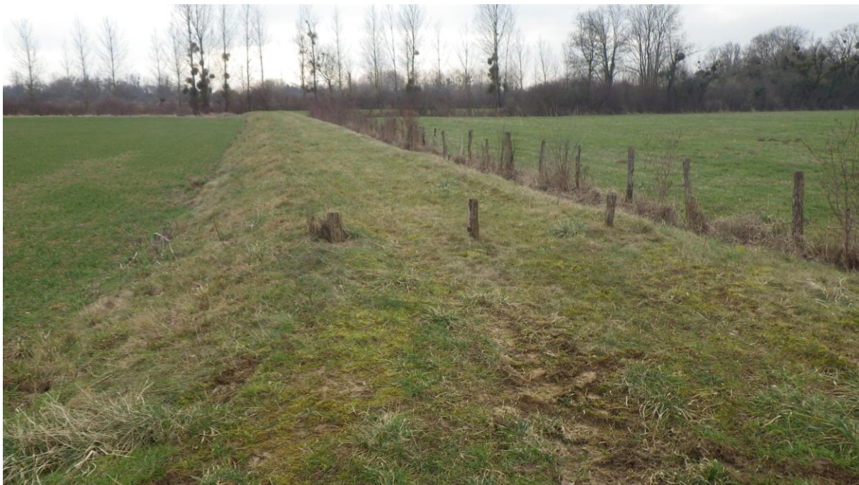
Digue de Montbarrey au raccordement avec la RD 71
