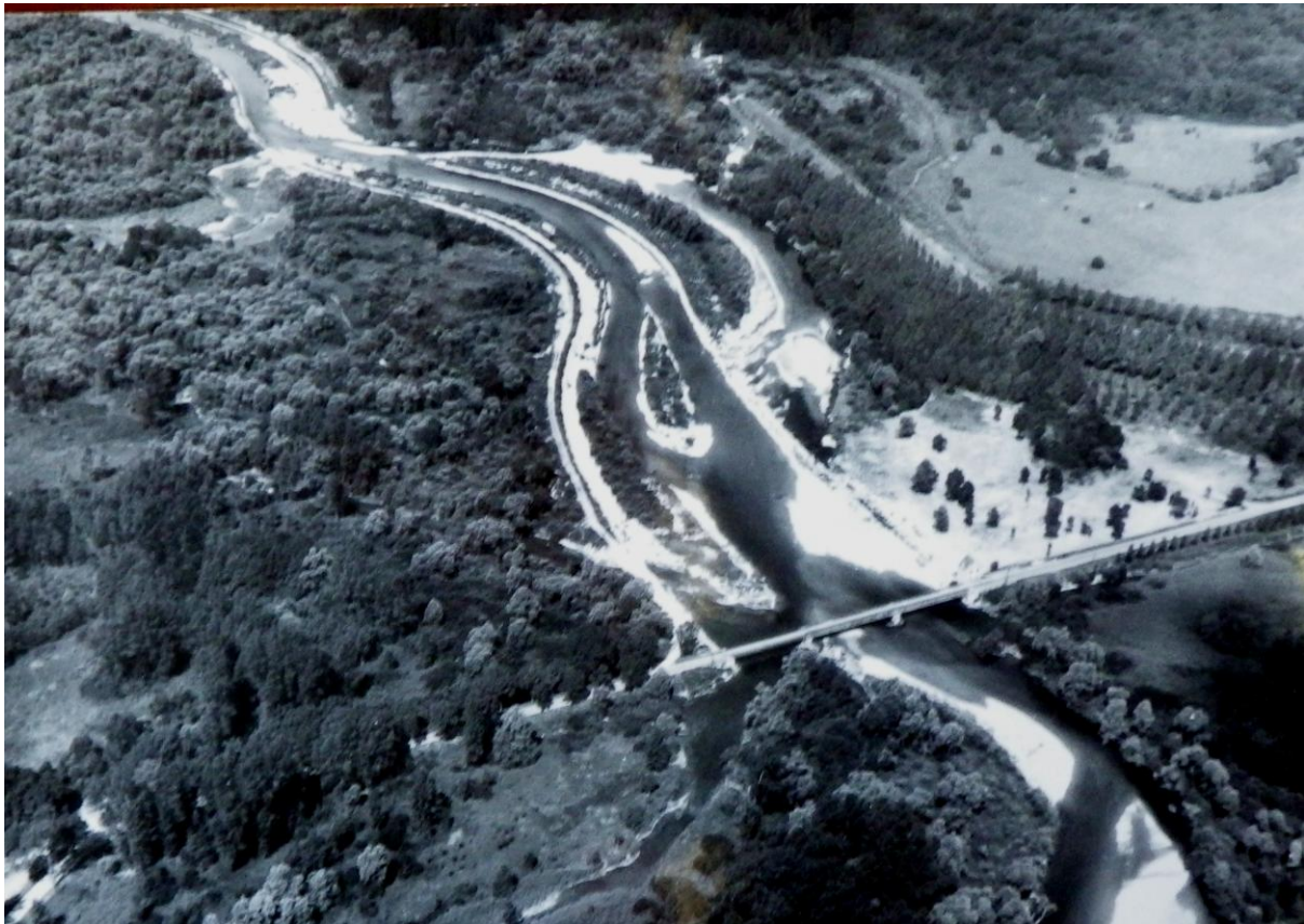
Travaux de calibrage du lit en aval du pont de Montbarrey-1965
