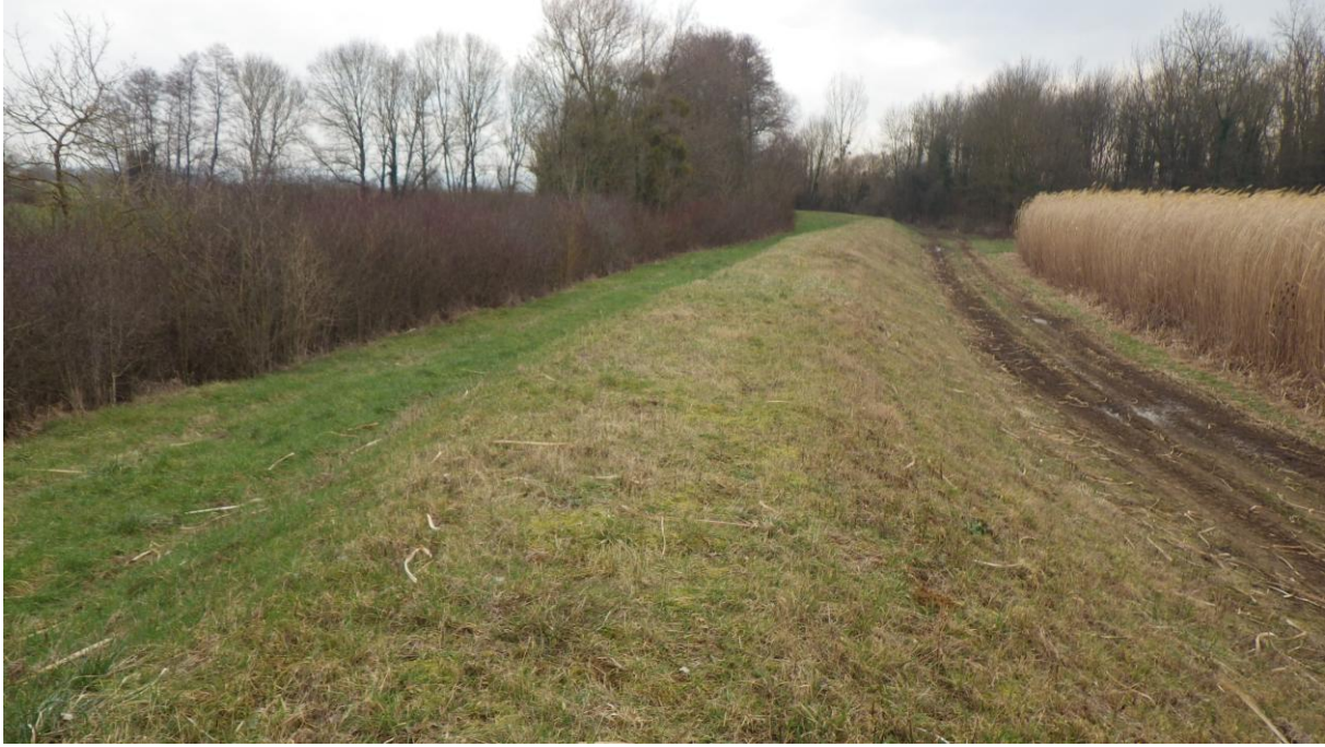
Digue de Montbarrey entre la RD 11 et la RD 71
