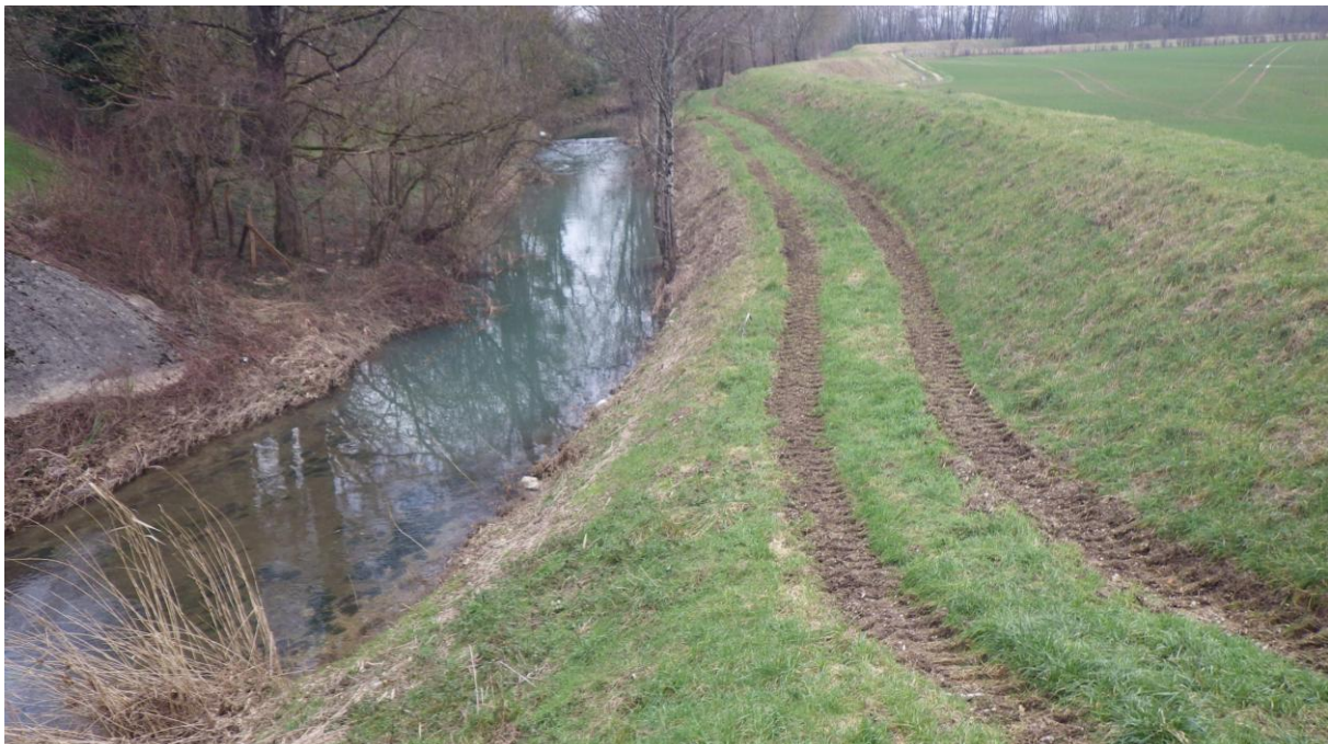
Leue en amont du pont de la RD 11 et digue en rive gauche
