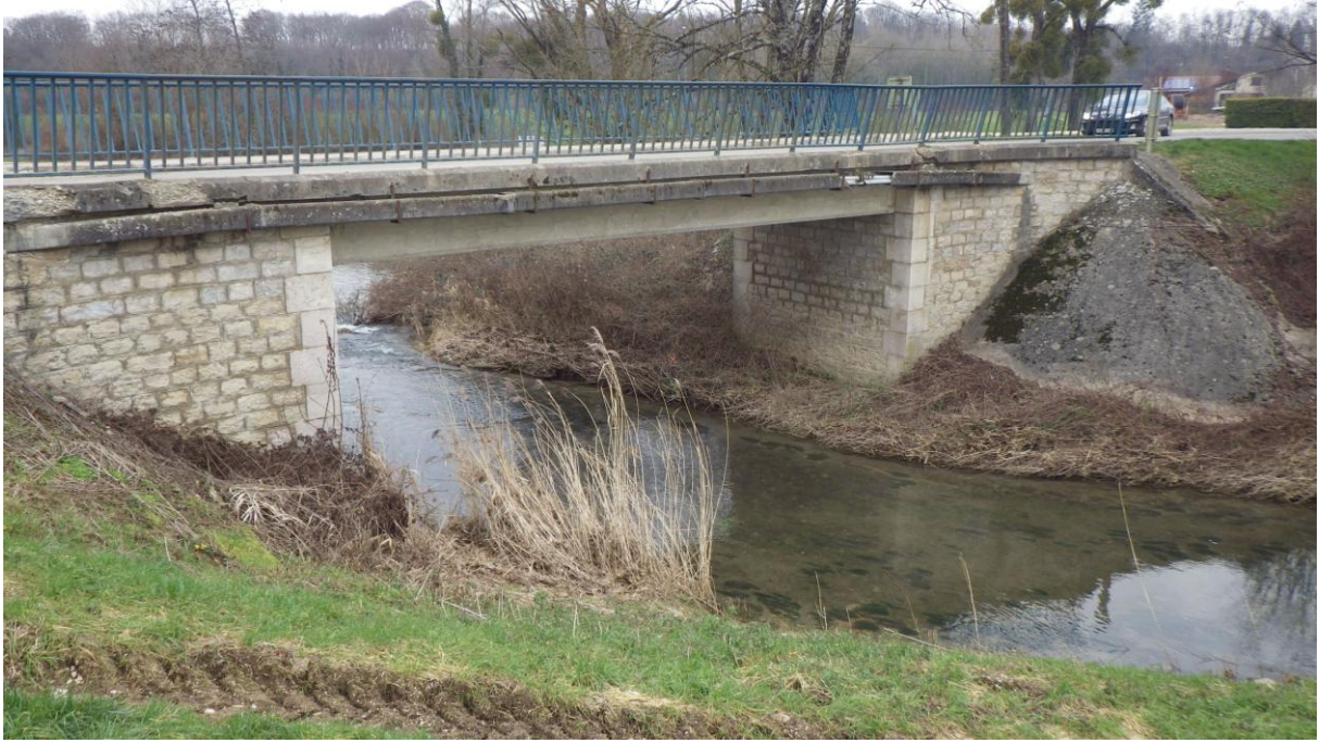
Pont de la RD 11 sur la Leue
