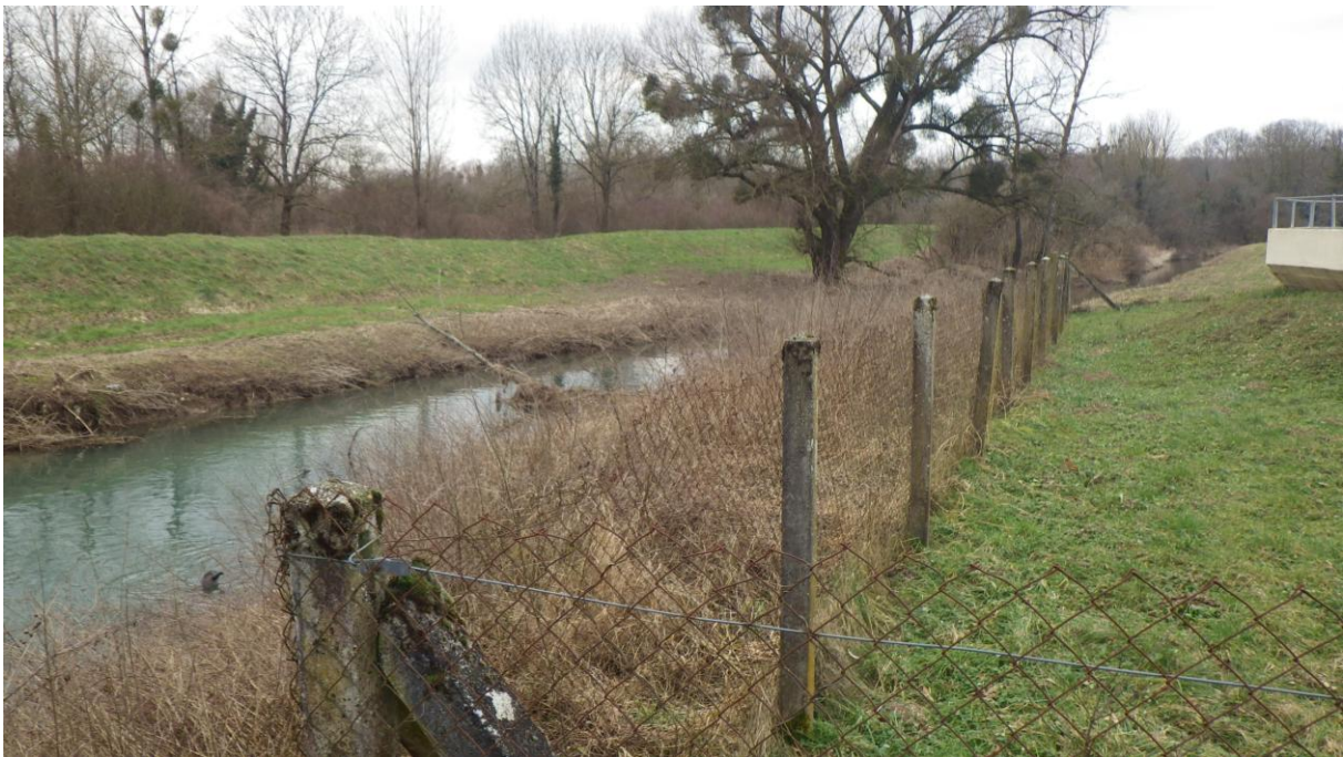
Leue entre digue(RG) et STEP (RD)
