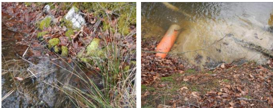
Figure 5 : Entrée d'eau dans la digue de l'étang du milieu et restitution à l'aval (à droite du tuyau)
