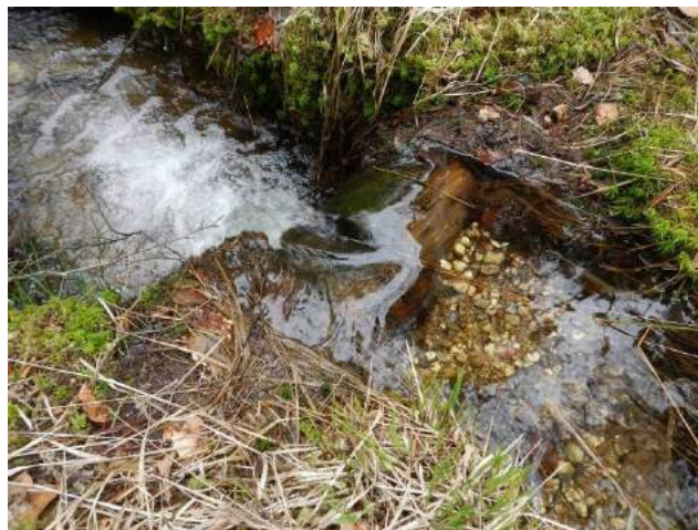
Photographie 14 : Ruisseau des Œillets, aménagement en rondin échancré formant une chute à l'amont immédiat du pont sur le chemin forestier.
