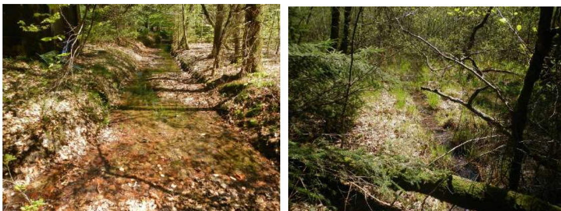
Figure 6 : submersion chemin sur digue. Ecoulement dans étang
