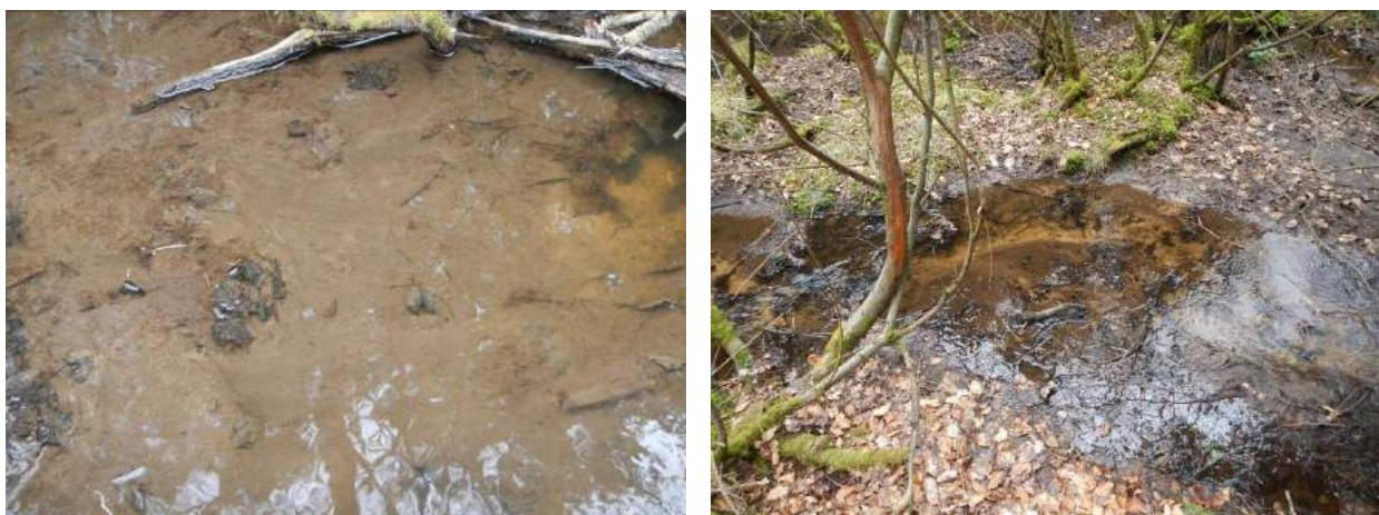
Photographie 7 : substrat colmaté par les fines et les débris végétaux sur le tronçon en aval des étangs.
