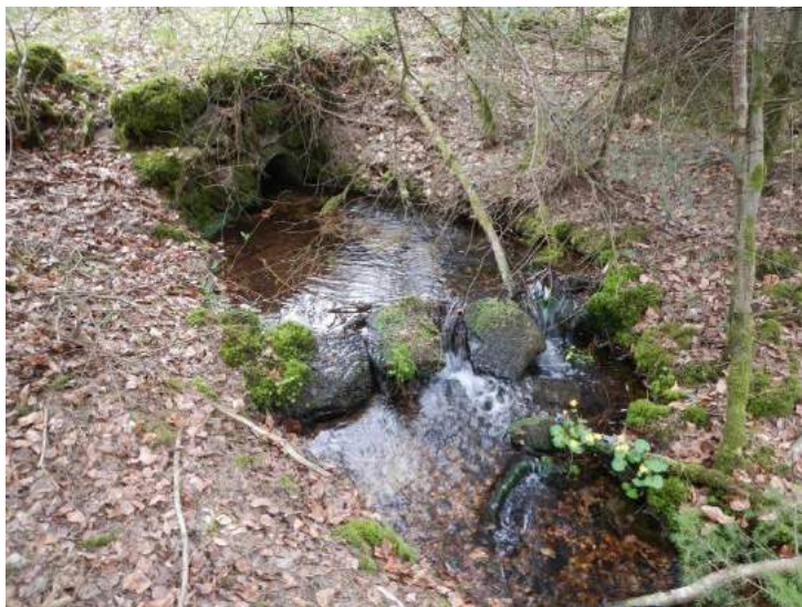
Photographie 13 : seuil en blocs non jointifs permettant l'envoie de la buse sous le pont et le maintien d'une lame d'eau permettant le passage du poisson
