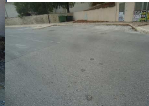
Vannes sur refoulement
