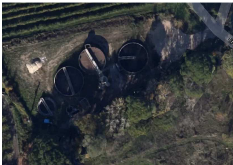
Vue aérienne de la station d'épuration
