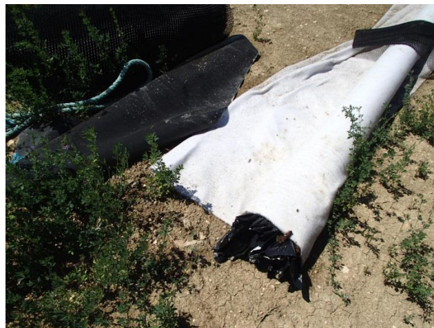
Chutes de géotextile et géomembrane
