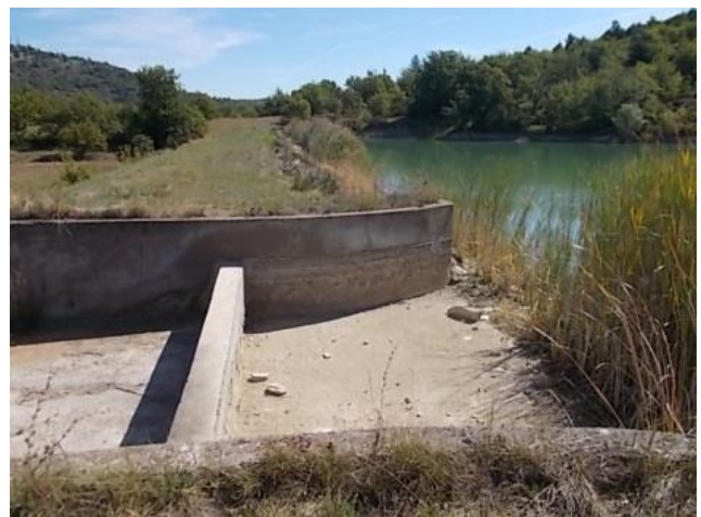
Vue de la digue et de l'évacuateur de crue
