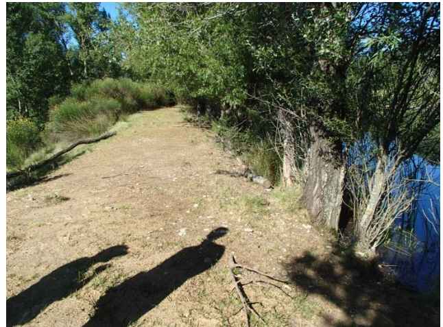
Vue de la digue
