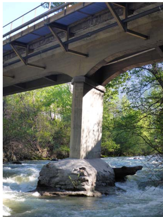
Pile du pont Ugitech reprise contre l'affouillement
