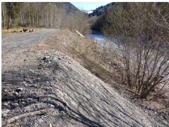
Remblaiement de la rive gauche vers la menuiserie des Glières
