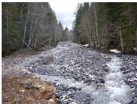
Ruisseau de Plaine Joux à l'amont d'un resserrement artificiel du lit pour une passerelle ski de fond
