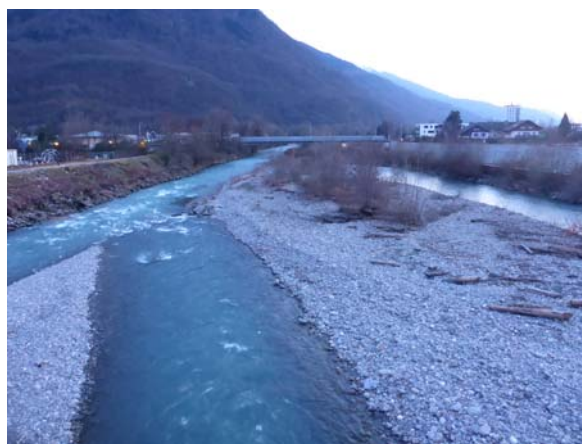
Arly entre le pont Mirantin et le pont SNCF (berge rive gauche fortement sollicitée)
