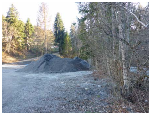
Tri des matériaux curés dans la retenue du barrage
