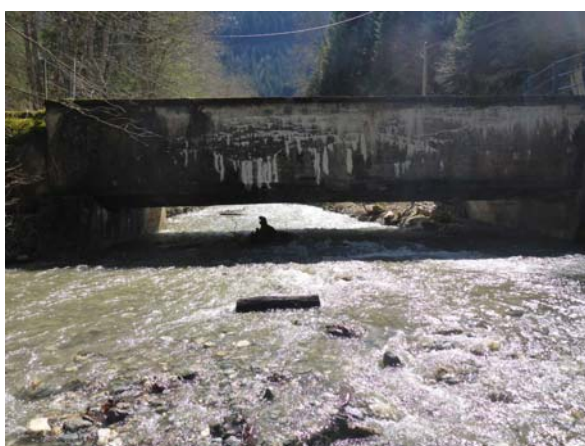
Conduite EDF traversant le Doron avec un très faible tirant d'air
