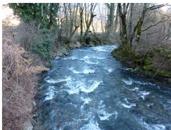
Radier à forte pente en aval du pont de Soney
