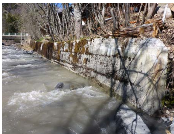
Mur de soutènement de berge calé par un seuil
