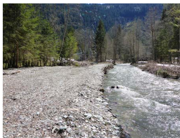
Régilage de matériaux curés en amont en septembre 2013
