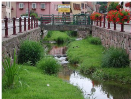
Création de banquettes plus ou moins végétalisées
