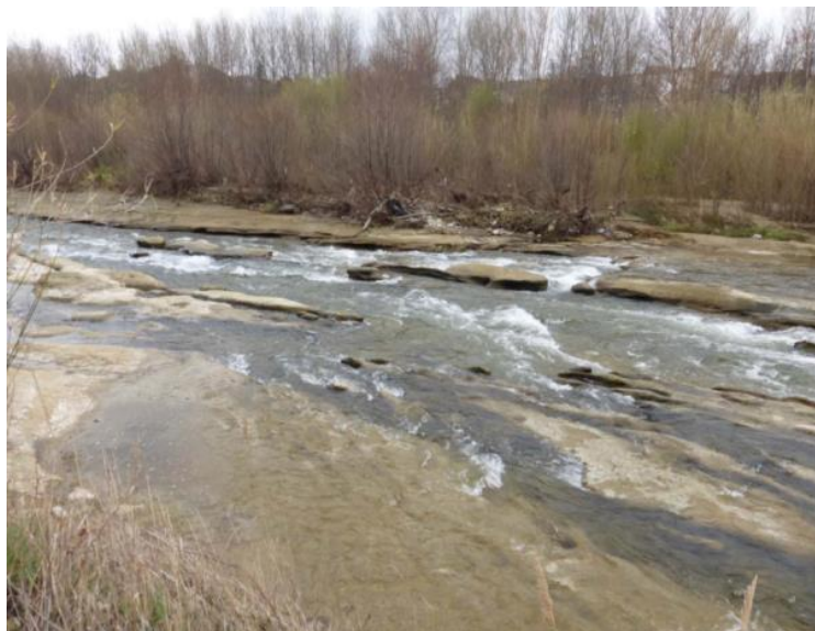
La Têt s'écoulant sur le substratum argileux et l'effet bénéfique de la végétation pour lutter contre l'enfoncement du lit
