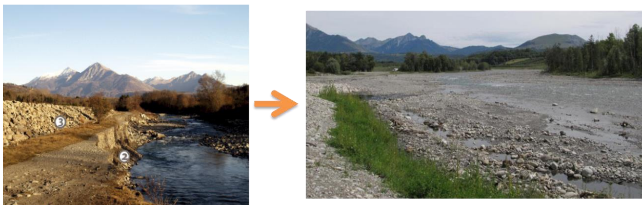
Travaux de reconstitution du matelas alluvial réalisés sur le Drac dans les Hautes Alpes Situation en août 2014 puis 6 mois après travaux (source : CLEDA / BURGEAP)
