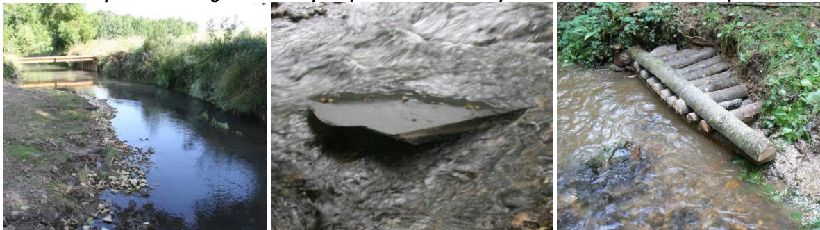
Lit à berge haute restauré en déblai/remblai (à gauche), cache sous dalle ou promontoire (au centre) et abris sous berge (à droite)
