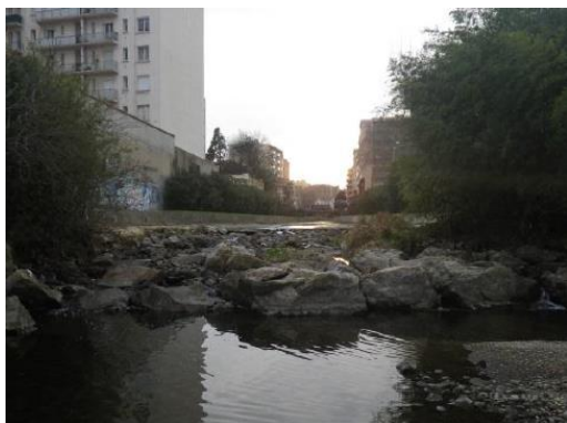
Seuil en enrochements et prise d'eau du canal du jardin de Saint Jacques bloquant actuellement la circulation des poissons entre la Têt et la Basse
