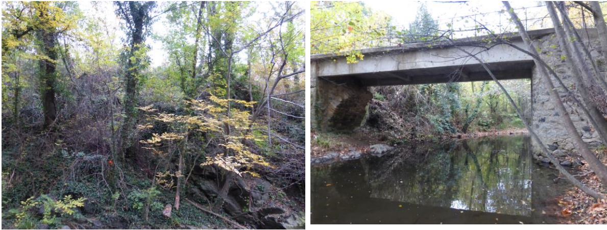
Figure 12 : en rive gauche très gros arbres sur un versant rocheux instable menaçant le canal juste au dessus avec risque d'embâcle sous le pont et de contournement de l'ouvrage
