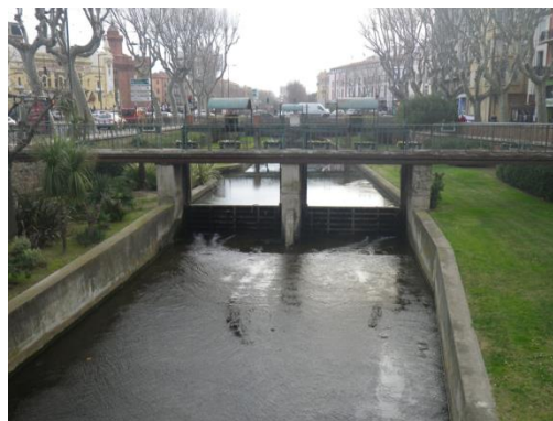
Seuil en enrochements et prise d'eau du canal du jardin de Saint Jacques bloquant actuellement la circulation des poissons entre la Têt et la Basse
