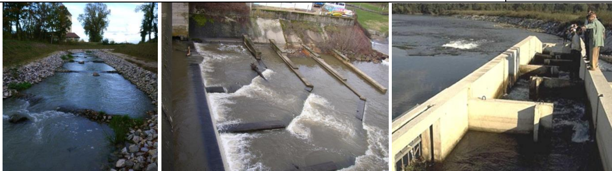
Exemple d'une rivière de contournement (à gauche), de pré-barrages (au centre) et d'une passe bassins (à droite)
