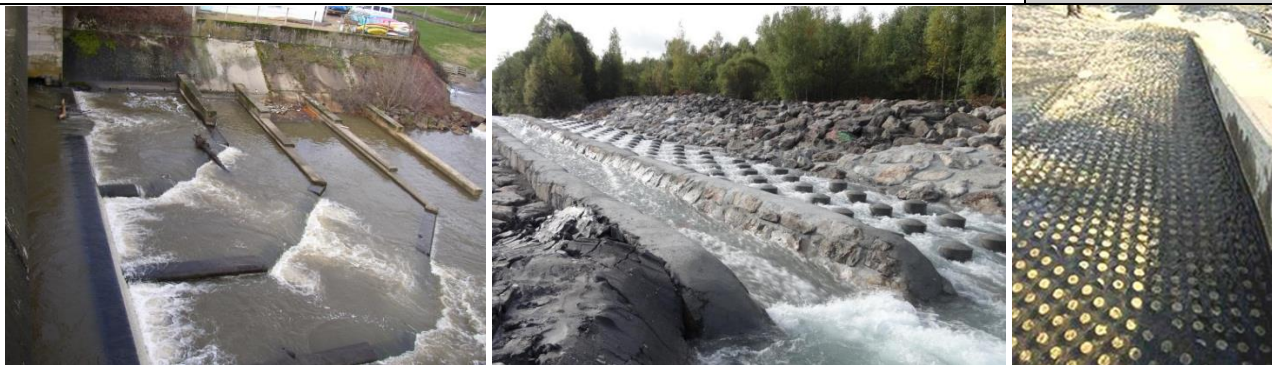
Pré-barrages (à gauche), rampe en enrochements régulièrement répartis (au milieu) et plots à anguilles (à droite)
