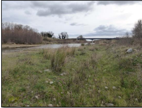
Amont du pont du Soler (pk 977.5)
