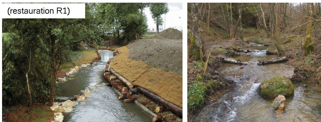
Figure 9 : exemples d'aménagements piscicoles visant à diversifier les habitats d'un cours d'eau.
