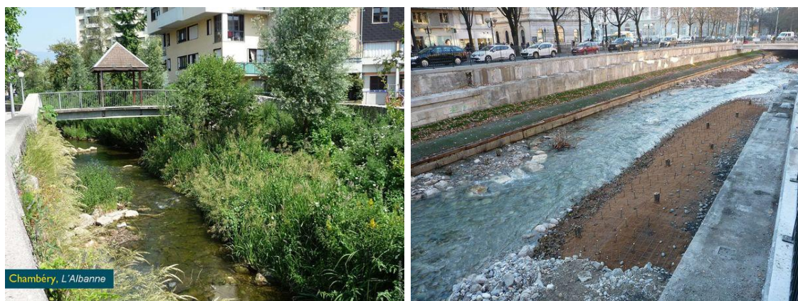
Figure 6 : exemples de rivières canalisées et renaturées en centre urbain, l'Albanne et la Leysse (source : Chambéry Métropole).
