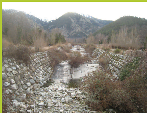
Traversée de Vernet-les-Bains (pk 930.3)
