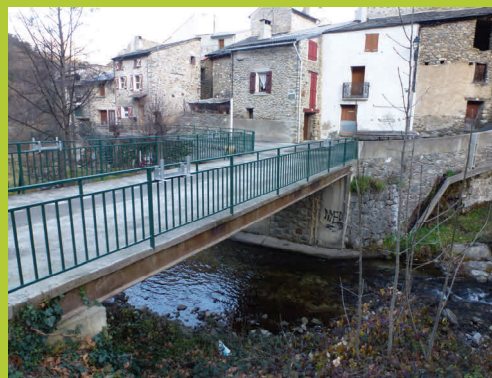
Pont de Nyer à faible risque d'embâcle (pk 921.6)
