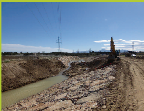
Secteur en travaux (pk 981)
