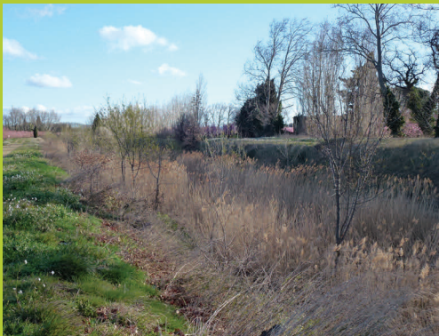
Entretien sélectif - situation régulièrement rencontrée (pk 974.5)
