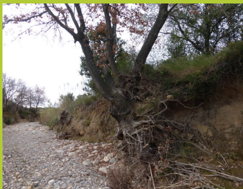
Chêne instable et berges déconnectées de la nappe (pk 979.4)
