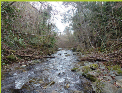
Cours d'eau encaissé, ripisylve peu large et instable (pk 937)
