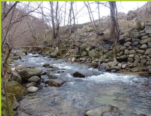
Boisement de berge instable sur l'amont du cours d'eau (pk 928.2)
