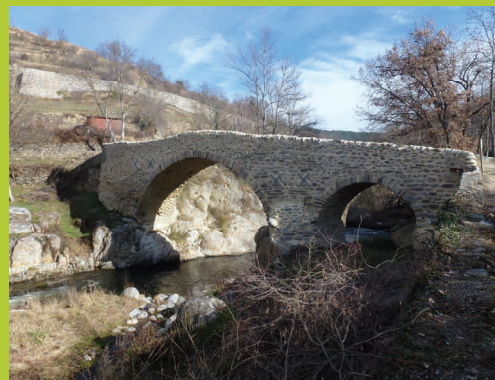
Pont d'aval, récemment restauré (pk 931)
