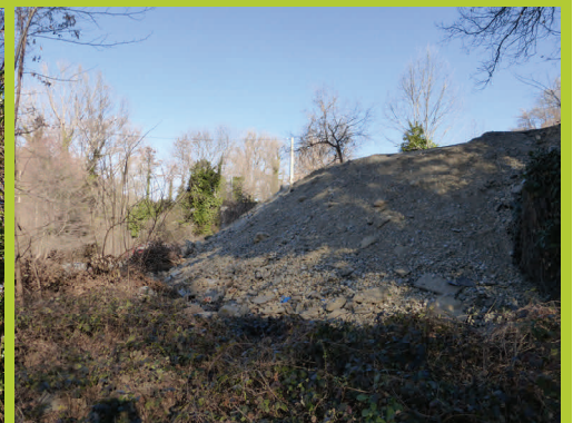
Remblaiement sauvage du lit mineur (pk 947.05)
