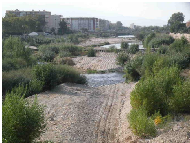
Figure 37 : essai d'orientation des écoulements (2013)
