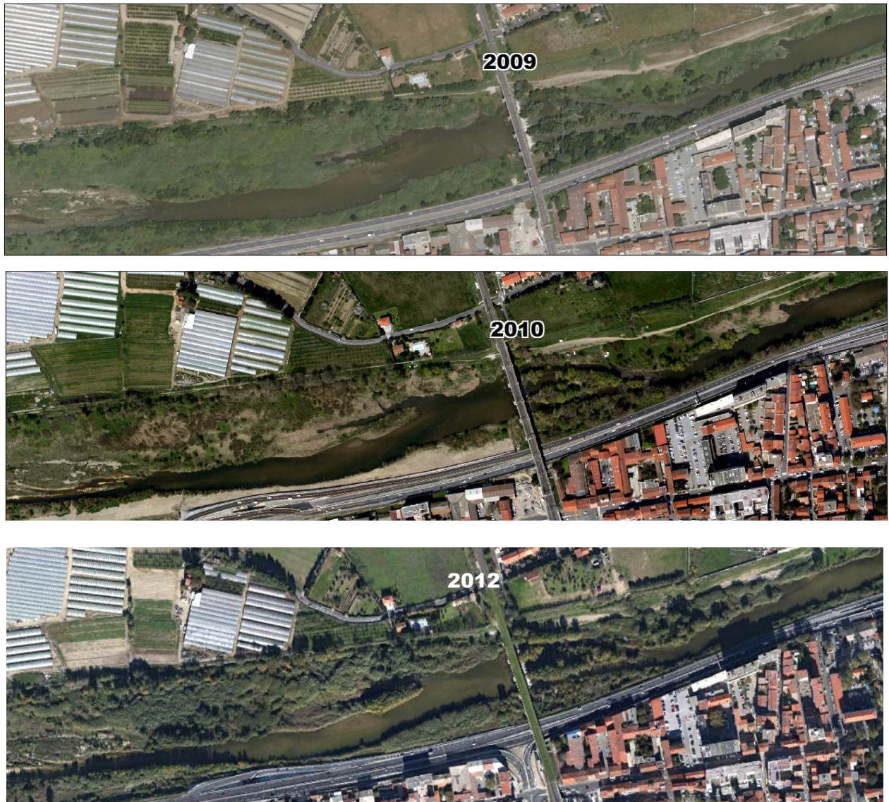
Figure 21 : le lit actuel de la Têt à Perpignan (2009 à 2012) (source : IGN - google earth)
