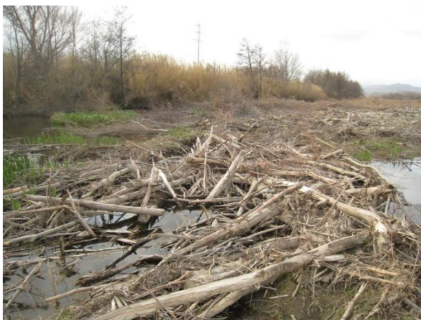
Figure 33 : essartement mené par l'ASCO de Millas sur la Têt en amont du seuil de prise d'eau du canal de Pezilla
