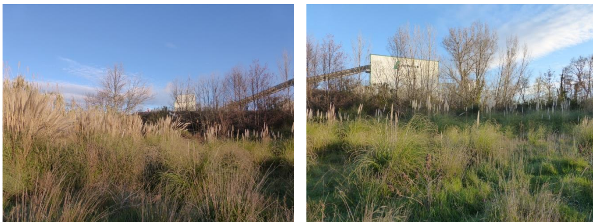
Figure 113 : secteur complètement envahi en rive gauche de la Têt dans à l'entrée de Perpignan (pk 984.5)
