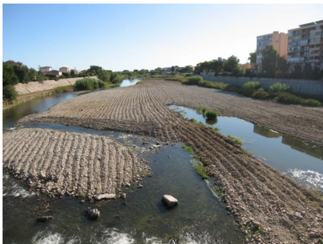
Figure 36 : déboisement et ripage des bancs (2011) (crédit photo : GASTON-CONDUTE)
