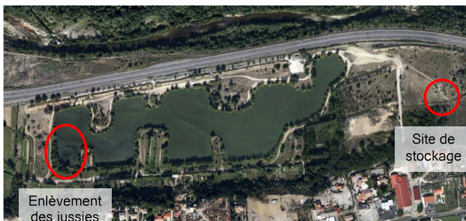
Figure 79 : site des travaux- (Source Google Earth)
