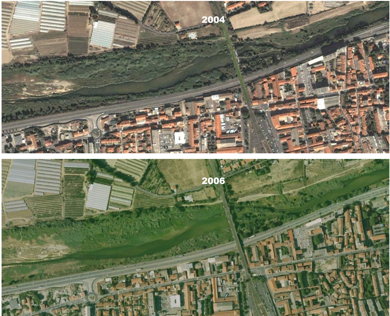
Figure 20 : le lit actuel de la Têt à Perpignan (2004 à 2006) (source : IGN - google earth)
