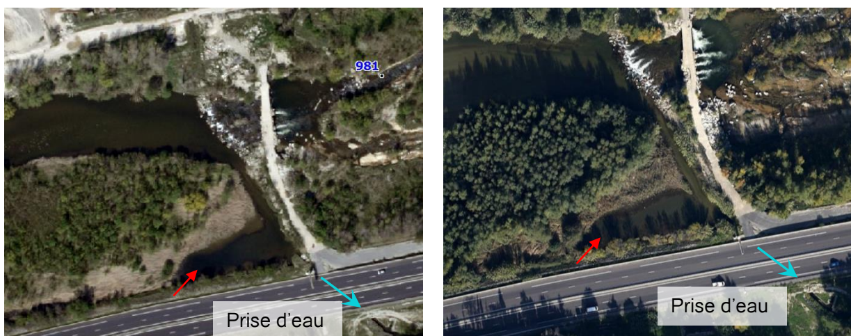
Figure 82 : vue aérienne du site en 2010 (SMBVT) et 2012 (Google Earth)
