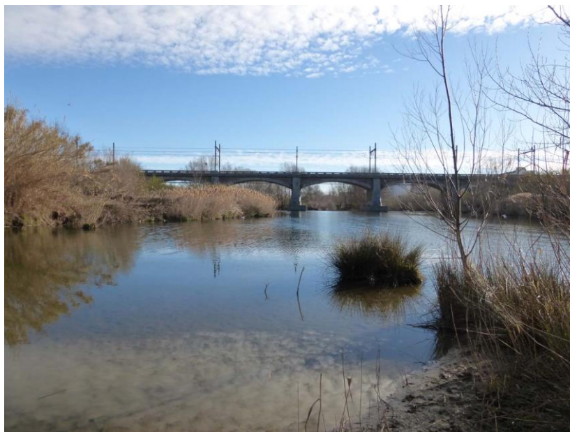
Figure 17 : zone humide en amont du pont SNCF
