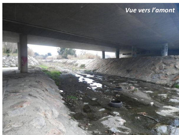
Affouillement au pied de l'ouvrage
