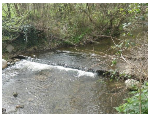
Photo 30 : Seuil créé par un siphon passant sous le cours d'eau en amont du Mas Saurina
