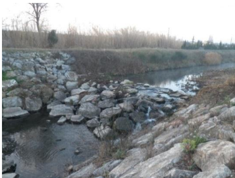
Photo 60 : Seuil en enrochement entre la D37 et la D39 (Non ROE - BAS07b)
