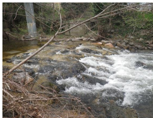
Photo 24 : Seuil protégeant le siphon d'un canal d'irrigation au niveau du Mas Riquer (CASo1 - Non ROE)
