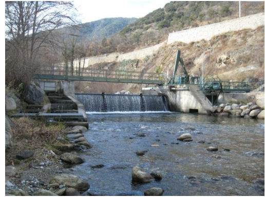
Photo 8 : Seuil de la prise d'eau de Joncet le Sola (TET29 – ROE49900)
