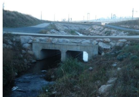
Photo 61 : Gué en aval de la voie ferrée (Non ROE - BAS05)
