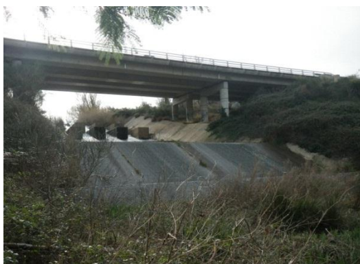
Photo 51 : Radier du pont de la N116 (ROE 51916 - SOL01)
