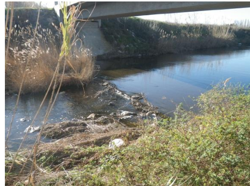
Photo 63 : Seuil bétonné sous le pont de la D51 (CIR02 – Non ROE)
