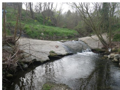
Photo 33 : Gué bétonné au niveau du pk 942,75 (LOU04 - Non ROE)
