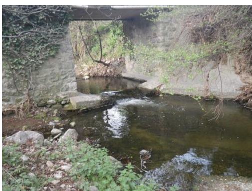
Photo 32 : Radier sous un pont près du lieu-dit les Costes (LOU03 - Non ROE)
