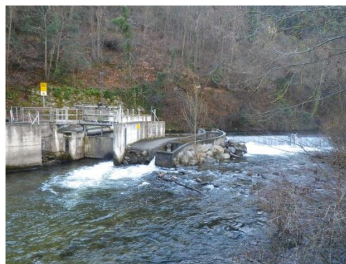
Photo 6 : Seuil de la centrale hydroélectrique de Serdinya 2 (TET26 – ROE45377)
