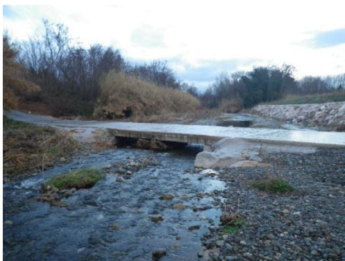
Photo 41 : Passage à gué en aval de la voie ferrée (BOL02 - ROE 52155)
