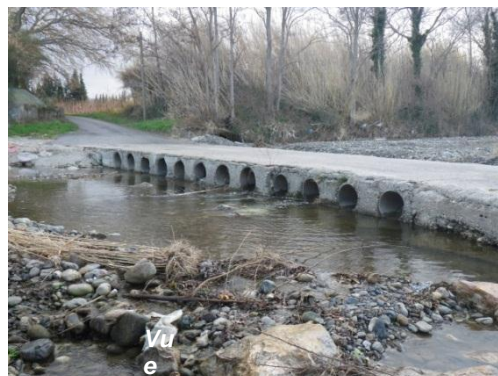
Photo 42 : Passage à gué en amont de la voie ferrée (BOL04 - ROE46858)
