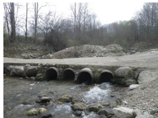
Photo 15 : Accumulation de matériaux en amont du gué du Mas Camo (CADo2 - Non ROE)
