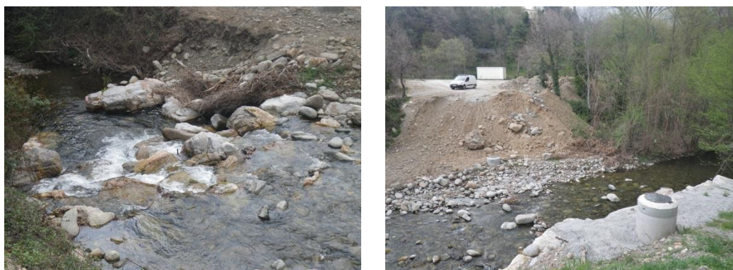
Photo 35 : Seuil en enrochements en aval de Finestret et son tronçon amont
