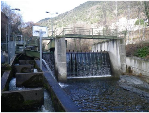
Photo 7 : Seuil de la prise d'eau de Serdinya 1 et canal de Bauer (TET28 – ROE49899)
