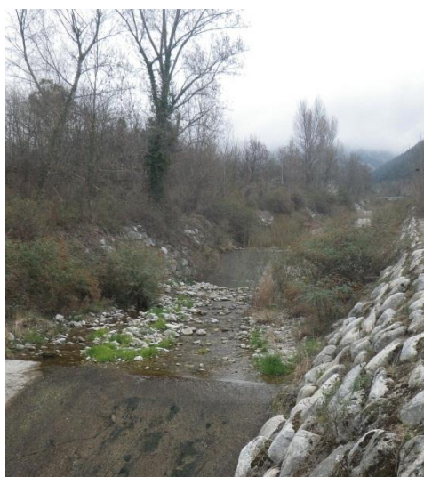
Photo 16 : Premiers seuils du secteur recalibré du Saint-Vincent dans Vernet-les-Bains (SVI02 – Non ROE)
