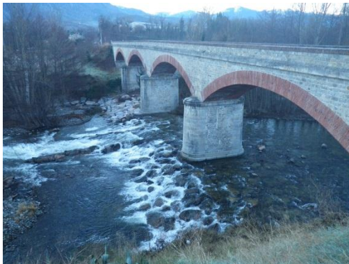
Photo 4 : Seuil de stabilisation du pont d'Eus (TET22 – ROE 49887)
