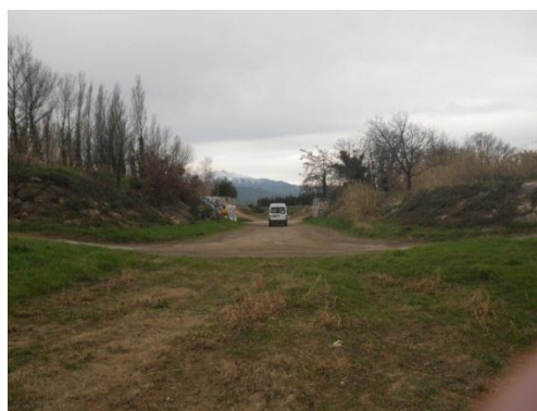
Photo 52 : Tronçon routier en amont du seuil en enrochements du Pla de Reilla amont (ROE 51073 - SOL07)
