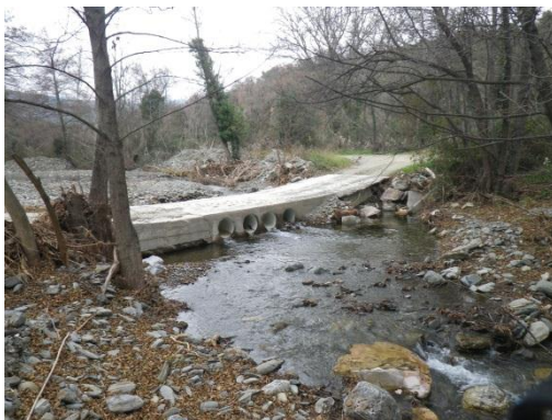
Photo 38 : Gué busé amont RN116 (RIG01 - ROE65374)
