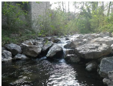
Photo 20 : Seuil de stabilisation du pont de la voie ferrée à Codalet
