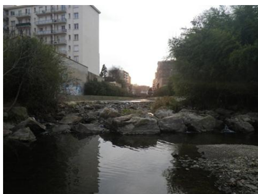
Photo 54 : Seuil en amont de la confluence avec la Têt (Non ROE - BASo1)
