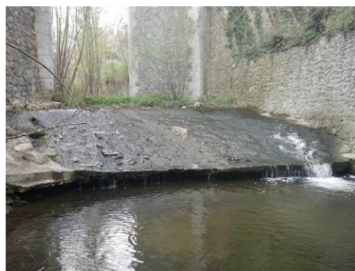
Photo 31 : Seuil de stabilisation de la voie ferrée
