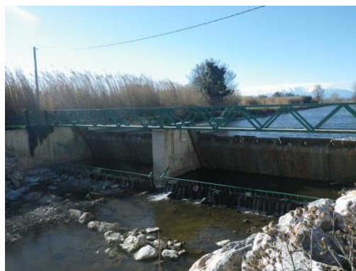
Photo 66 : Seuil et clapets basculants au niveau du lieu-dit « el Vegueriu Baix » (CIR05 – ROE54183)
