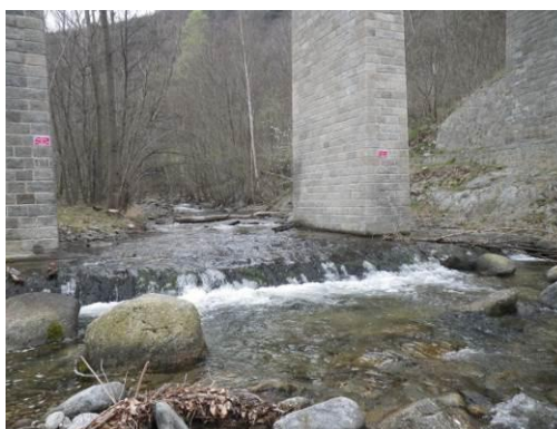
Photo 10 : Seuil de stabilisation du pont de la voie ferrée (MAN01)
