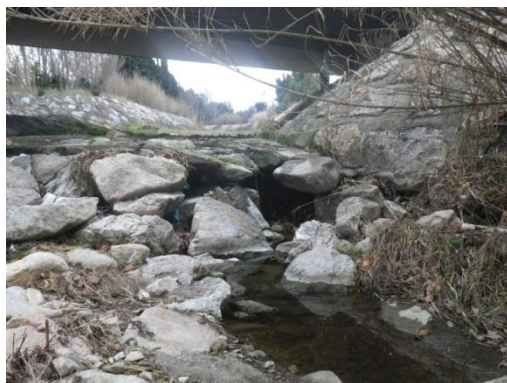
Photo 49 : Seuil de protection du pont de la N116 (Non ROE - COM01)
