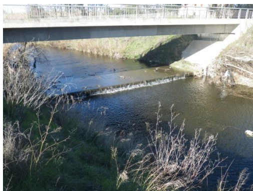
Photo 65 : Seuil en béton sous le pont d'une route communale (CIR04 – non ROE)
