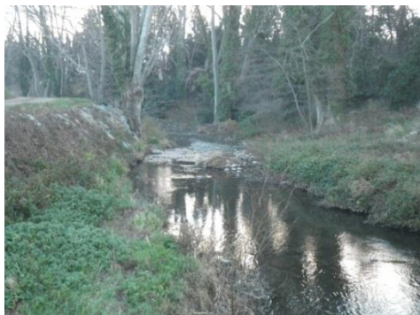
Photo 56 : La basse au niveau du lieu-dit les Bassetes (pk 979)
