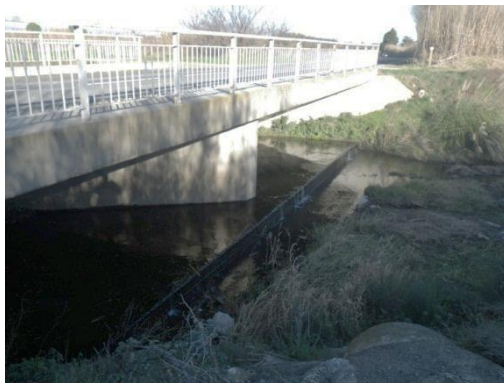
Photo 67 : Seuil sous le pont de la D51 (AUQ03 – Non ROE)
