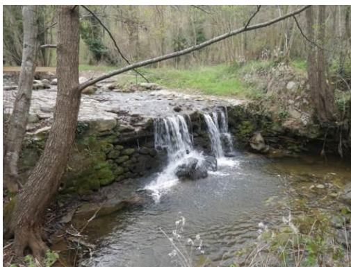
Photo 21 : Seuil de protection du siphon situé au niveau de l'abbaye Saint-Michel de Cuxa (LLI04 – Non ROE)
