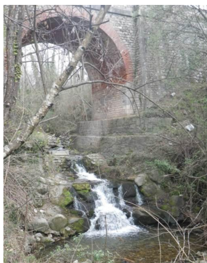
Photo 17 : Seuil de stabilisation du pont de la D116 (SVI01 – Non ROE)
