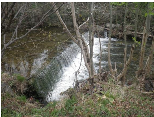
Photo 27 : Prise d'eau en aval du lieu-dit Jonquères (CAS05 – Non ROE)
