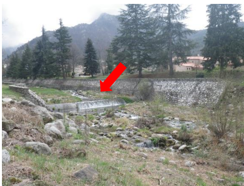
Photo 14 : Premier seuil sur la vingtaine que compte ce tronçon recalibré du Cady (CADo3 - Non ROE)
