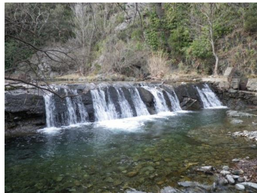
Photo 46 : Seuil de la prise d'eau du canal de Bouleternère (BOL13 – ROE45606)
