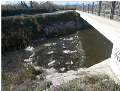
Photo 64 : Seuil en enrochements et bétons sous le pont de la D31 (CIR03 – Non ROE). Une petite chute à l'aval complique la franchissabilité qui reste possible en pied de berge
