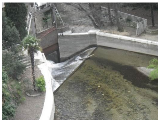
Photo 25 : Barrage des bains de Molitg (CASo4 - ROE50066)
