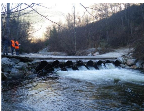
Photo 1 : Gué au niveau du canal de Bohère (TET27 – Non ROE)
