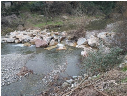
Photo 45 : Seuil de stabilisation du profil en long des Hortes (BOL12 – Non ROE)
