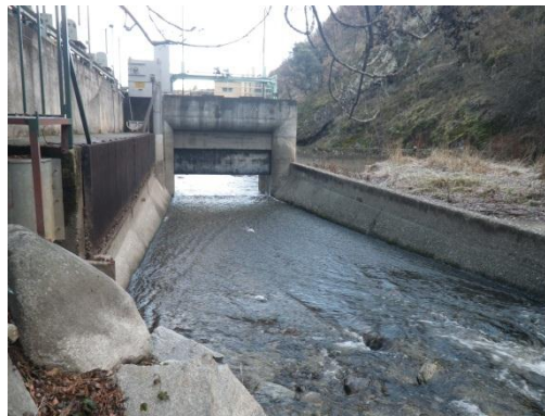
Photo 9 : Seuil de la prise d'eau de Thuès-entre-Valls (TET30 – ROE45960)
