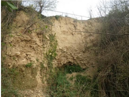
Photo 65 : Erosion rive gauche au pied d'un verger (la Sacristia - Prades)
