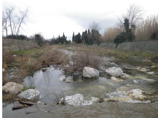
Photo 131 : Aval d'un gué situé en amont de la confluence aval le Gimeneill (ROE 46958)
