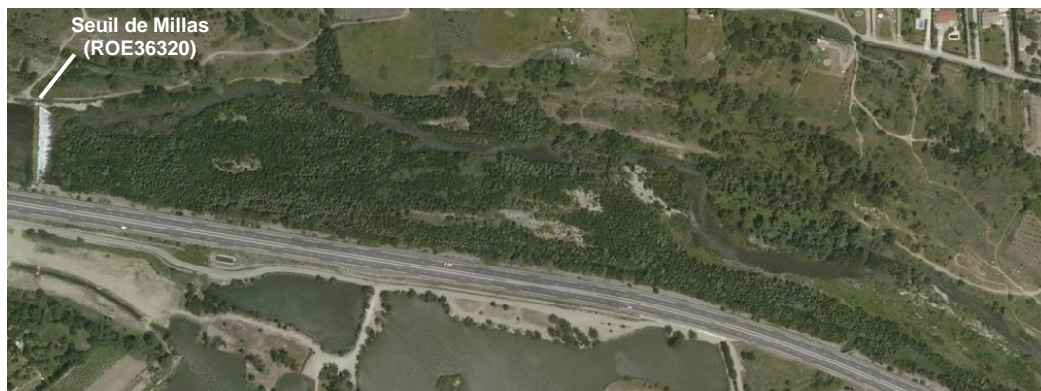
Figure 8 : La Têt en aval du seuil de Millas
