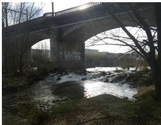
Photo 108 : Seuil sous le pont de la voie ferré à Perpignan (TETo6 - non ROE)
