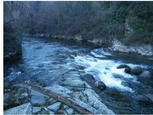
Photo 12 : Seuil de la prise d'eau du Rec de Dalt (TET24 - ROE45368)
