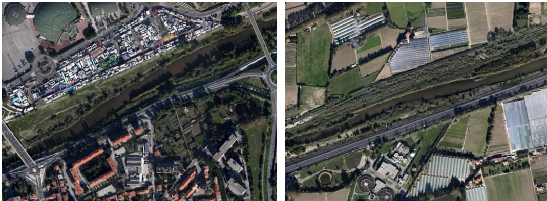
Photo 111 : Chenal d'écoulement entre le pont de l'avenue Emile Roudayre et le lieu-dit Horts Castany (Pk 989,5)
