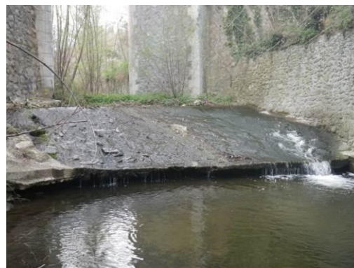
Photo 64 : Seuil de stabilisation de la voie ferrée
