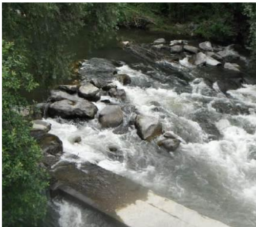
Photo 88 : Seuil de la prise d'eau d'Ille-sur-Têt (TET21 - ROE45601) (Source : fiches MRM, 2011)
