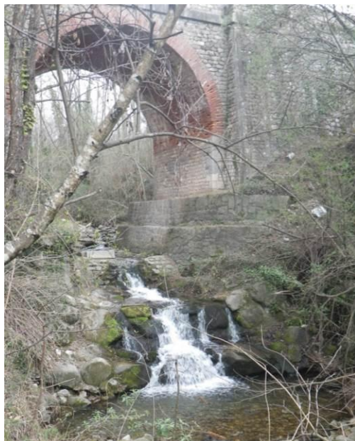
Photo 43 : Seuil de stabilisation du pont de la D116
