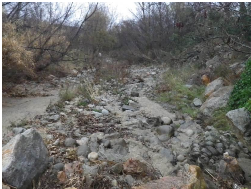
Photo 126 : La Riberette à l'aval du gué des ruines de la chapelle Saint-Clément
