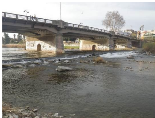
Photo 109 : Seuil sous le pont Joffre à Perpignan (TETo5 - ROE 45481)
