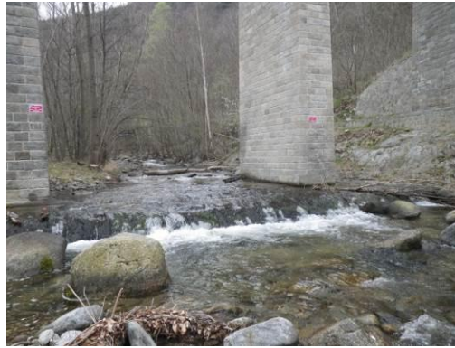
Photo 22 : Seuil de stabilisation du pont de la voie ferrée
