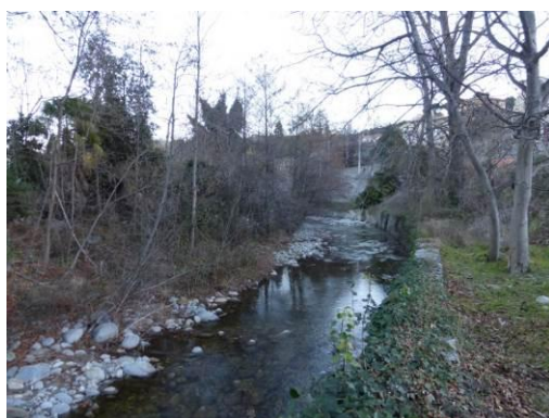
Photo 78 : Berge rive droite bétonnée dans Finestret
