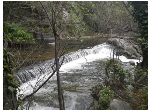
Photo 56 : Prise d'eau 400 m en amont du pont Blau
