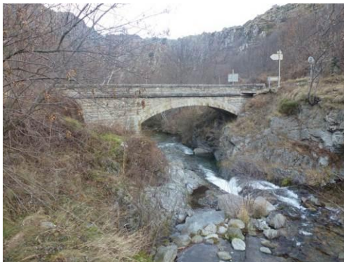
Photo 23 : La Rotja au niveau du pont de la D6 – lieu-dit Cortàls
