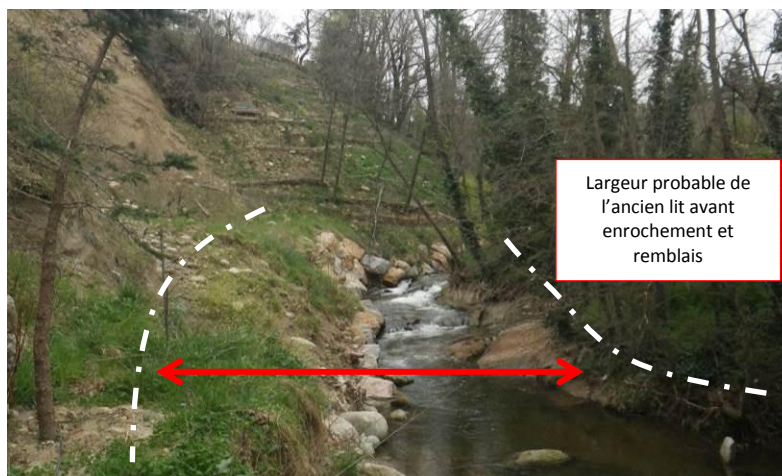
Photo 75 : Vue d'ensemble du secteur modifié vu depuis l'aval
