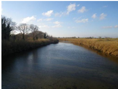
Photo 117 : Vue vers l'amont prise depuis le pont de la D11 (TET01 – ROE36178)
