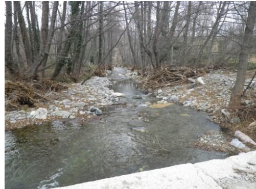
Photo 120 : La Rigarda en aval du gué situé en amont de la RN116 (ROE65374)
