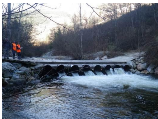
Photo 9 : Gué situé au niveau du lieu-dit la Guardia (TET27 - Non ROE, ≈ Pk 931,25)
