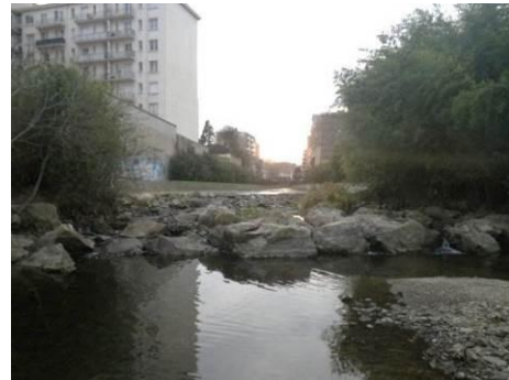
Photo 158 : Seuil en enrochements en amont de la confluence avec la Têt (BASo1 – Non ROE)
