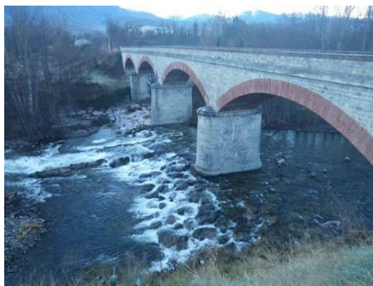
Photo 16 : Seuil en enrochement sous le pont d'Eus (ROE 49887)
