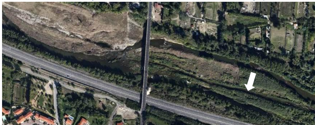
Pont de Millas - Google Earth® 2012 – rétrécissement des chenaux d'écoulement créés
