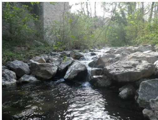
Photo 52 : Seuil de stabilisation du pont de la voie ferrée à Codalet
