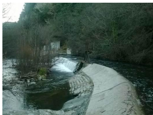
Photo 10 : Prise d'eau de la centrale hydroélectrique de Villefranche-de-Conflent (TET26 - ROE 45377)
