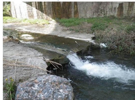
Photo 53 : Seuil de stabilisation du pont reliant la N116 à Prades
