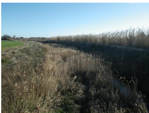
Photo 159 : Le Bourdigou au droit du pont de la D51
