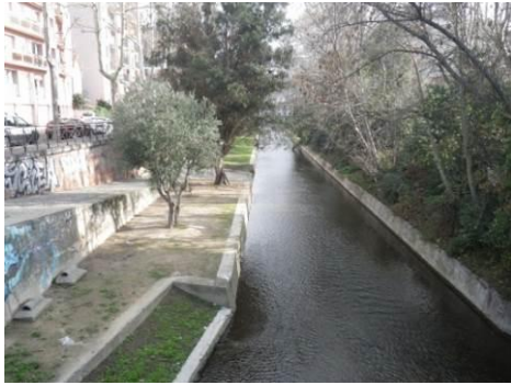
Photo 155 : La basse vue depuis le pont de l'avenue Georges Courteline
