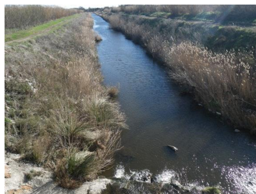
Photo 160 : Le Bourdigou au droit du pont de la D31
