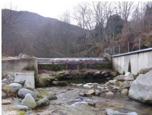
Photo 27 : Seuil de la prise d'eau de Py (ROE50043)
