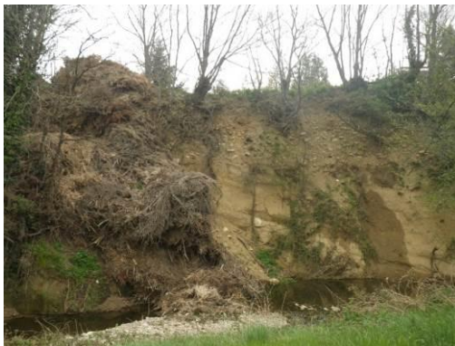
Photo 69 : Erosion rive droite probablement liées à une décharge de déchets végétaux
