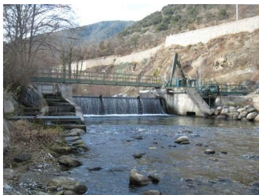
Photo 7 : Prise d'eau de Joncet (TET29 - ROE49900)
