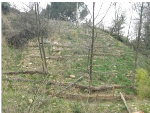
Photo 73 : Remblais en rive droite
