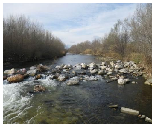
Figure 18 : Seuil de la prise d'eau des 4 Cazals (TET07 - ROE 45485)
