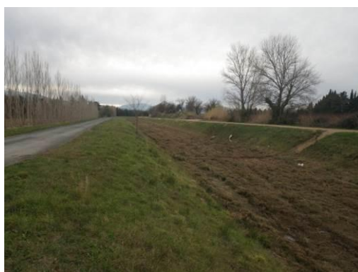
Photo 144 : Le Soler en amont d'un passage à gué (ROE51070)
