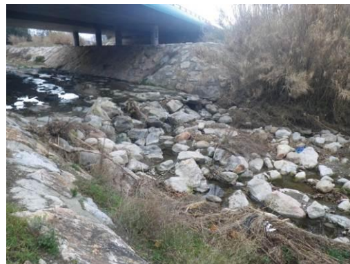
Photo 143 : Seuil sous le pont de la N116 (COM01, non ROE)
