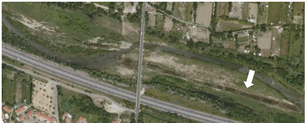
Pont de Millas - Orthophoto IGN® 2009 – Création d'un chenal d'écoulement préférentiel
