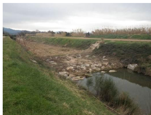
Photo 145 : Le Soler au niveau d'un seuil en enrochements (ROE51072)
