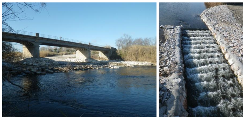
Photo 118 : Seuil de stabilisation du Pont de Canet-en-Roussillon et sa passe à poissons
