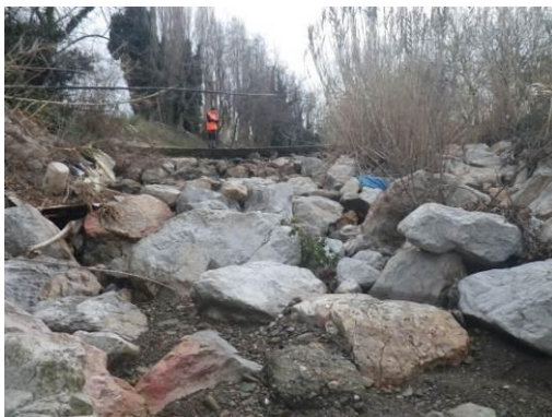
Photo 142 : Gué bétonné et enroché sur la Comelade (Non ROE)
