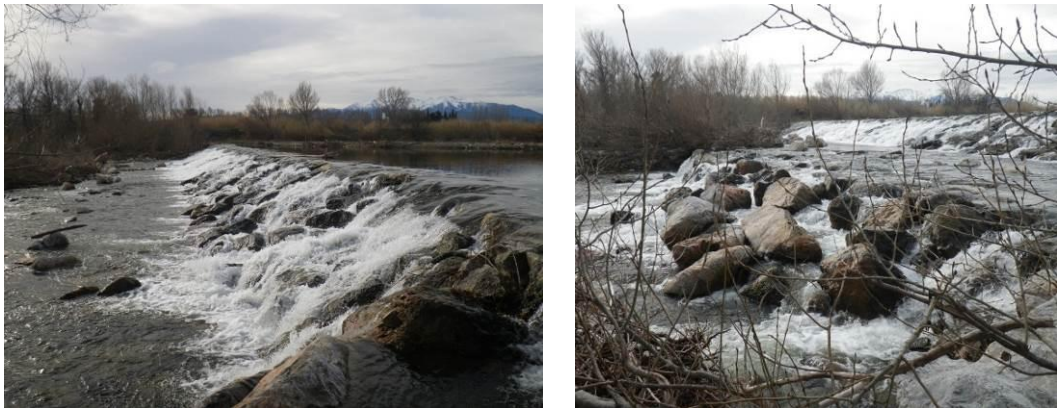
Photo 100 : Seuil de la prise d'eau du canal de Pézilla (TET13 - ROE36304)
