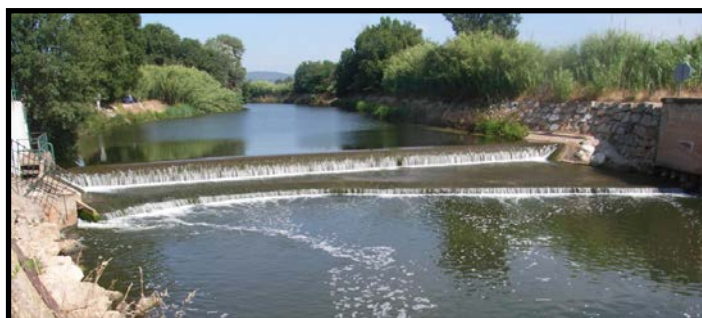
Figure 35 : Barrage antisel du Gapeau (MRM)
