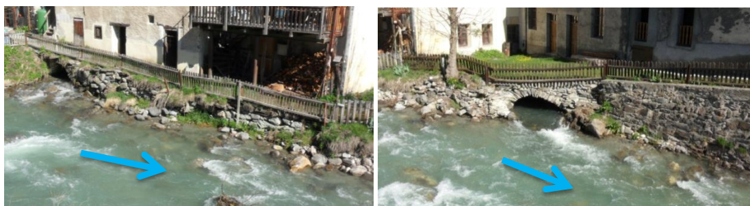
Fig. 87. Bâtiment au PK6350 en bordure de la Guisane (filature)
