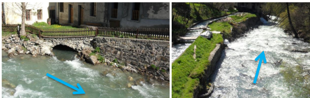
Fig. 28. Protections de berges dans la traversée de Chantemerle
