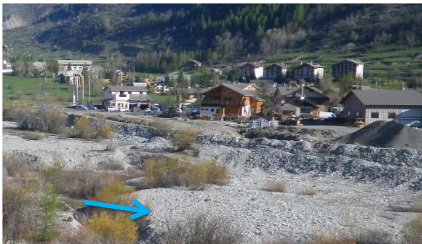
Fig. 21. Merlons sur les rives de la Guisane dans la zone de divagation
