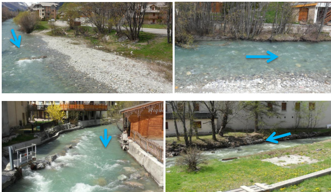
Fig. 81. Illustrations de la revanche localement faibles dans la traversée de Villeneuve (PK9800, 9400, 9000 et 8700)
