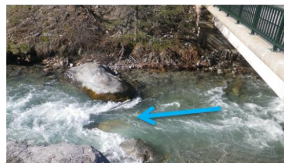
Pont Route du Club
