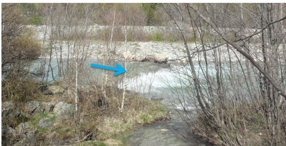
Fig. 10. Seuil au PK11320
