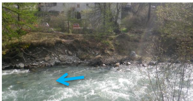
Fig. 79. Erosions de berges en l'absence de protections
