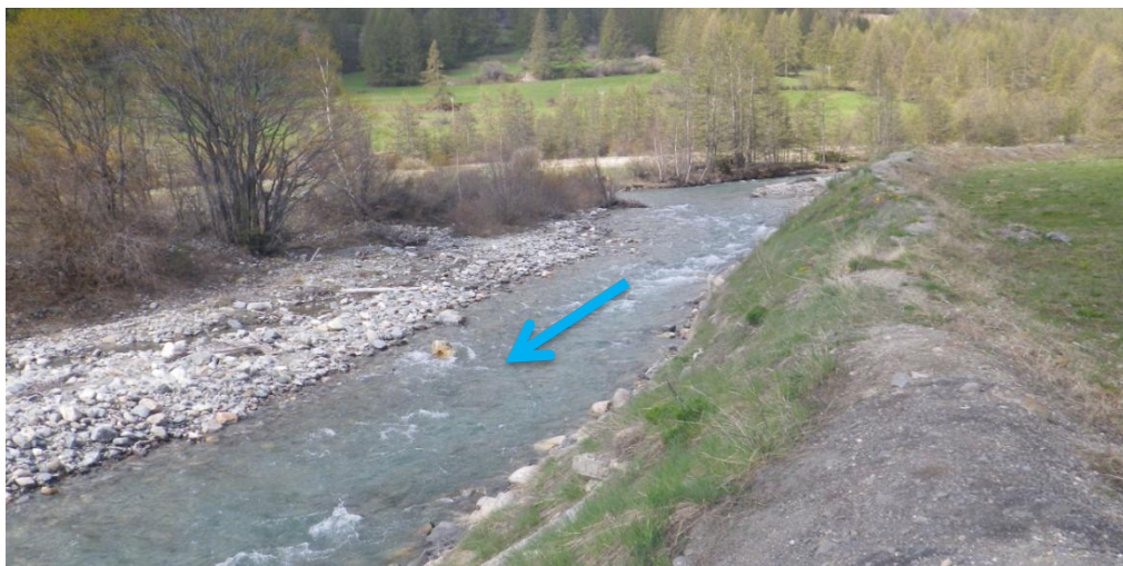
Fig. 17. Digue protégeant le camping et les étangs en aval du Casset
