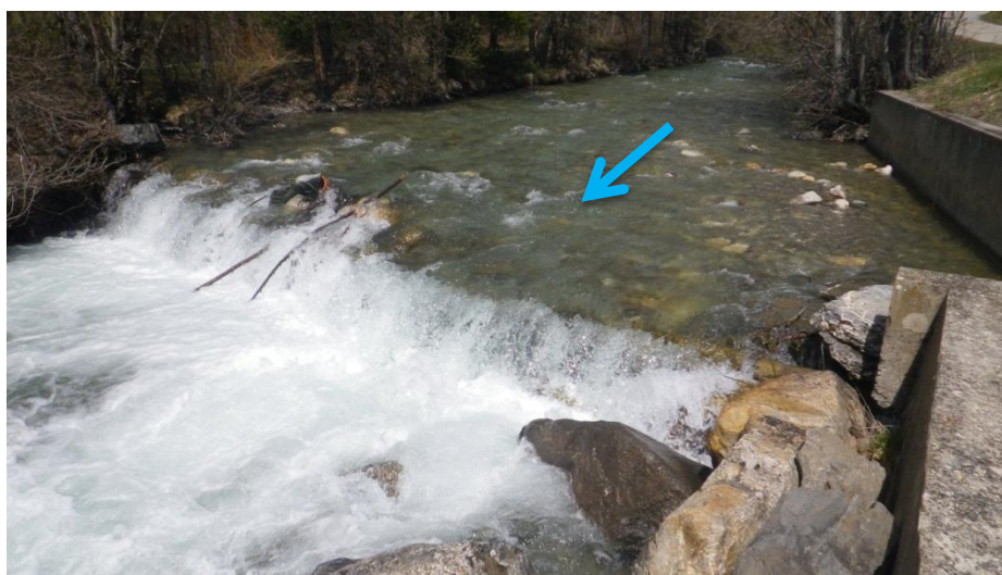
Fig. 8. Seuil au PK 18490
