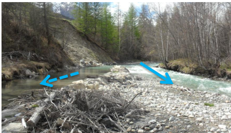
Fig. 9. Prise d'eau au PK11550
