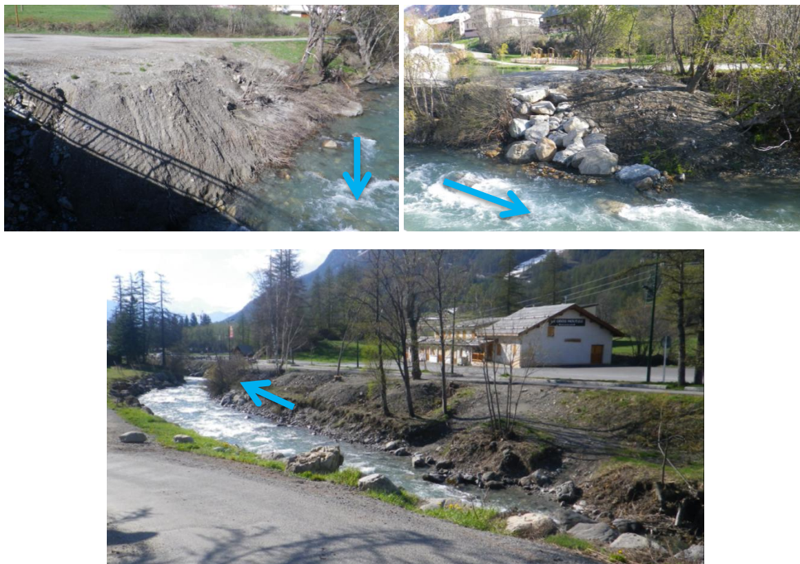
Fig. 19. Remblais dans le lit de la Guisane aux PK 14600, 14750 et 15000
