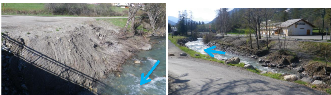
Fig. 75. Remblais dans le lit de la Guisane (PK15100 et 15000)
