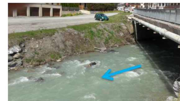
Pont de l'Envers (RD 1091)
