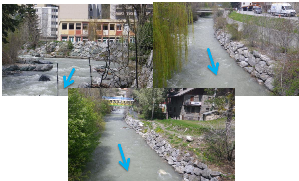
Fig. 32. Protections de berges dans la traversée de Briançon
