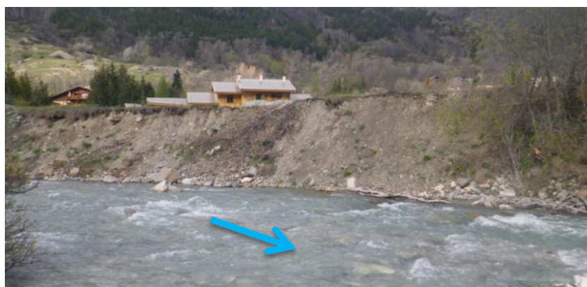
Fig. 80. Remblais construit dans le lit de la Guisane (PK12300)
