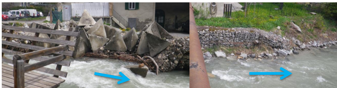
Fig. 33. Protections de berges en aval du PK400
