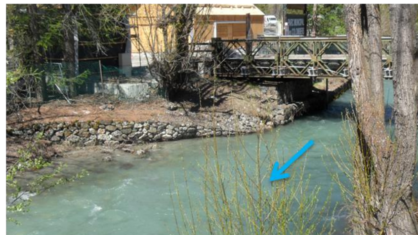
Pont du Parc des Colombers
