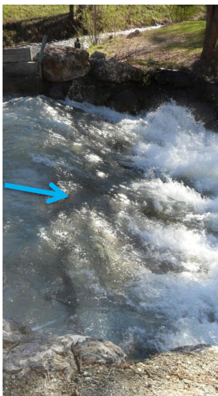
Fig. 12. Seuil au PK5220
