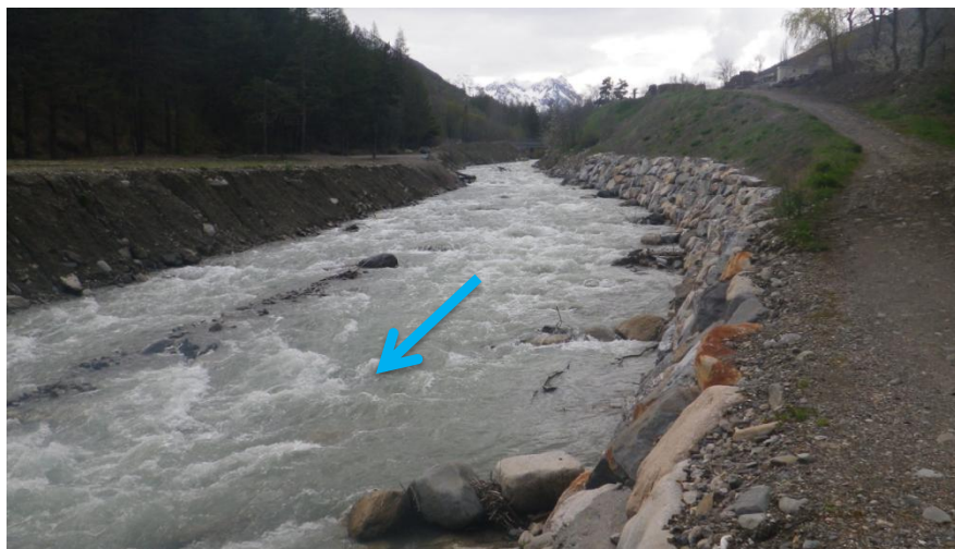
Fig. 30. Aménagements sur la Guisane en aval du pont Carle
