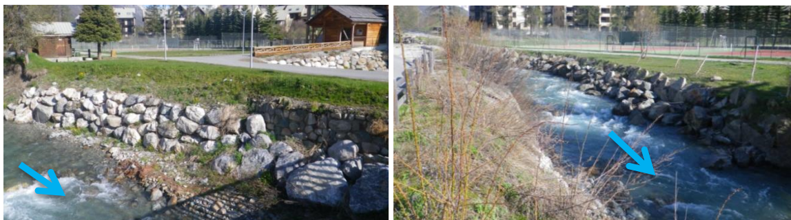
Fig. 73. Protections de berges en amont du PK14800
