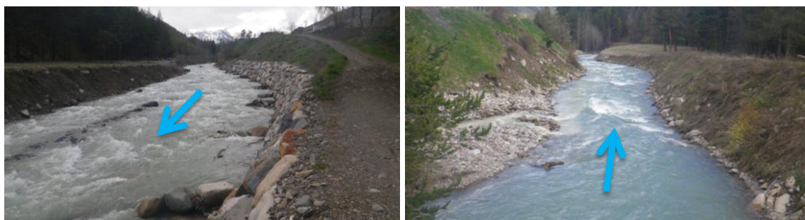
Fig. 90. Remblais établis dans le lit de la Guisane
