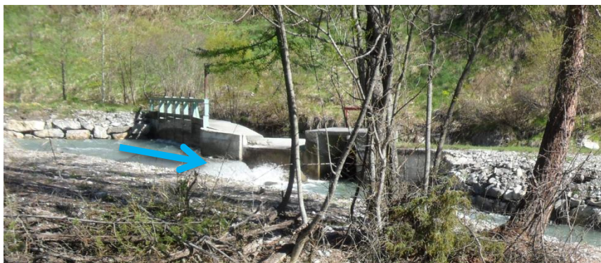
Fig. 11. Seuil au PK5840
