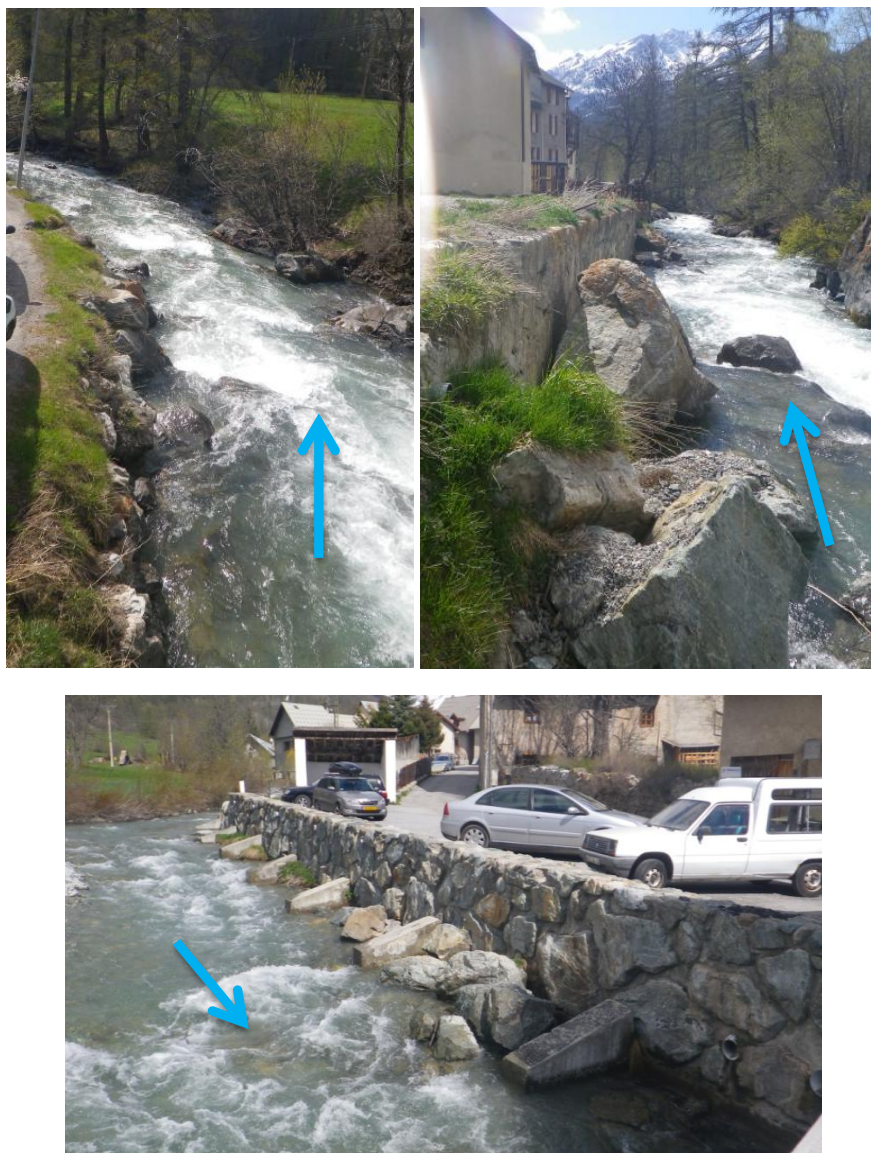
Fig. 16. Protections de berges en rive gauche dans la traversée du Casset (enrochements, muret)
