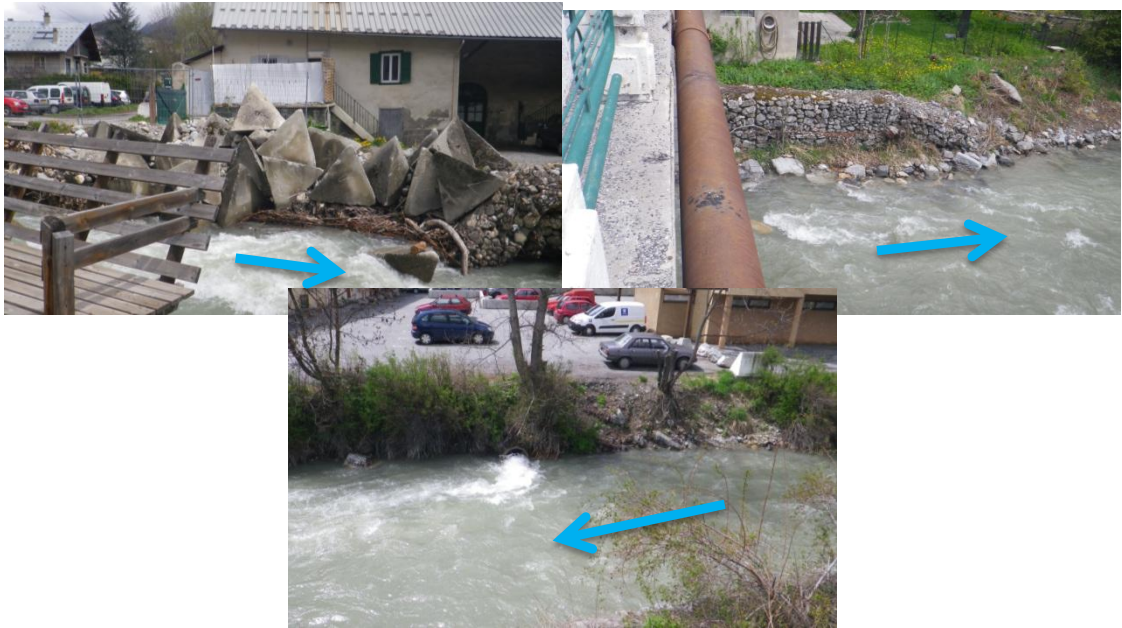
Fig. 93. Protections de berges déstabilisées ou dégradées sur les berges de la Guisane dans la traversée de Briançon (PK250, 300 et 350)
