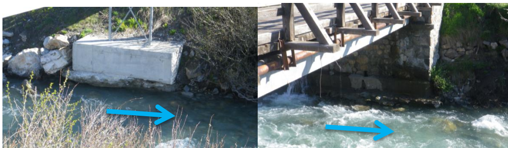
Fig. 49. Incisions observées au droit des ponts en aval de la commune du Monétier-les-Bains
