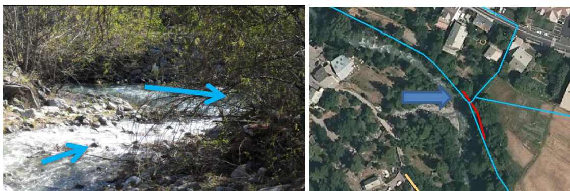
Fig. 89. Confluence de la Guisane et du torrent de Peytavin
