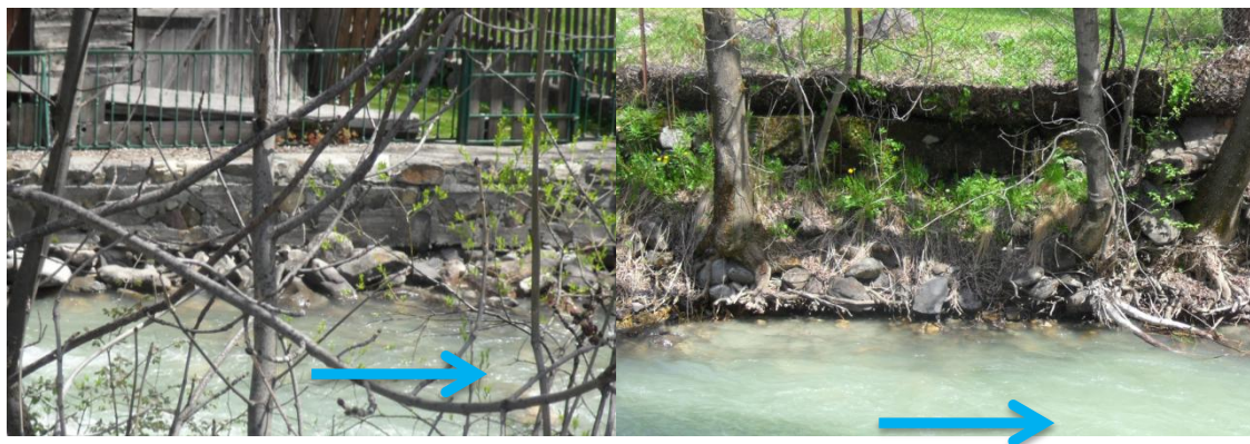
Fig. 59. Signes d'incisions observables sur les ouvrages et les berges dans la traversée de Villeneuve
