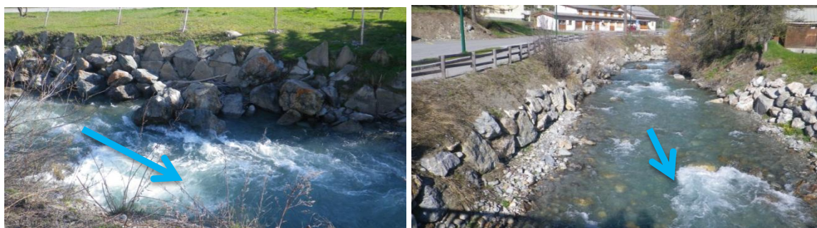
Fig. 18. Protections de berges dans la partie amont de la traversée du Monétier-les-Bains
