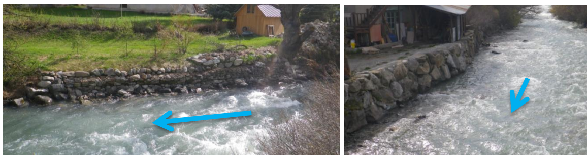
Fig. 22. Protections de berges dans le hameau des Guibertès (gabions et enrochements)
