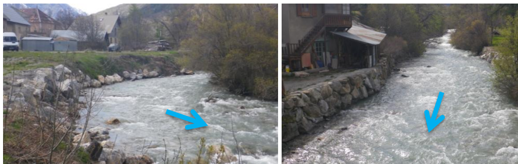
Fig. 78. Protections de berges au hameau des Guibertes
