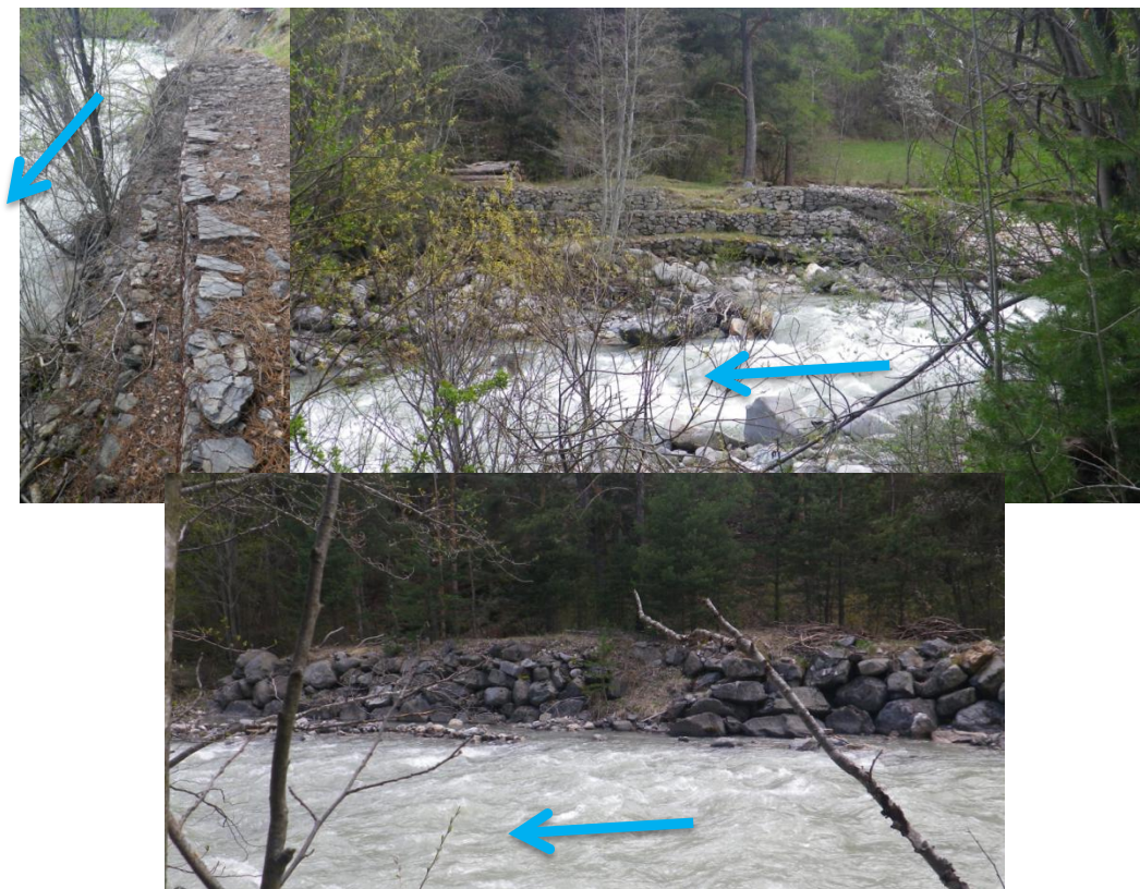
Fig. 31. Protections de berges ponctuelles en aval du pont de Carle
