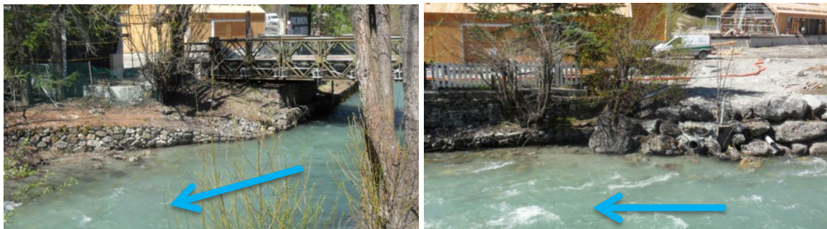
Fig. 86. Zone de faible revanche hydraulique au droit de la base de loisir alors en cours de construction
