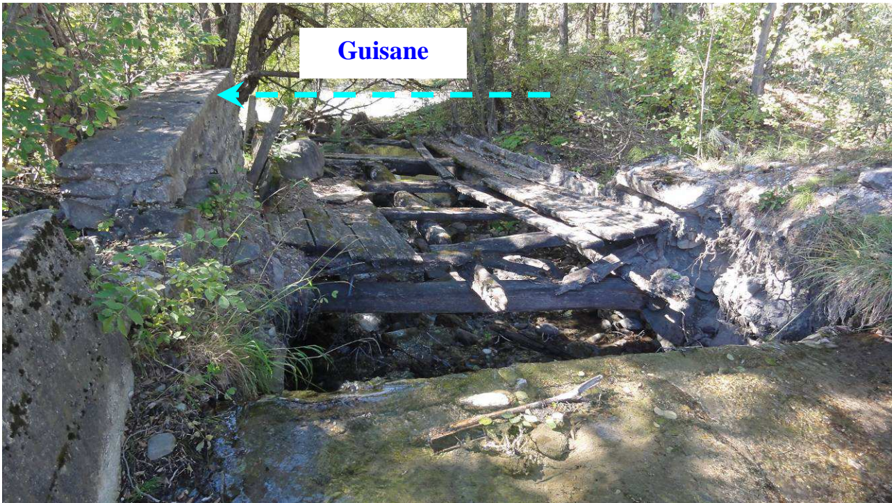
Photo 43 : Lit terminal du torrent de la Salle avant la Guisane.
