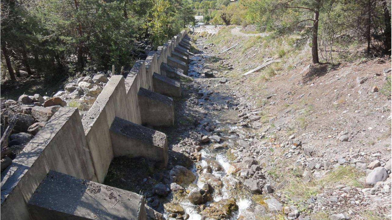
Photo 41 : Protection massive au sommet du cône de déjection.
