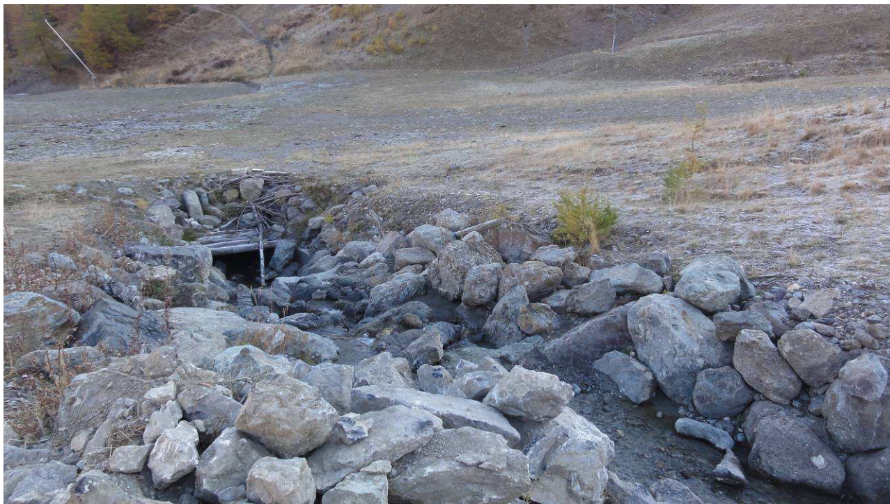
Photo 31 : Couverture de la partie amont du torrent de Glaize.
