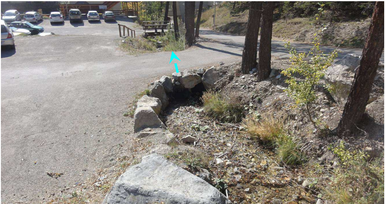
Photo 74 : Lit busé du torrent de Régulier.
