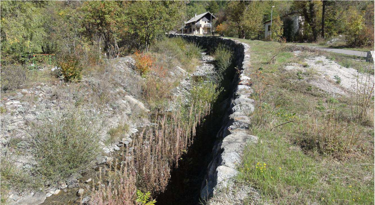
Photo 42 : Endiguement dissymétrique de la partie aval du torrent de la Salle.
