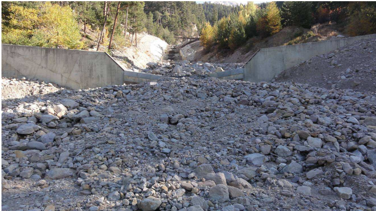
Photo 56 : Seuils et ensemble de barrages sur le Verdarel.
