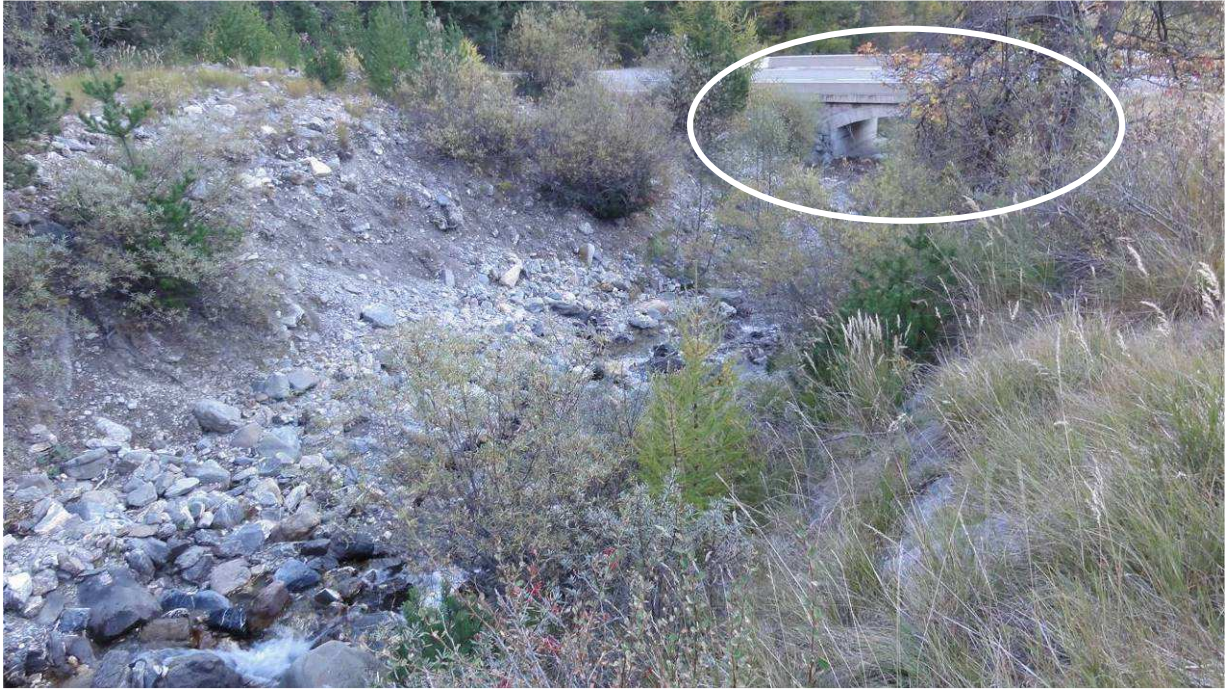
Photo 3 : Pont de la RD1091 dans le secteur à forte pente du torrent de la Pisse.
