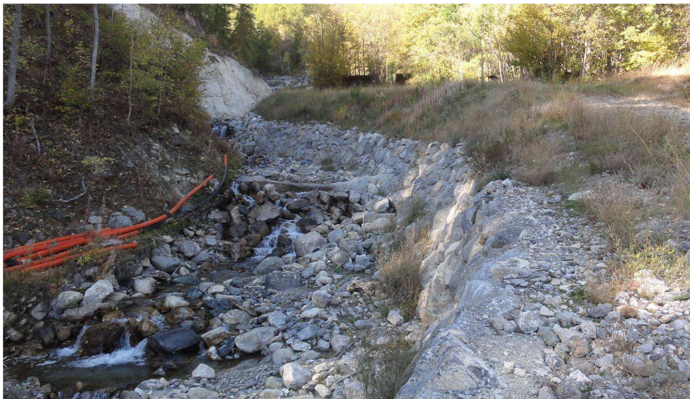
Photo 36 : Lit aval de la plage de dépôt.
