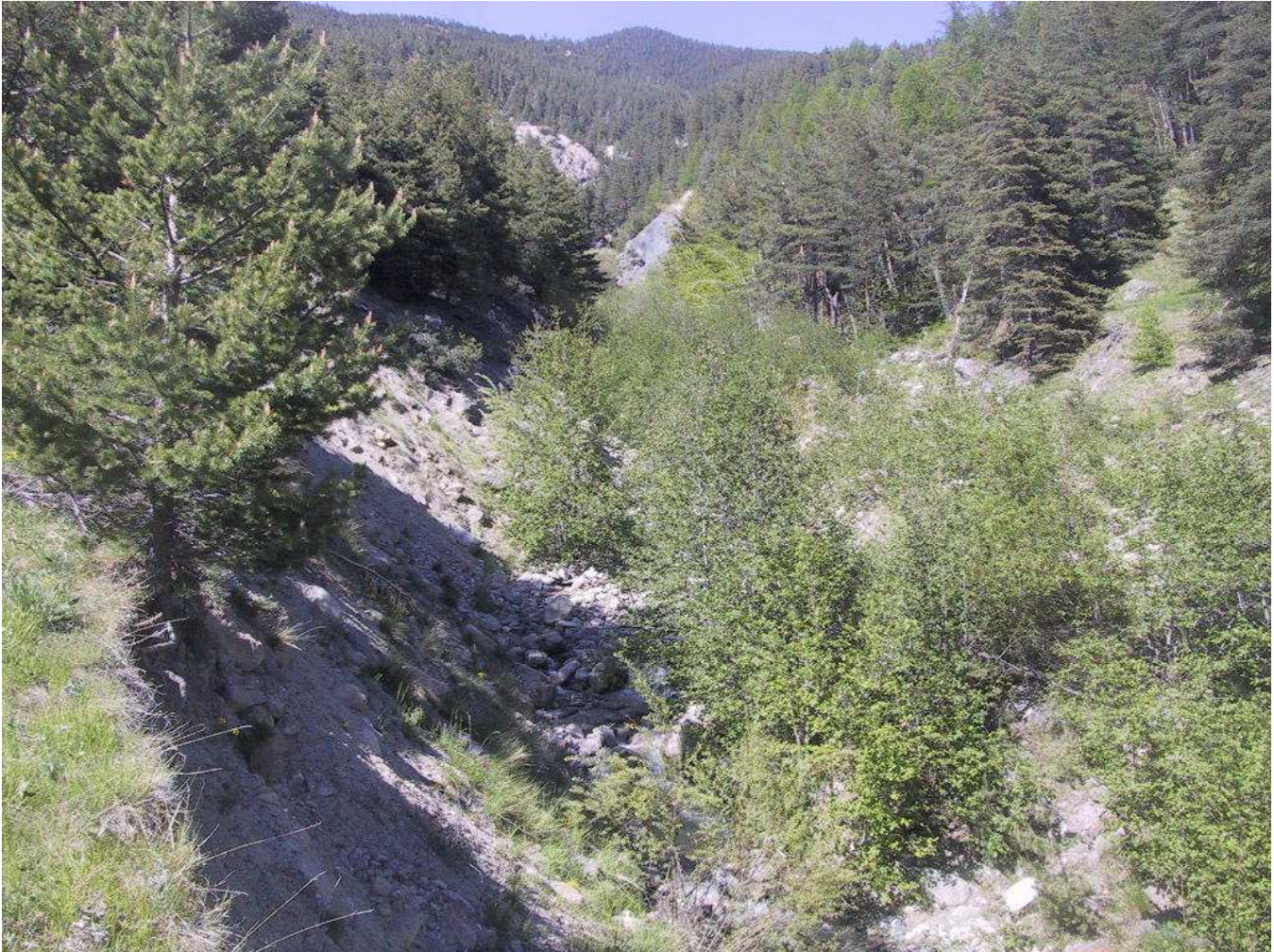
Photo 58 : Partie terminale des gorges du Verdarel.
