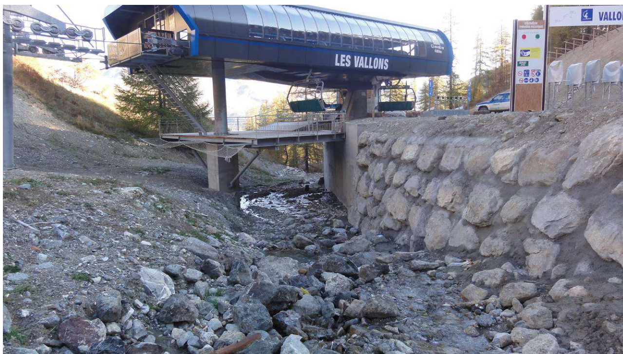
Photo 30 : Gare de départ du Télésiège des Vallons.
