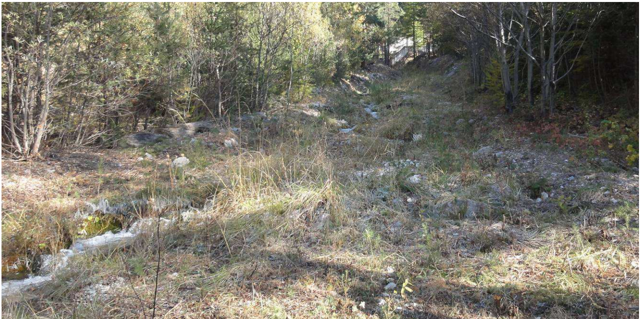
Photo 70 : Élargissement du lit et régulation du transport solide en amont du village.
