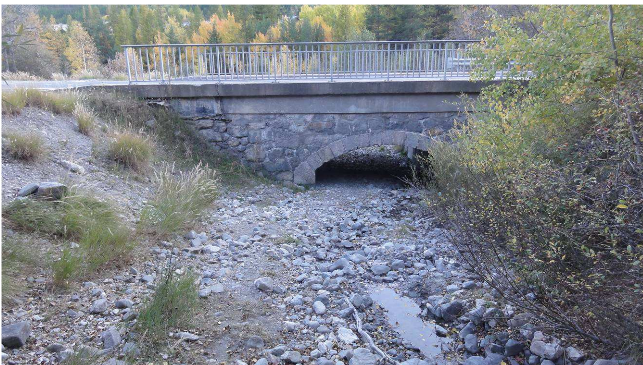
Photo 25 : Pont de la RN91, visiblement engravé, sur le torrent du Merdarel.
