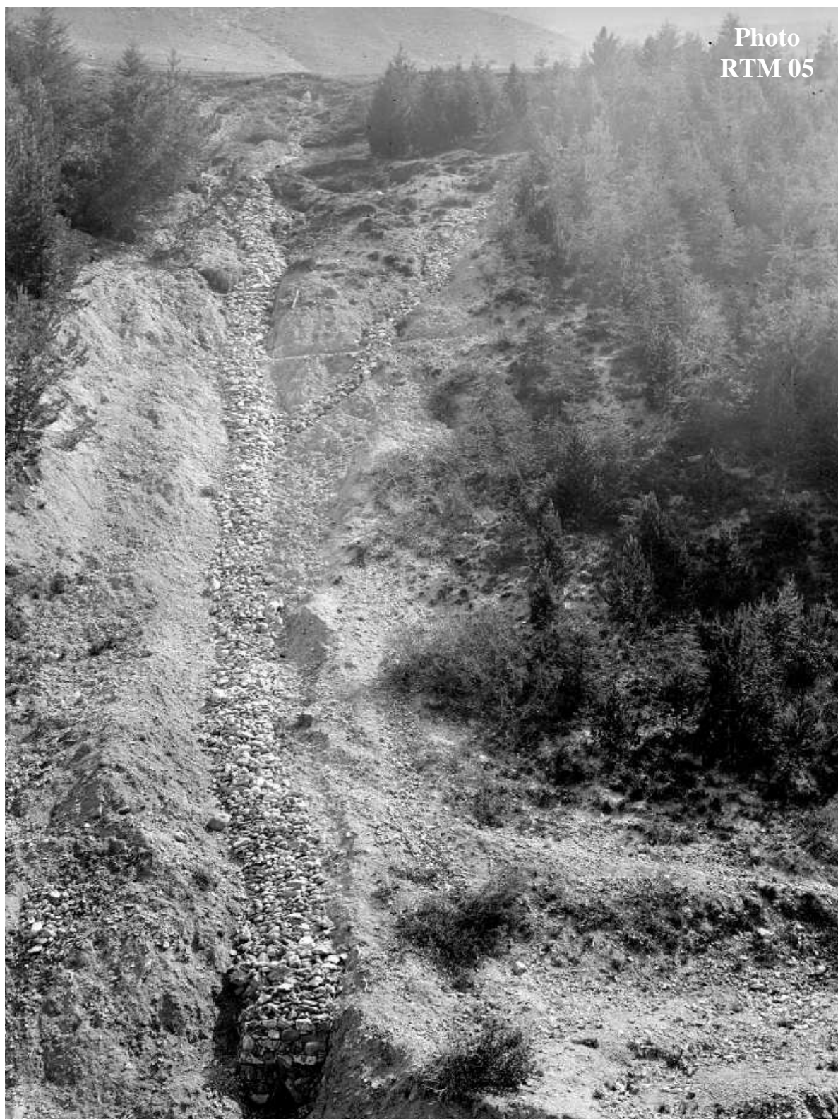
Figure 15 : Drain réalisé par le RTM dans le bassin versant du St Joseph.
