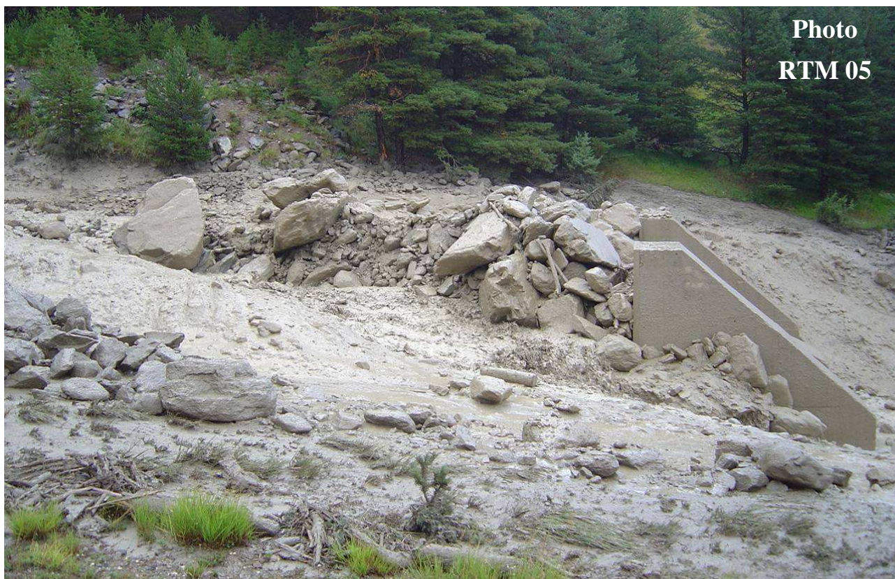
Photos 59 & 60 : Plage de dépôt du Verdarel et dents freineuses.
