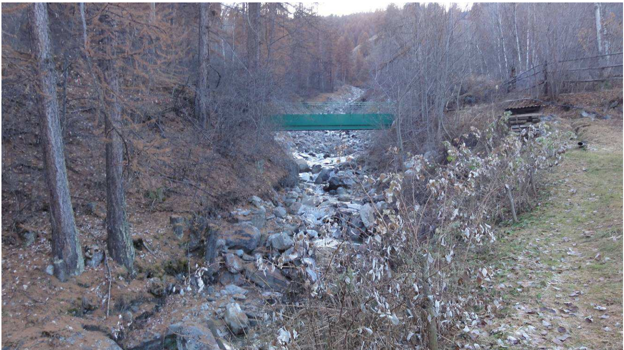
Photo 52 : Lit recalibré en amont du cône de déjection du Peytavin.
