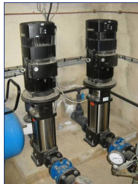
Illustration 18 : Filtres à sable et groupe de pompe de la station de pompage des Garrigues
