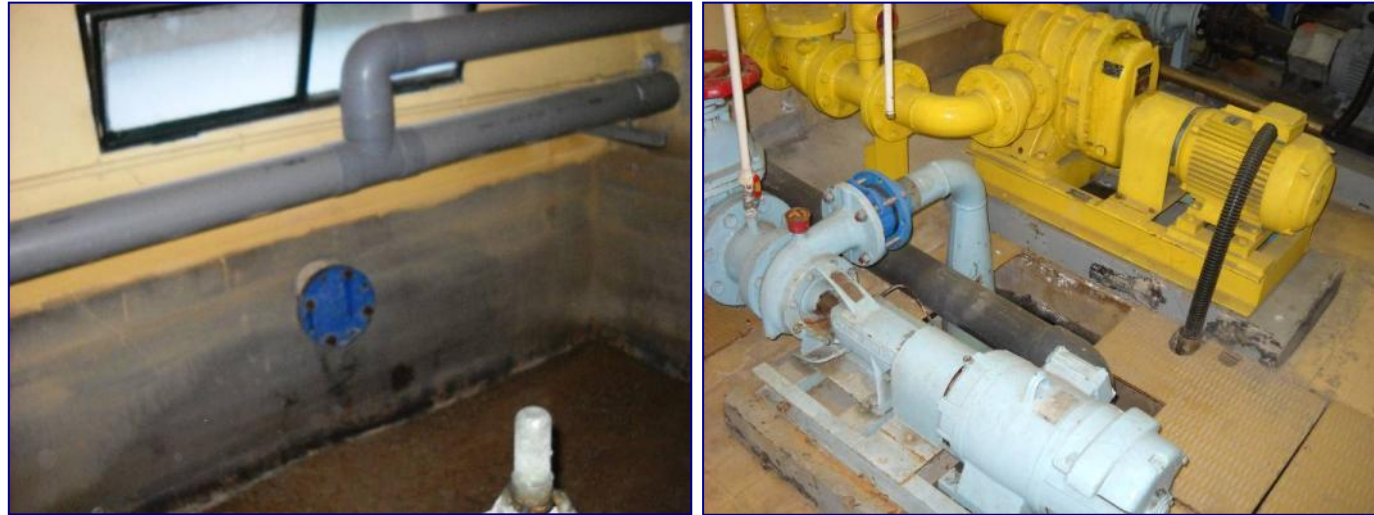
Illustration 8 : Filtre à sable destiné aux eaux brutes en provenance du réseau de la SCP & le dispositif de nettoyage du filtre (pompe à air en jaune et pompe à eau en bleu).
