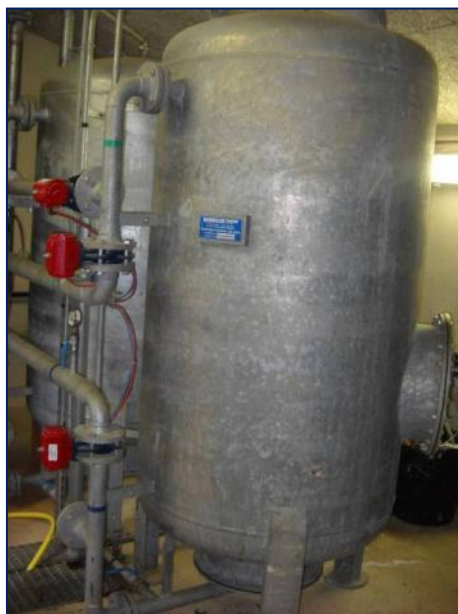
Illustration 18 : Filtres à sable et groupe de pompe de la station de pompage des Garrigues
