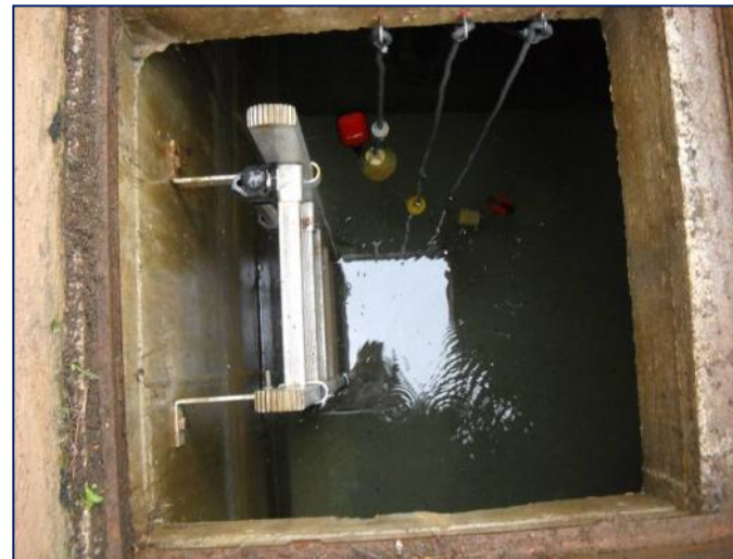
Illustration 20 : Bache de stockage de la station de pompage des Garrigues
