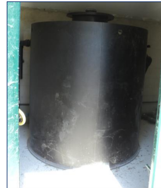
Illustration 15 : Cuve en polyéthylène de 3 m 3 .
