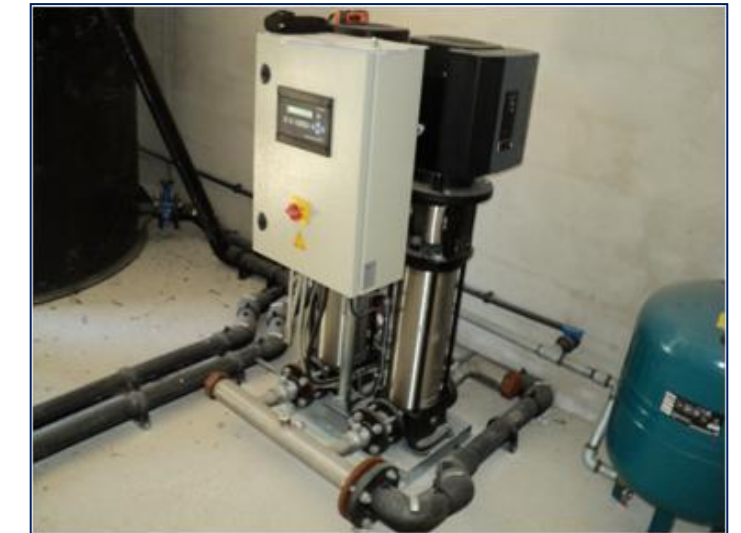
Illustration 16 : Groupe de pompes à vitesse variable
