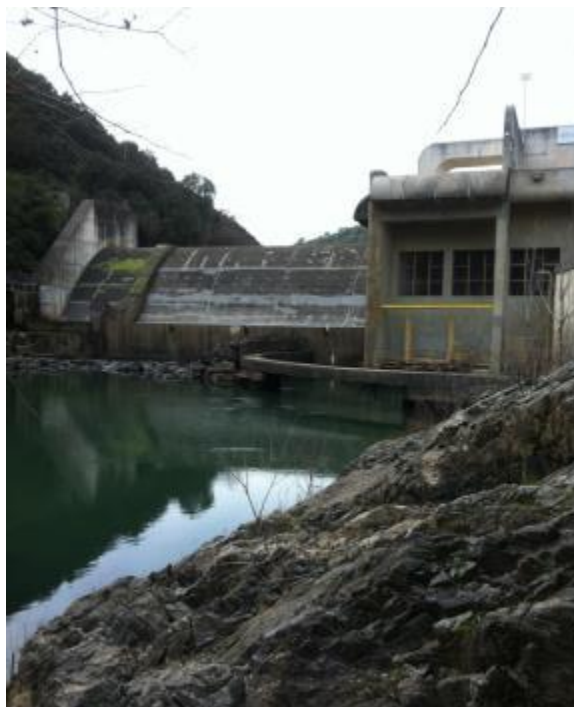
Figure 18 : Barrage et usine de Tanneron-Le-Tignet Source : GEI
