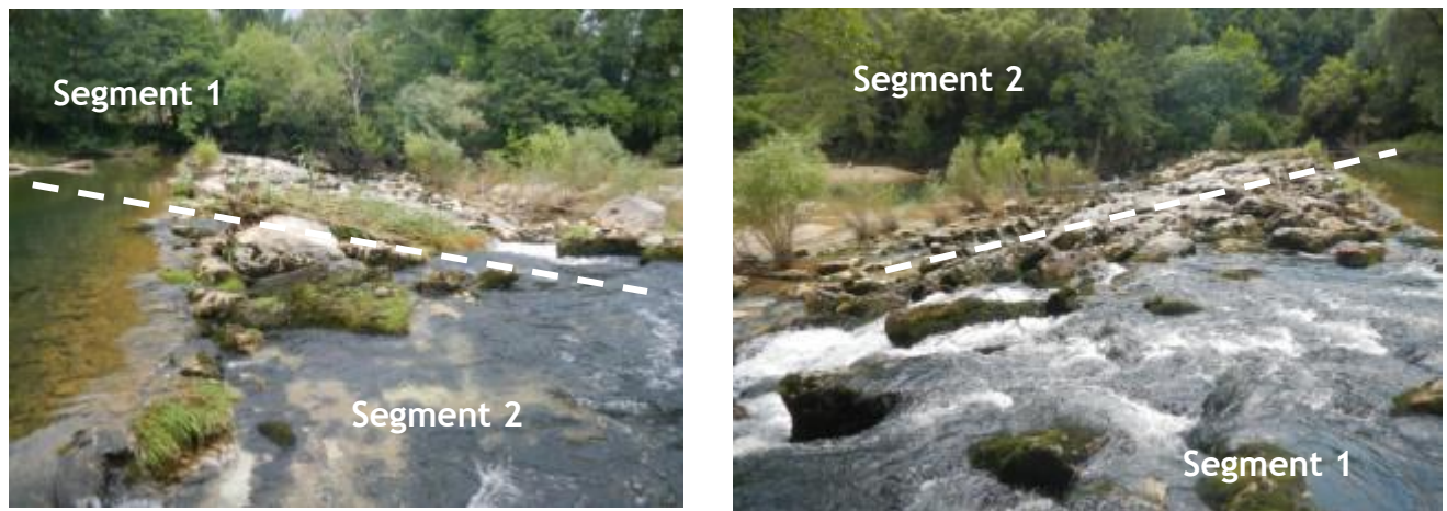
Figure 34 : Vues des profils du seuil depuis la rive droite puis la rive gauche Source : GEI
