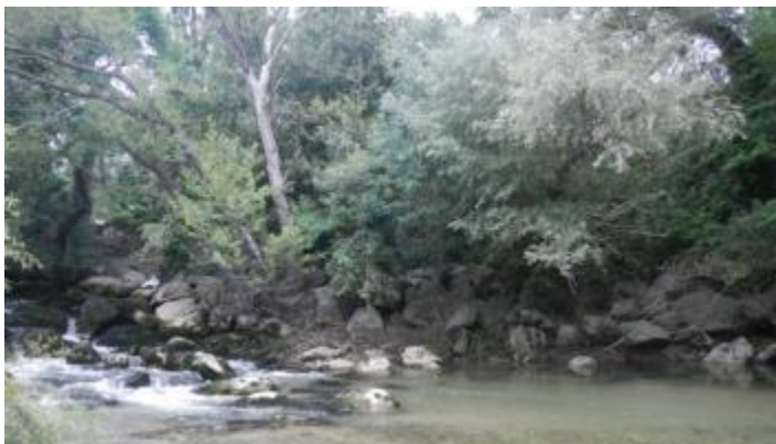
Figure 37 : Berge de rive gauche protégée par des enrochements dont le réglage a évolué au fil du temps Source : GEI
