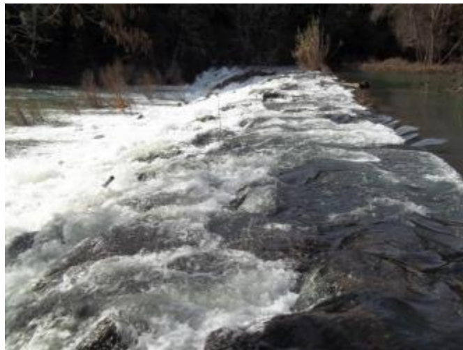
Figure 35 : Déversement sur le seuil en février 2013 Source : GEI
