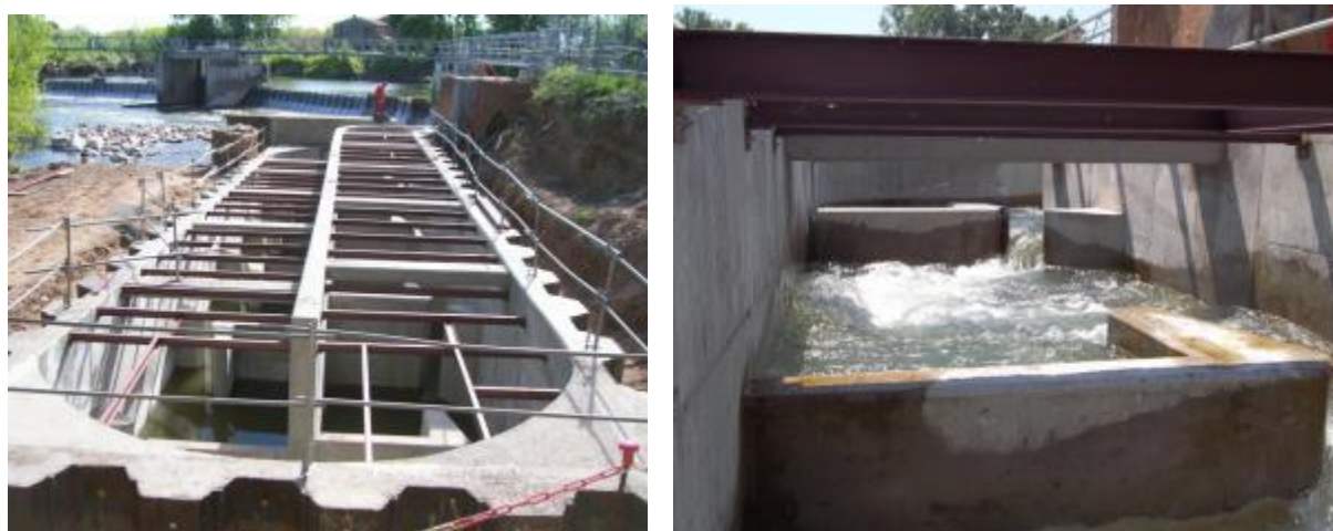
Figure 53 : Passe à fentes verticales latérales profondes sur la cours aval de l'Hérault en travaux et en eau
