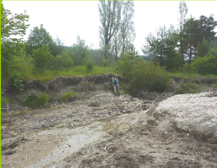
Erosion de berge
