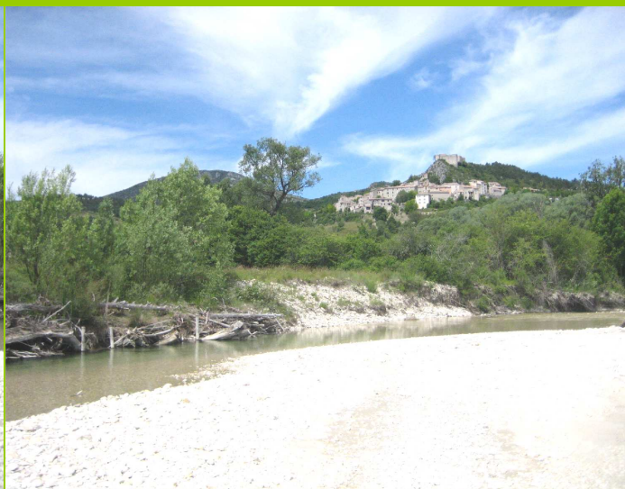
Zone érodée à l'aval à protéger
