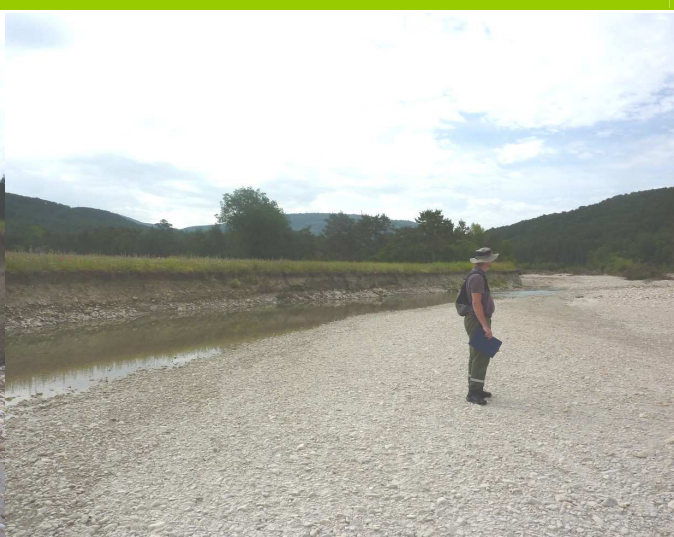
Erosion de berge aval
