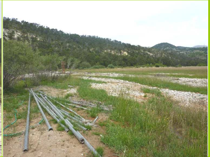
Alluvions déposés suite au contournement du merlon
