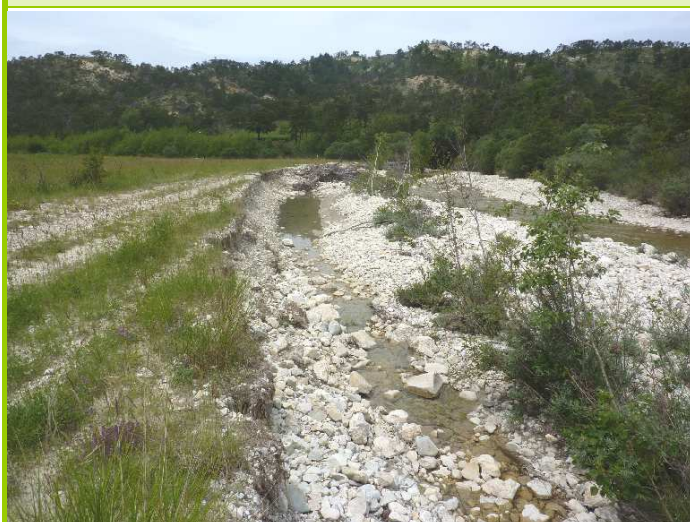
Erosion de berge en amont de la plaine de la Braïsse : possibilité de confortement au moyen d'un peigne
