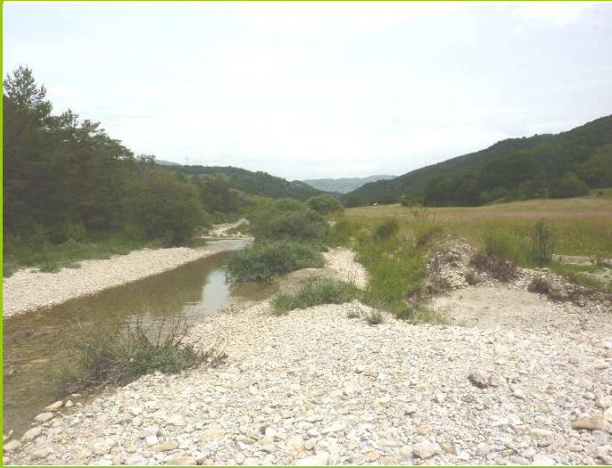
Brèche dans le merlon vue vers l'amont
