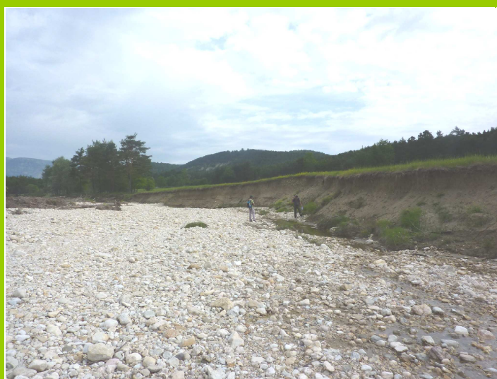
Erosion de berge amont
