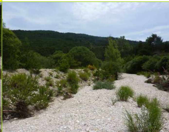
Merlon et atterrissement en amont du seuil de la Braïsse - vue vers l'aval
