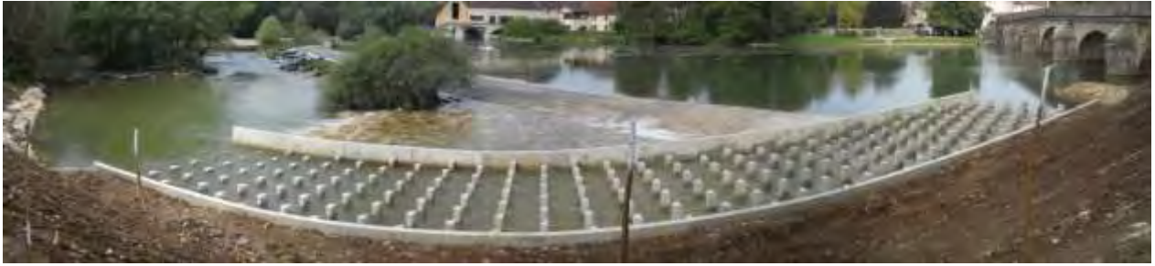
Ouvrage de type rampe en enrochements régulièrement reparties
