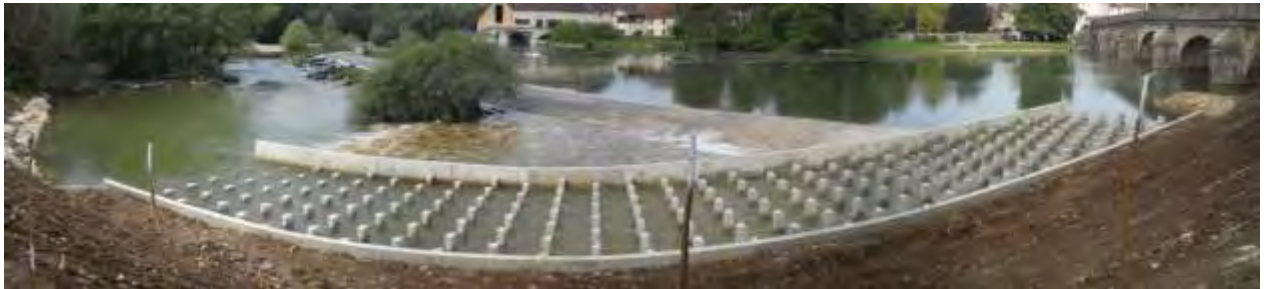
Ouvrage de type rampe en enrochements régulièrement reparties
