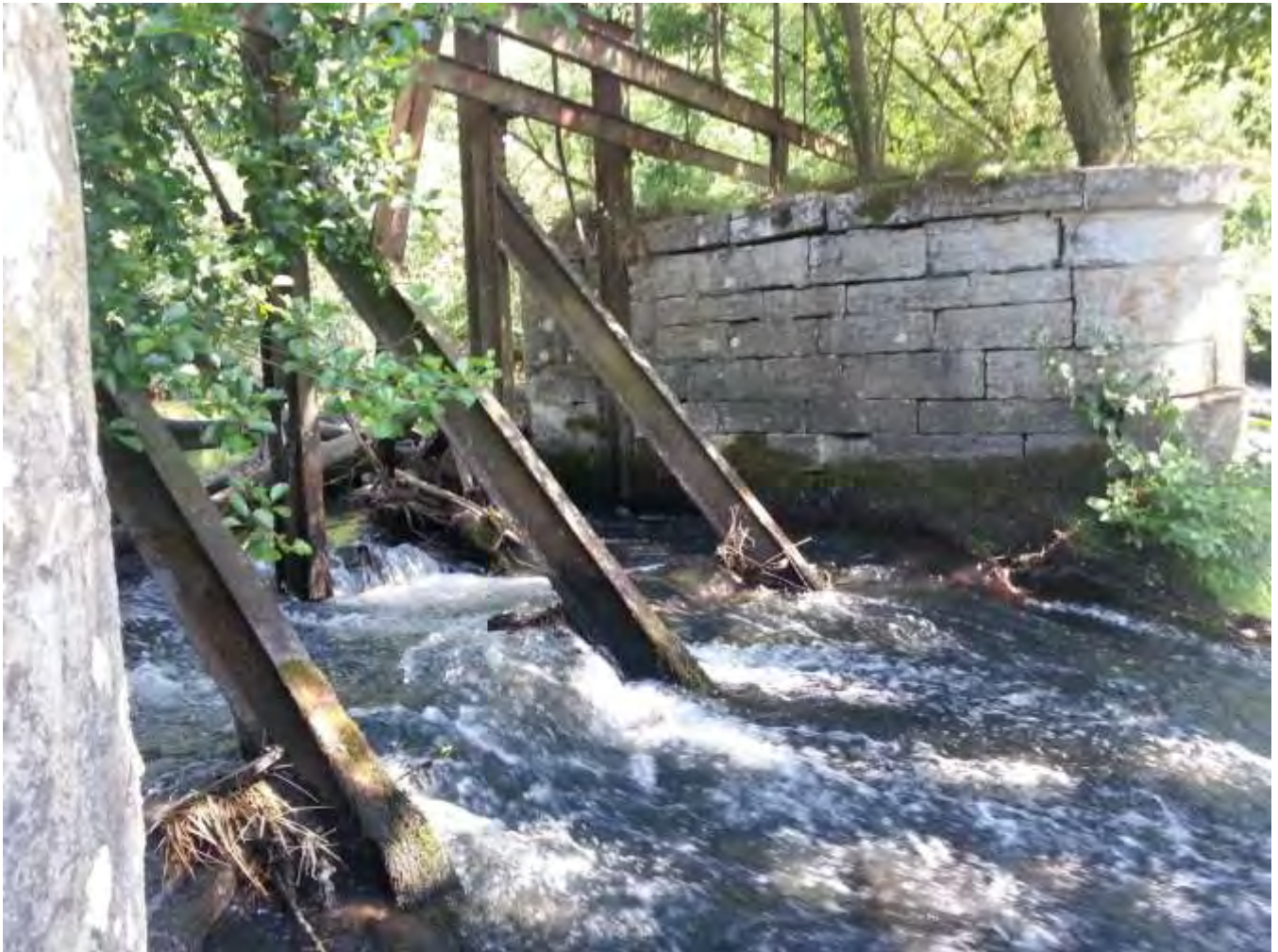
Vannes en rive gauche
