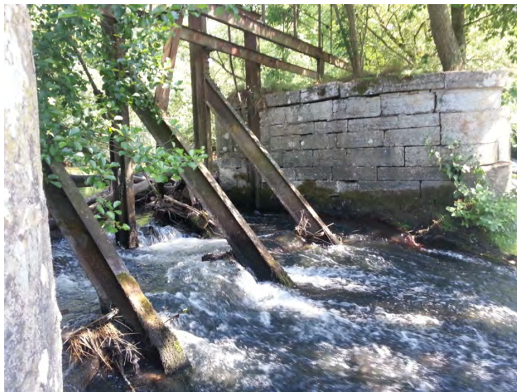
Vannes en rive gauche
