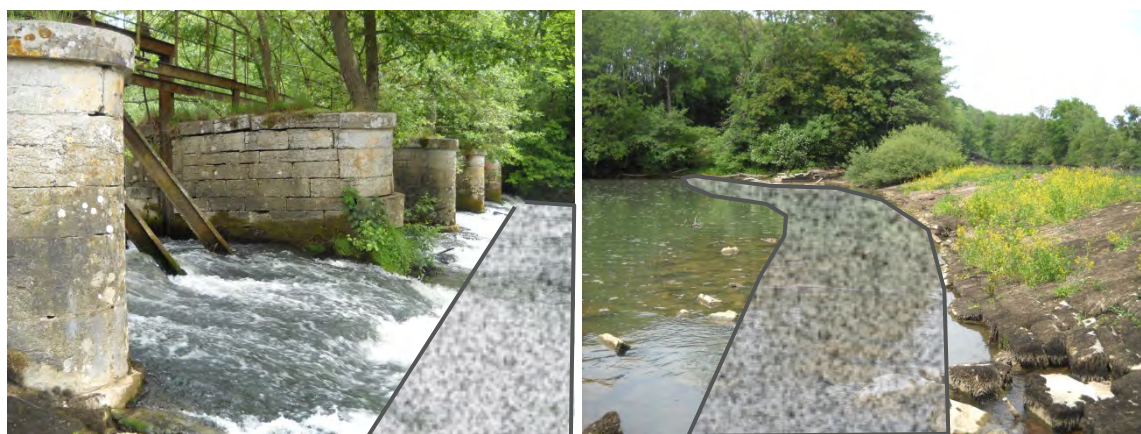
Figure 9 Emplacement de la piste dans le lit mineur pour l'accès au seuil
