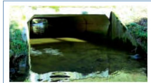
Reconstitution d'un fond naturel à l'intérieur de l'ouvrage
