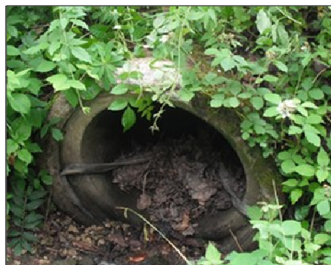
Figure 56 : Photographie de l'ouvrage Pro_1 (aval)
