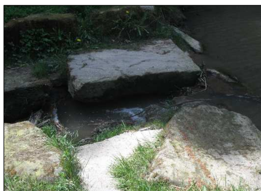
Figure 16 : Photographie de l'ouvrage Chn_3
