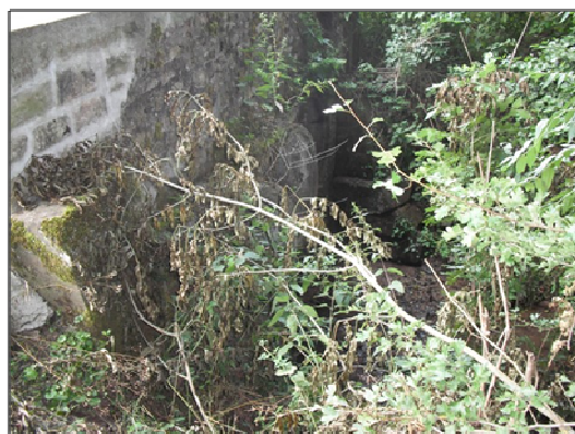
Figure 90 : Photographie de l'ouvrage OH_SIC_4
