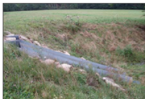
Figure 77 : Photographie de l'ouvrage OH_AUG_1
