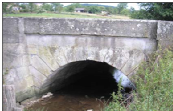
Figure 40 : Photographie de l'ouvrage OH_AIL_7 (amont)
