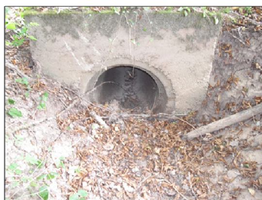
Figure 78 : Photographie de l'ouvrage OH_GDP_3
