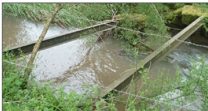
Figure 3 : Photographie de l'ouvrage OH_MOU_2
