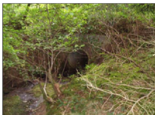
Figure 54 : Photographie de l'ouvrage OH_PRO_1
