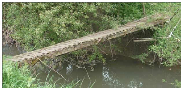
Figure 7 : Photographie de l'ouvrage OH_MOU_8
