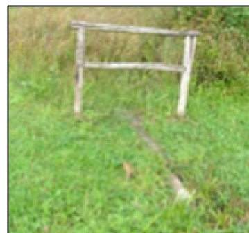
Figure 75 : Photographie de l'ouvrage OH_EPI_9
