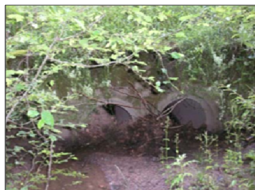
Figure 52 : Photographie de l'ouvrage OH_FCN_1 (aval)
