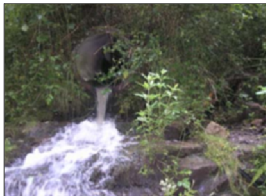
Figure 72 : Photographie de l'ouvrage OH_DEY_1
