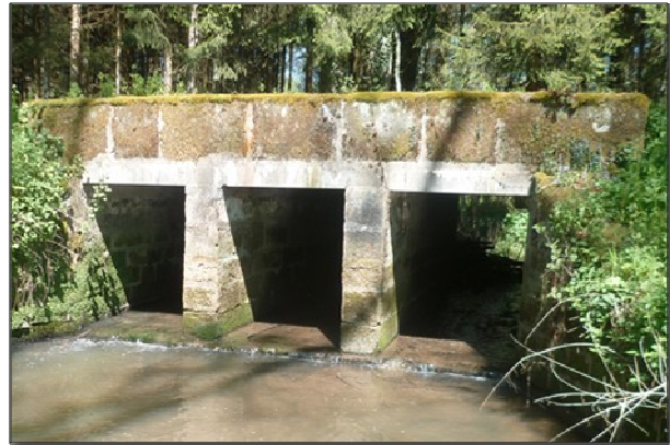
Figure 10 : Photographie de l'ouvrage OH_MOU_11
