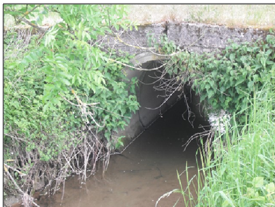
Figure 23 : Photographie de l'ouvrage OH_BOX_3
