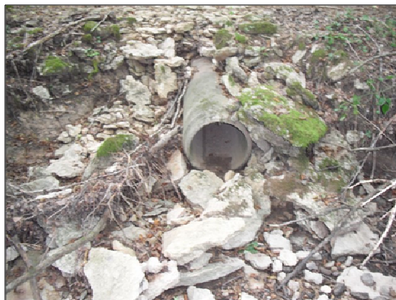
Figure 80 : Photographie de l'ouvrage OH_GDP_6
