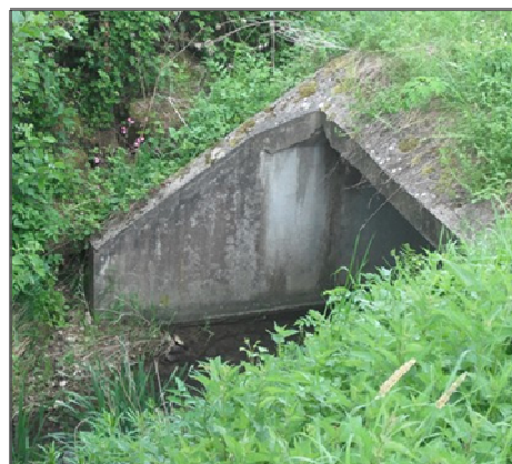
Figure 28 : Photographie de l'ouvrage OH_MOY_1
