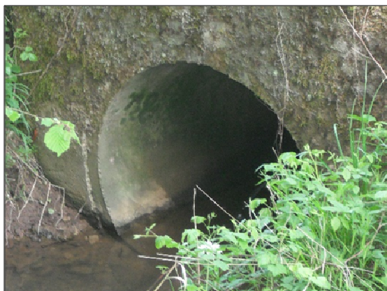
Figure 18 : Photographie de l'ouvrage OH_CHN_3
