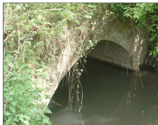
Figure 8 : Photographie de l'ouvrage OH_MOU_9
