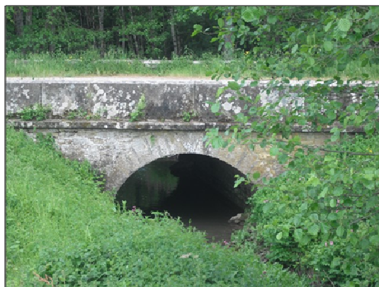
Figure 29 : Photographie de l'ouvrage OH_MOY_2
