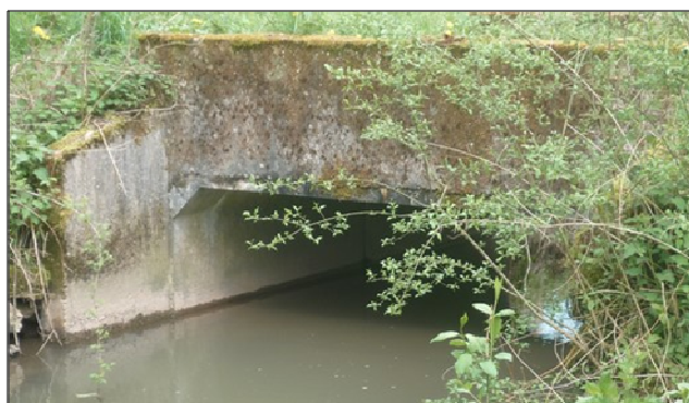
Figure 5 : Photographie de l'ouvrage OH_MOU_6
