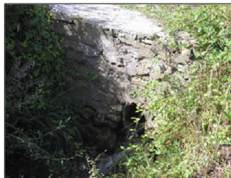
Figure 70 : Photographie de l'ouvrage OH_DUR_6
