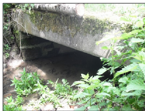
Figure 33 : Photographie de l'ouvrage OH_PAV_1
