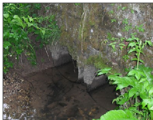
Figure 48 : Photographie de l'ouvrage OH_QUF_3
