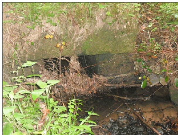
Figure 47 : Photographie de l'ouvrage OH_QUF_2 (amont)
