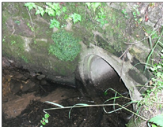
Figure 46 : Photographie de l'ouvrage OH_QUF_1
