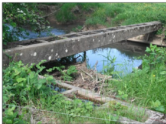
Figure 4 : Photographie de l'ouvrage OH_MOU_3
