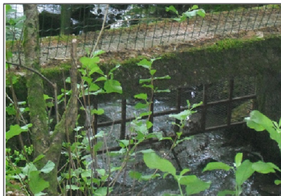
Figure 13 : Photographie de l'ouvrage OH_ETG_2
