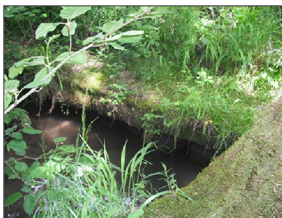
Figure 26 : Photographie de l'ouvrage Box_5
