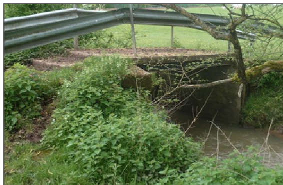
Figure 2 : Photographie de l'ouvrage OH_MOU_1
