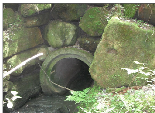
Figure 14 : photographie de l'ouvrage Chn_1
