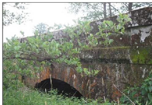
Figure 60 : Photographie de l'ouvrage OH_REG_3 (aval)
