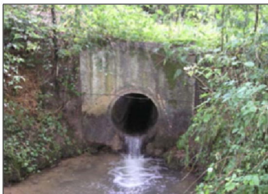
Figure 69 : Photographie de l'ouvrage OH_TAC_4
