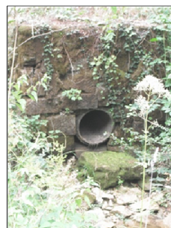
Figure 79 : Photographie de l'ouvrage OH_GDP_4
