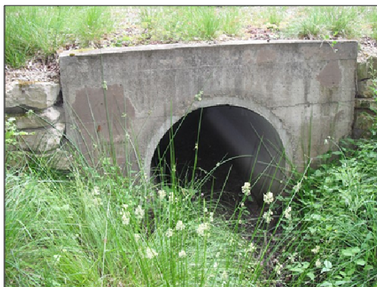
Figure 49 : Photographie de l'ouvrage Quf_1 (aval)
