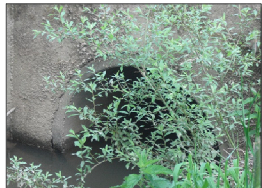
Figure 11 : Photographie de l'ouvrage Etg_1
