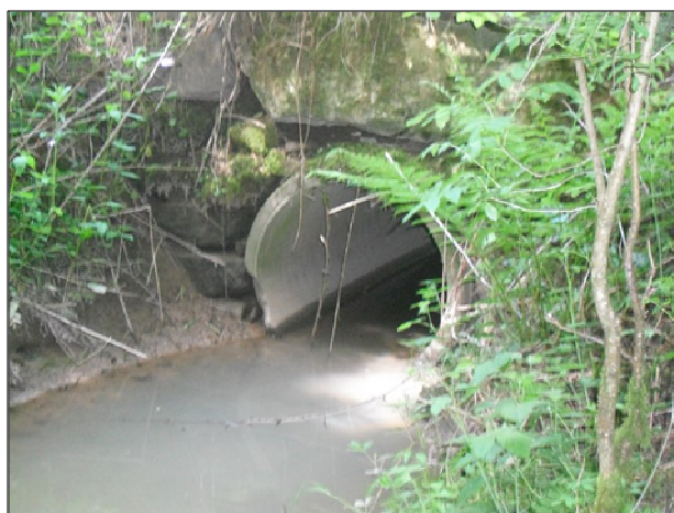
Figure 20 : Photographie de l'ouvrage OH_ORA_1
