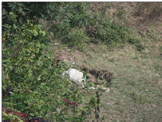
Figure 68 : Photographie de l'ouvrage OH_FAG_2
