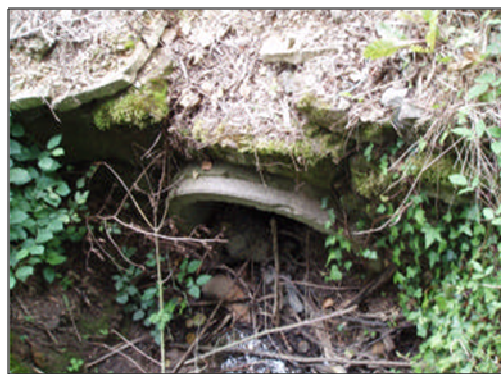
Figure 27 : Photographie de l'ouvrage OH_BOX_8
