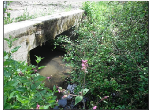
Figure 30 : Photographie de l'ouvrage OH_MOY_3
