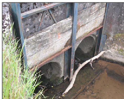
Figure 38 : Photographie de l'ouvrage OH_AIL_4 (amont)
