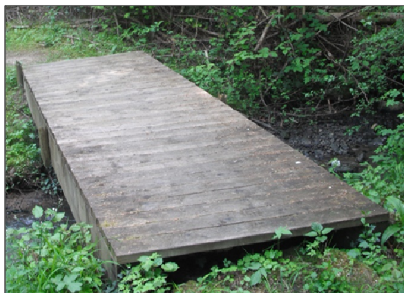
Figure 15 : Photographie de l'ouvrage Chn_2
