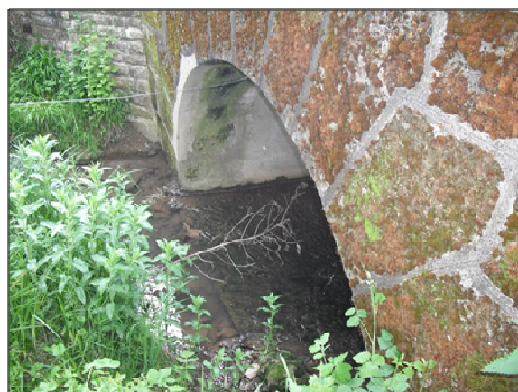
Figure 25 : Photographie de l'ouvrage OH_BOX_6
