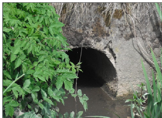
Figure 19 : Photographie de l'ouvrage OH_CHN_4
