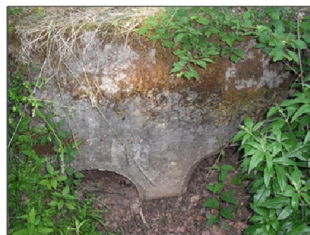
Figure 53 : Photographie de l'ouvrage Fcn_2 (aval)
