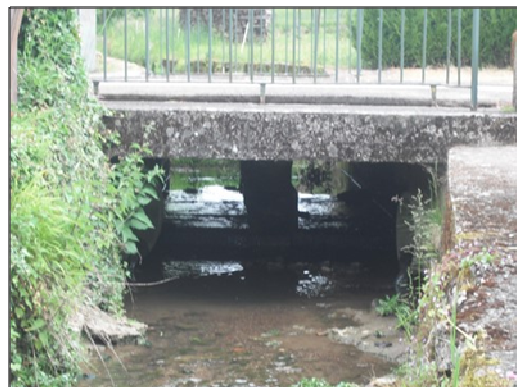
Figure 62 : Photographie de l'ouvrage OH_REG_5 (aval)
