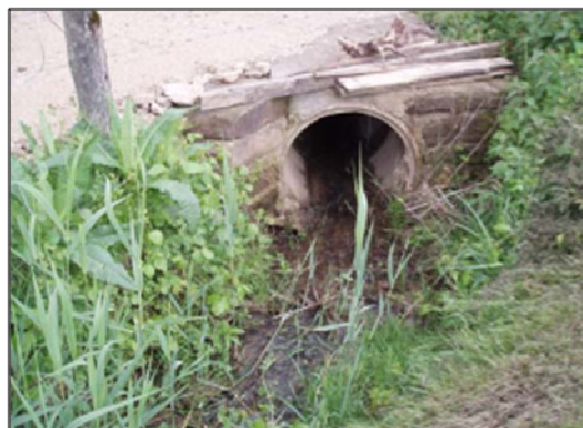
Figure 63 : Photographie de l'ouvrage OH_REG_6 (aval)
