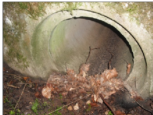
Figure 51 : Photographie de l'ouvrage Fcn_1 (amont)
