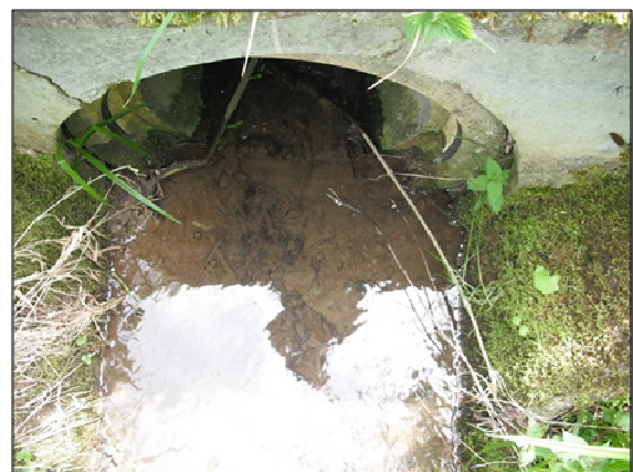
Figure 32 : Photographie de l'ouvrage OH_BRE_5
