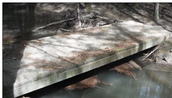
Figure 17 : Photographie de l'ouvrage Chn_4
