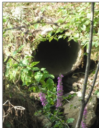
Figure 81 : Photographie de l'ouvrage OH_GDP_7
