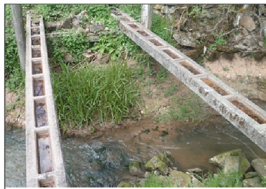
Figure 9 : Photographie de l'ouvrage Mou_2
