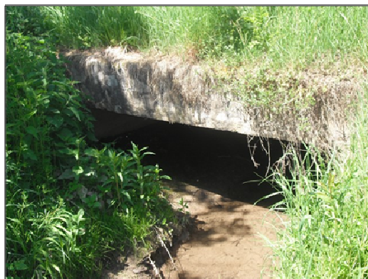
Figure 21 : Photographie de l'ouvrage OH_BOX_1
