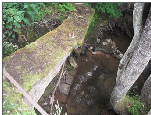
Figure 37 : Photographie de l'ouvrage OH_AIL_3 (amont)
