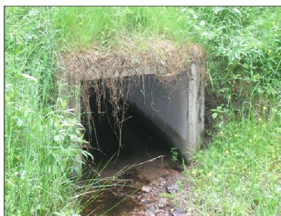
Figure 55 : Photographie de l'ouvrage OH_PRO_2 (amont)
