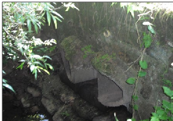
Figure 44 : Photographie de l'ouvrage Ail_1
