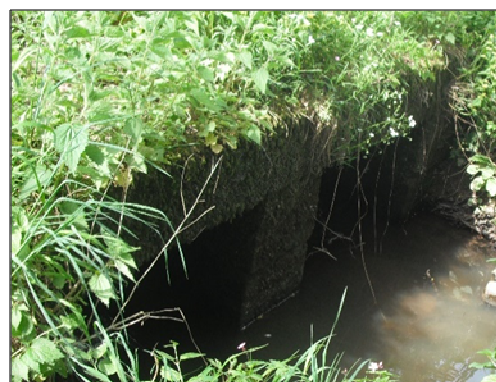
Figure 12 : Photographie de l'ouvrage OH_ETG_1
