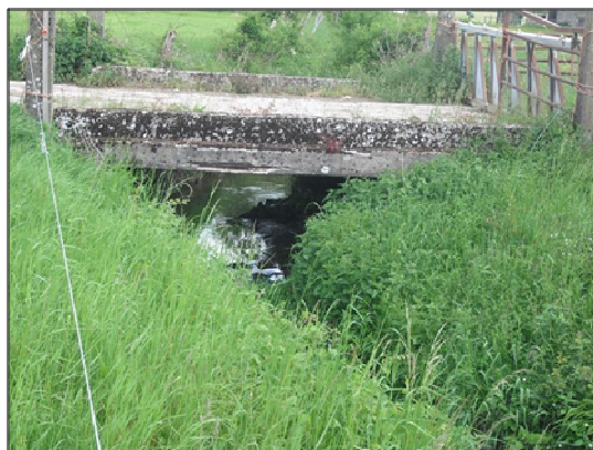
Figure 24 : Photographie de l'ouvrage OH_BOX_4
