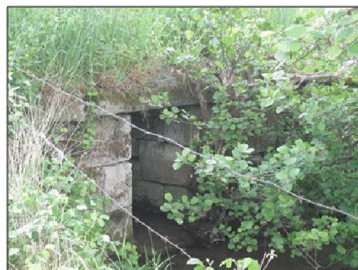
Figure 34 : Photographie de l'ouvrage OH_PAV_6
