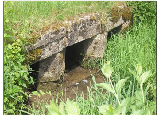
Figure 31 : Photographie de l'ouvrage OH_BRE_1
