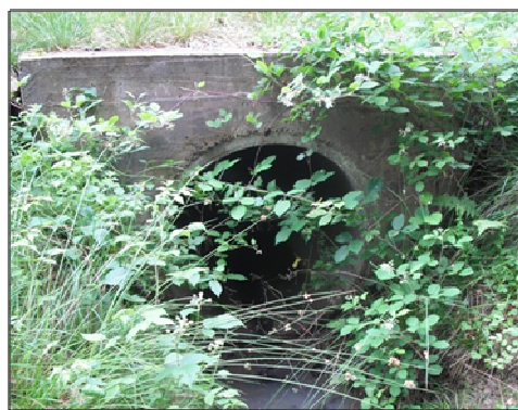
Figure 50 : Photographie de l'ouvrage Quf_2 (aval)
