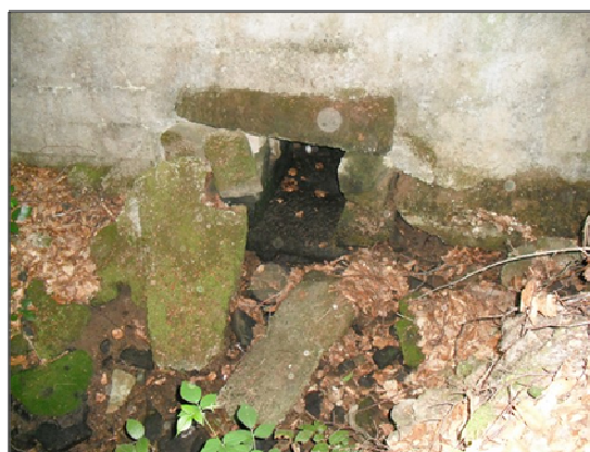
Figure 45 : Photographie de l'ouvrage Ail_2 (aval)
