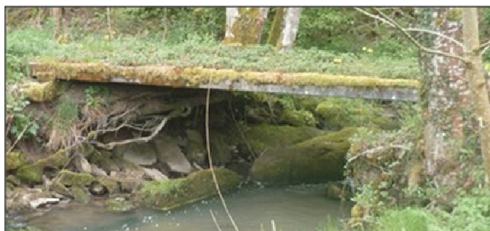
Figure 6 : Photographie de l'ouvrage Mou_1
