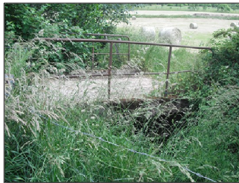
Figure 39 : Photographie de l'ouvrage OH_AIL_6 (aval)
