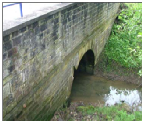
Figure 59 : Photographie de l'ouvrage OH_REG_1 (amont)
