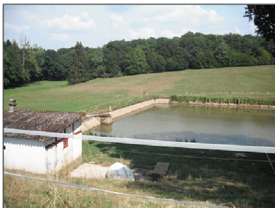
Figure 85 : Photographie de l'ouvrage ROE6965
