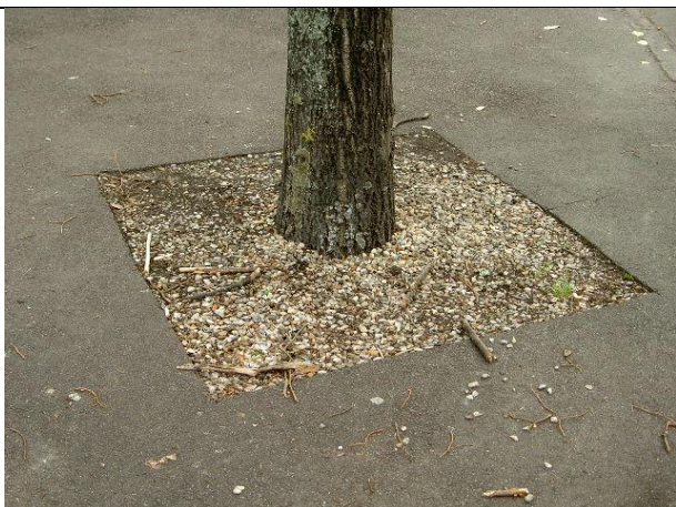
Pied d'arbre bétonné
