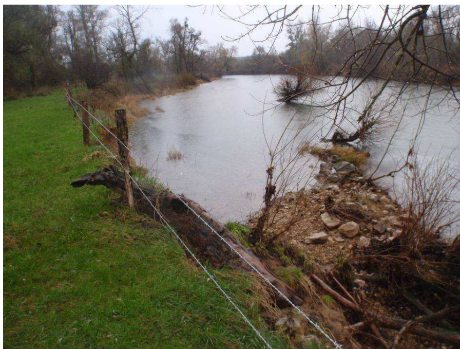
Vue générale de l'épi offensif. L'ensemble de la rive droite voit sédimenter des apports graveleux sur 15 à 20m de large et au moins 100m de long.
