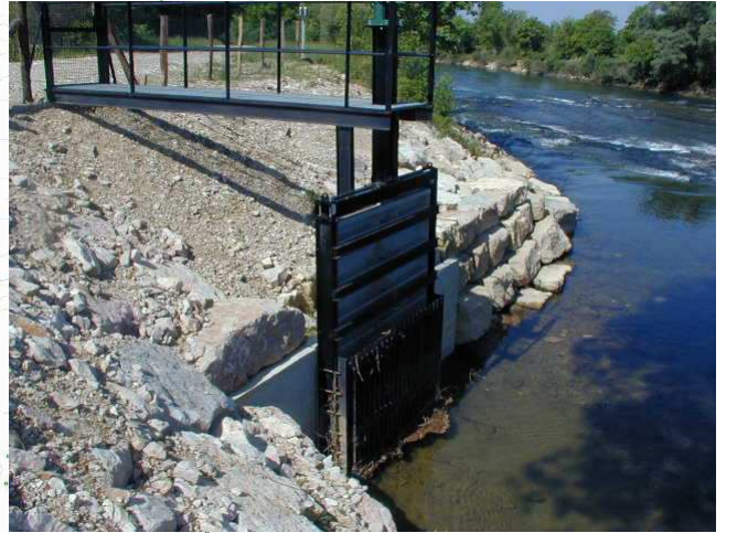
Vannage prise d'eau morte des Fontaines
