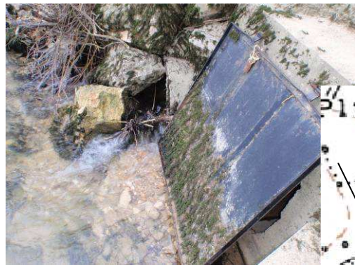
Poursuite du drainage de la morte par une buse située à côté du clapet
