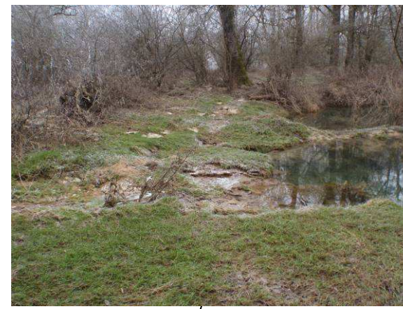
Aval immédiat d l'ancien barrage, déconnexion des deux mortes
