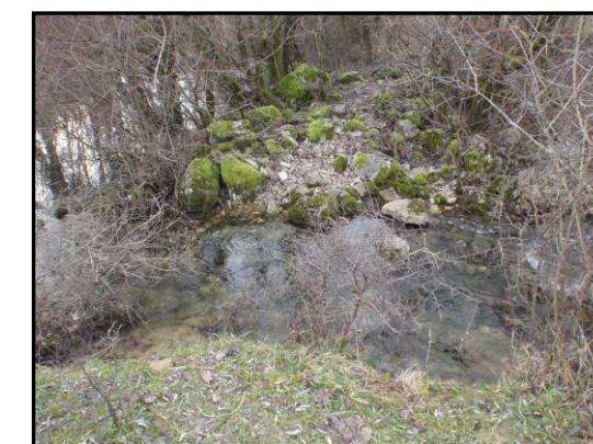
Brèche dans la digue accélérant le drainage de la morte Vieille rivière vers la morte du Pateau (environ 200 L/Sec)
