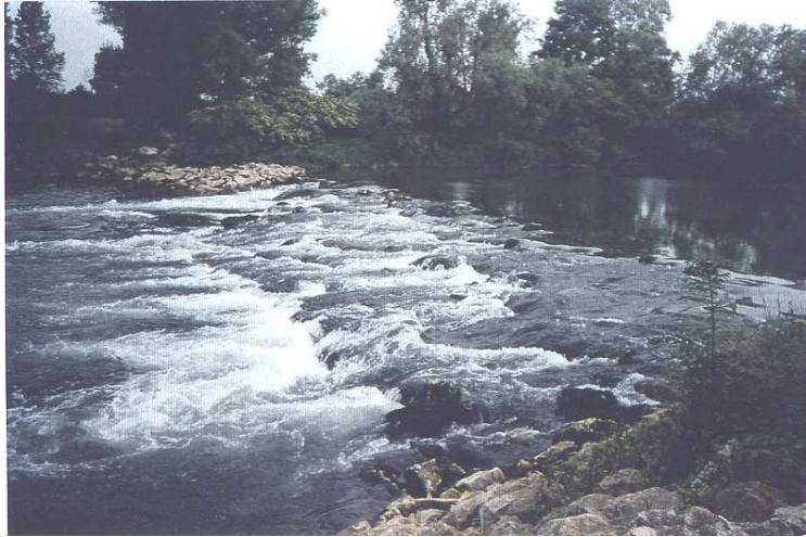
profil type d'un seuil « piscicole ». Photo Ipseau, 1996
