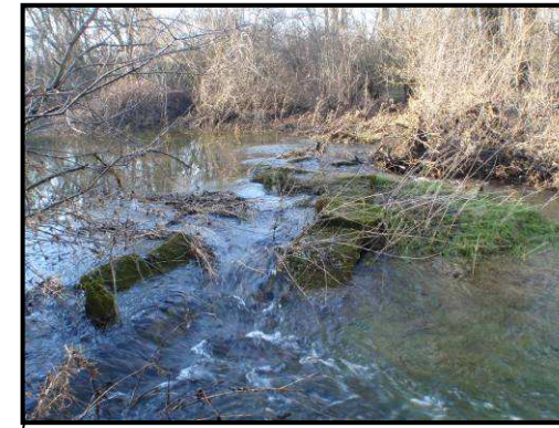
Ancien barrage effondré
