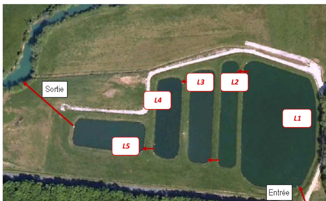
Figure 15 : Photo de la station d'épuration de Pontcey
