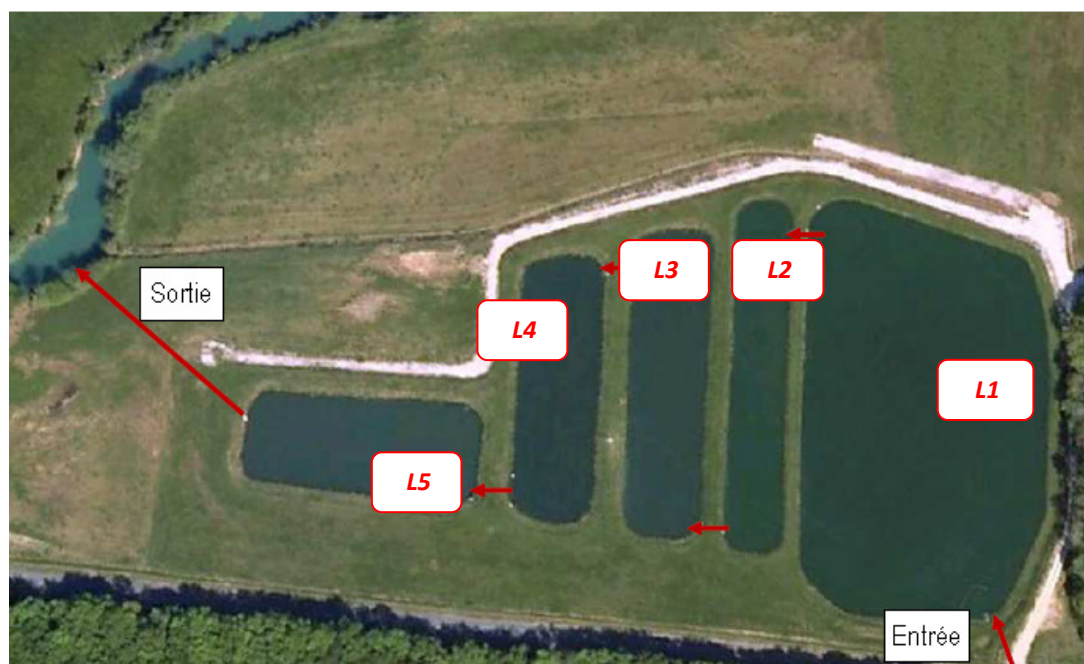
Figure 9 : Photo de la station d'épuration de Pontcey
