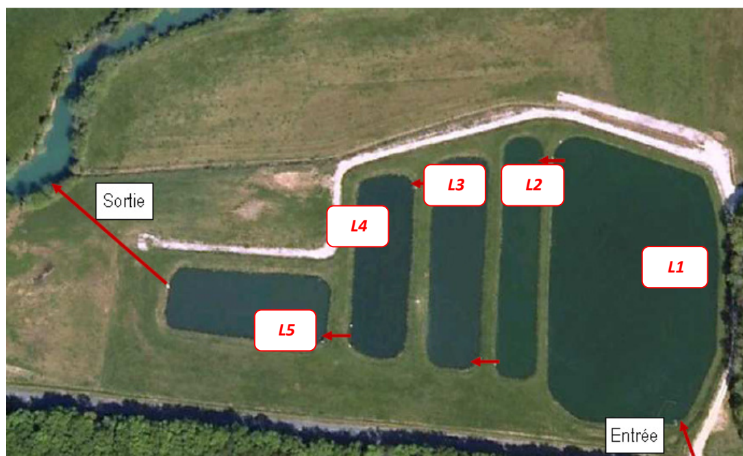
Figure 11 : Photo de la station d'épuration de Pontcey
