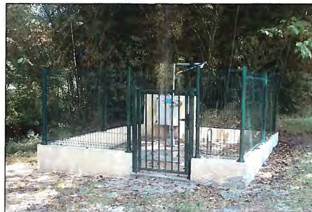
Vue extérieure avec clôture et portail
