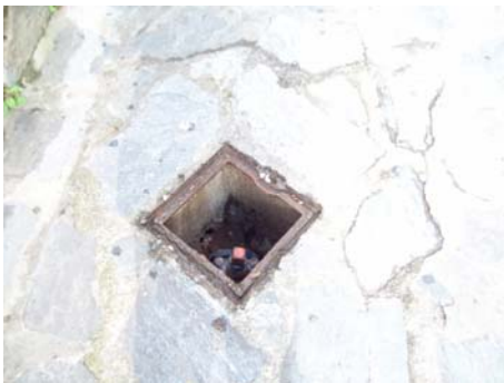
Figure 21 : Vanne de vidange de Pie
