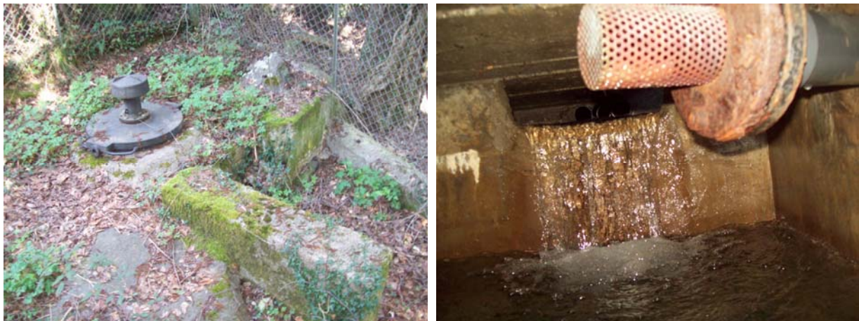
Figure 11 : Vues extérieure et intérieure de la source de Chiatta
