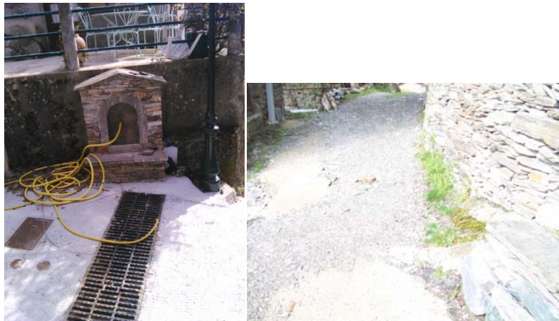
Figure 22 : Fontaine du village de Campodonico et vanne de sectionnement
