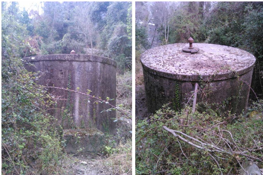
Figure 16 : Vues du réservoir de Pie-d'Orezza
