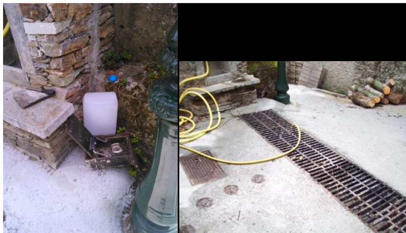
Figure 23 : Bouche à incendie et Vanne de vidange de Campodonico
