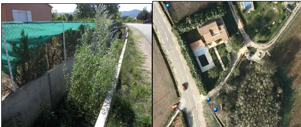
Photos 5: Exemple d'habitations en bordure immédiate du Soliès ou des arrosants
