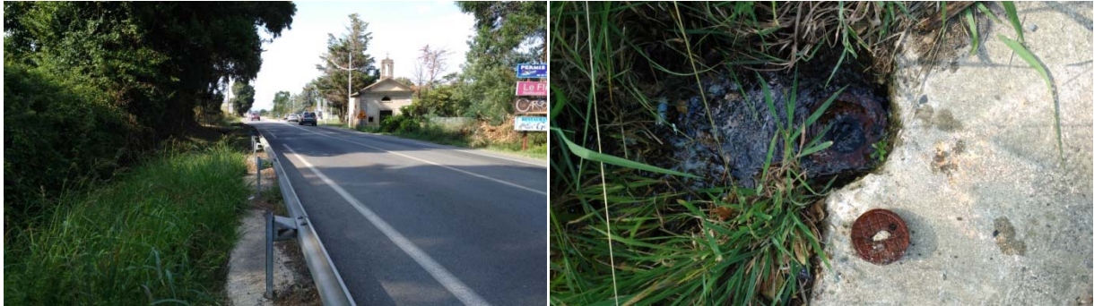
Photo 15 : Vanne fuyarde au pont du Botrangolo
