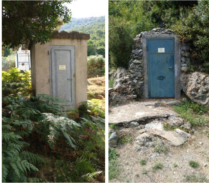
Photo 13 : Cabine de chloration des captages du Castellu d'Osari (Funtano et Argento) et de Fascheraccio (Funtanone et Piovanaccia)
