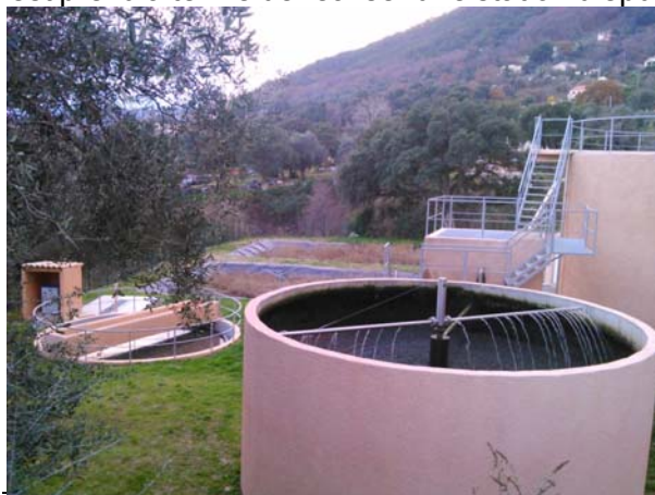
Photo 5 : Station d'épuration réhabilitée des villages de Cervione et de Valle di Campoloro
